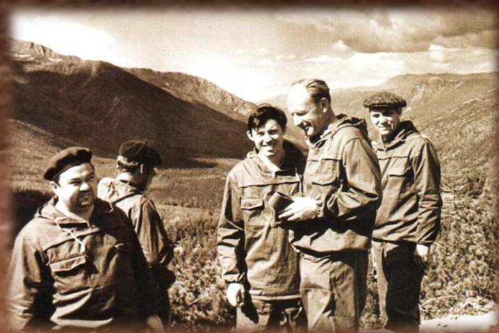
В районе Западного портала Северо-Муйского тоннеля
