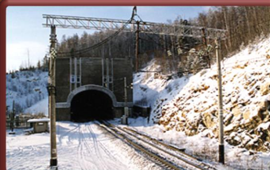
2-й Мысовый тоннель
