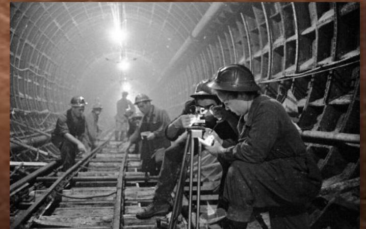
Маркшейдерский контроль в перегонном тоннеле
