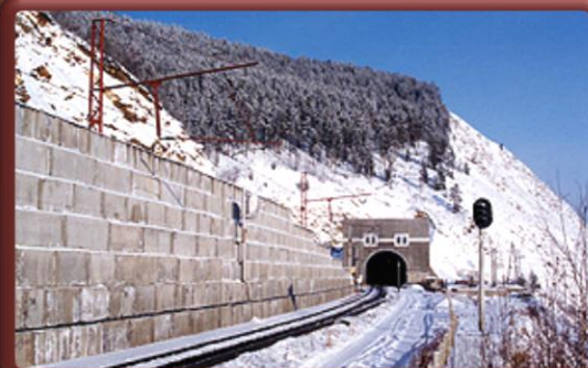
1-й Мысовый тоннель
