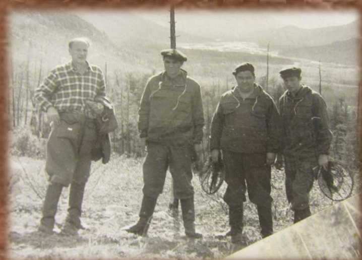
В районе Восточного портала Кодарского тоннеля
