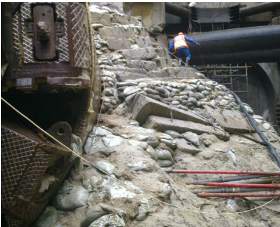
Рис. 2. Итоги противоаварийных мероприятий при прорыве плавуну в месте выхода ТПМК с трассы тоннеля в котлован
