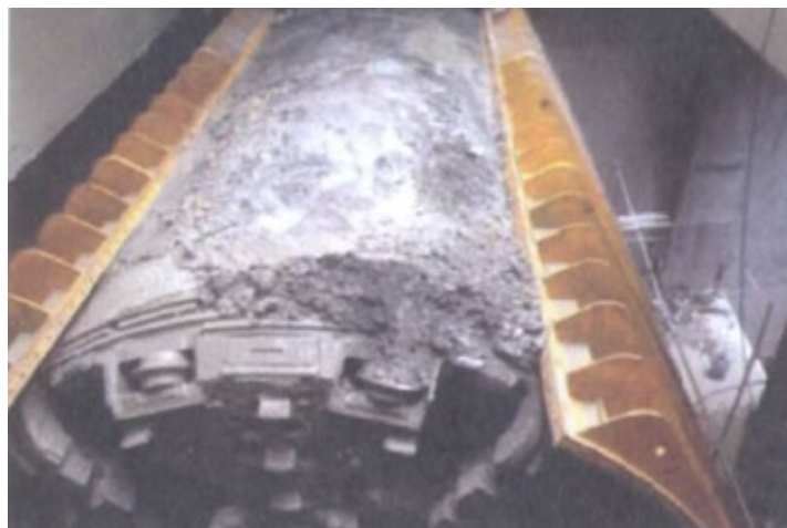
Рис. 10. Вскрытие и разборка инвентарного металлического контейнера после захода ТПМК и омоноличивания входного зазора тампонажным раствором
