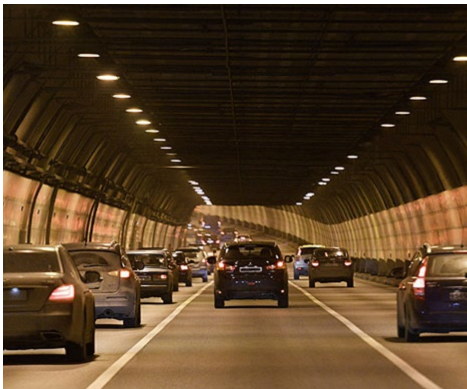
Рис. 3. Распределение LED-освещения в тоннеле [1]
