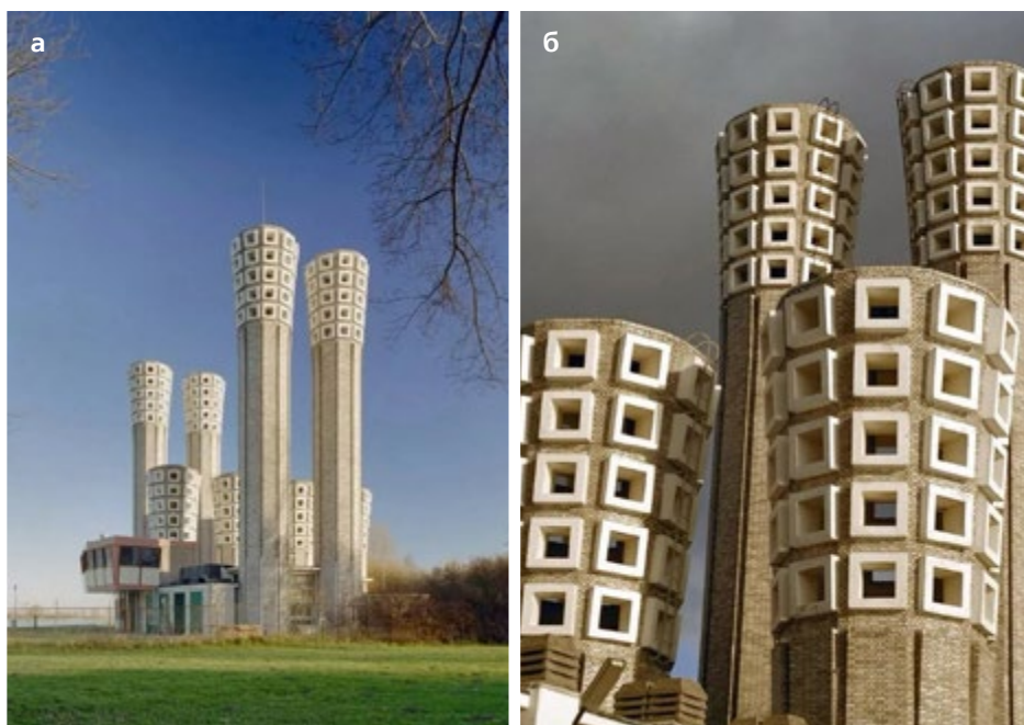
Рис. 24. Комплекс притоннельных сооружений тоннеля Вельзер в Нидерландах: а – общий вид; б – вентиляционные отверстия в башнях (из онлайн-энциклопедии «Википедия»)
