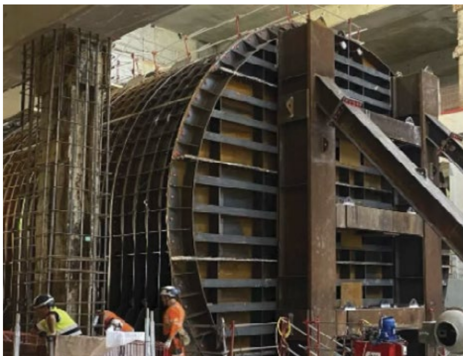
Рис. 11. Общий вид на полностью собранную металлоконструкцию для приема ТПМК (ниже УГВ)
