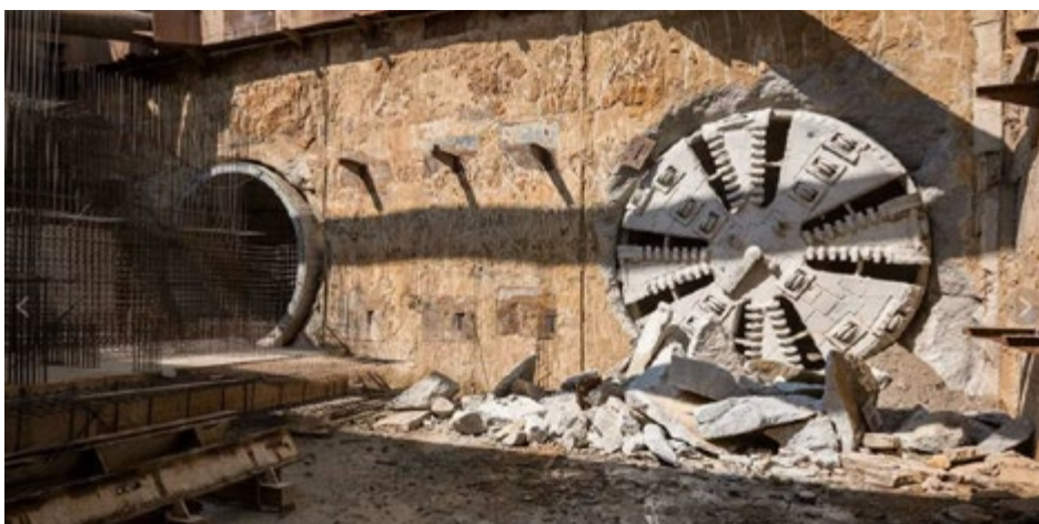
Рис. 3. Вывод ТПМК с трассы тоннеля, рядом имеется уже проложенный тоннель
