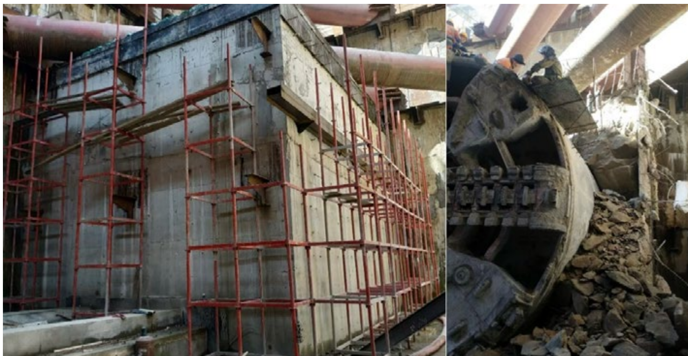
Рис. 8. Внутренний пригруз во время эксплуатации и демонтажа
