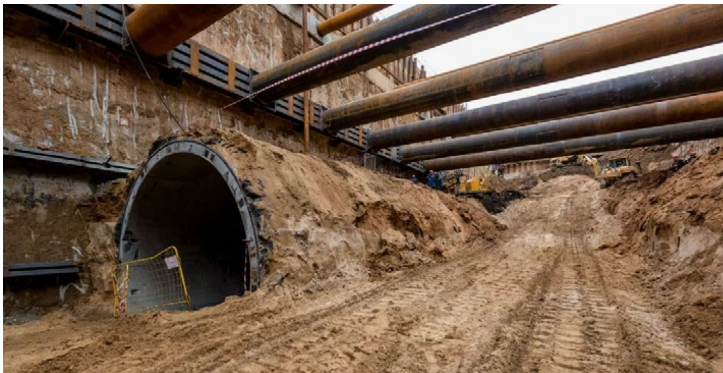
Рис. 5. Бросовые работы по разбору тоннельной обделки при разработке котлована
