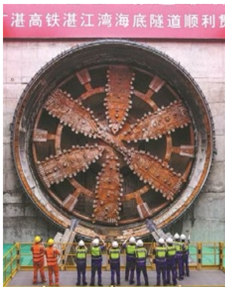
Рис. 2. Приемный котлован для щитового комплекса «Юнсин» при строительстве двухпутного железнодорожного тоннеля по трассе высокоскоростной магистрали Гуанчжоу – Чжаньцзян
