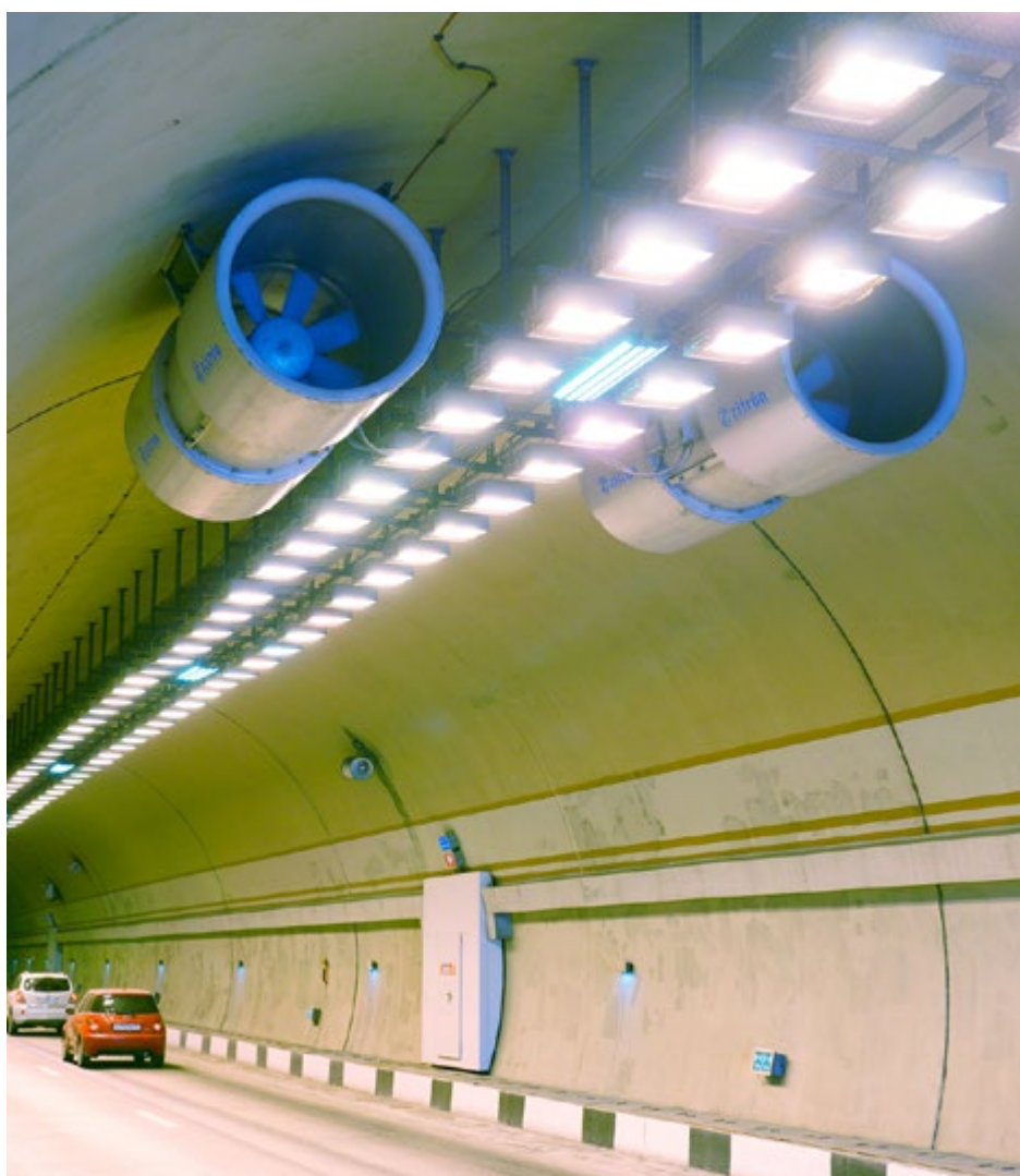
Рис. 4. Блок струйных вентиляторов в тоннеле [1]
