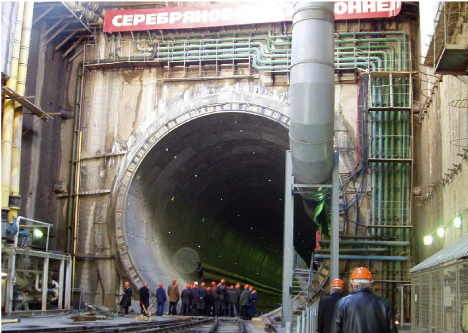
Обмен опытом сооружения Серебряноборских тоннелей глубокого заложения, архив ТАР
