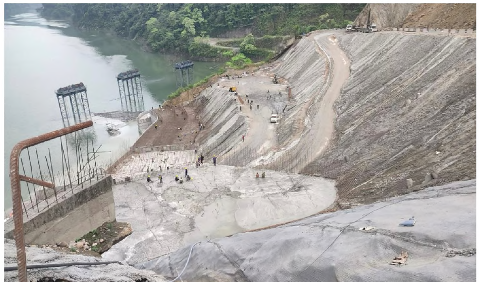
Устройство грунтовой упорной призмы в районе водоприемников строительных тоннелей
