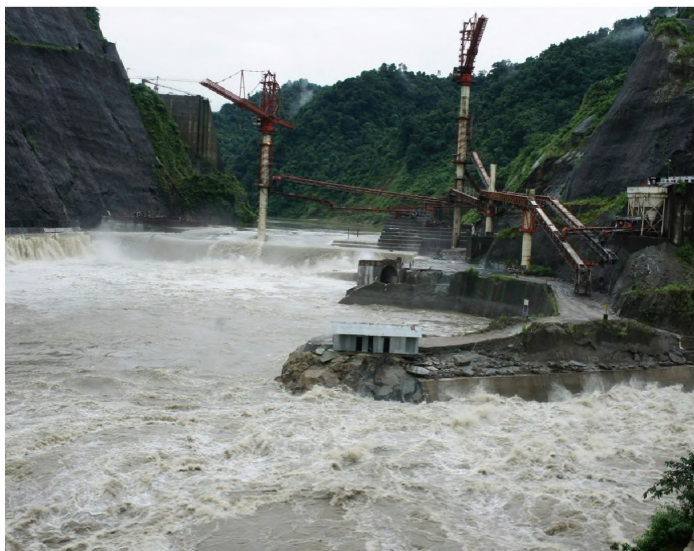
Пропуск паводка с расходом 9000 м 3 /с в июле 2011 г. через строительные тоннели и с напором 10–15 м через недостроенную плотину
