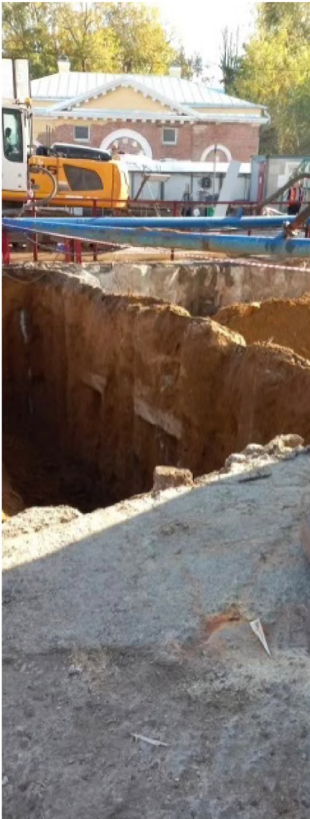
Рис. 3. Вид на Южный дом прича со стороны строительной площадки в начальный период разработки котлована для канала ВВУ
