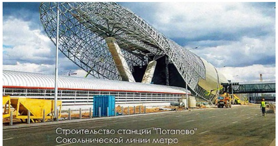
Строительство станции «Потапово» Сокольнической линии метро
