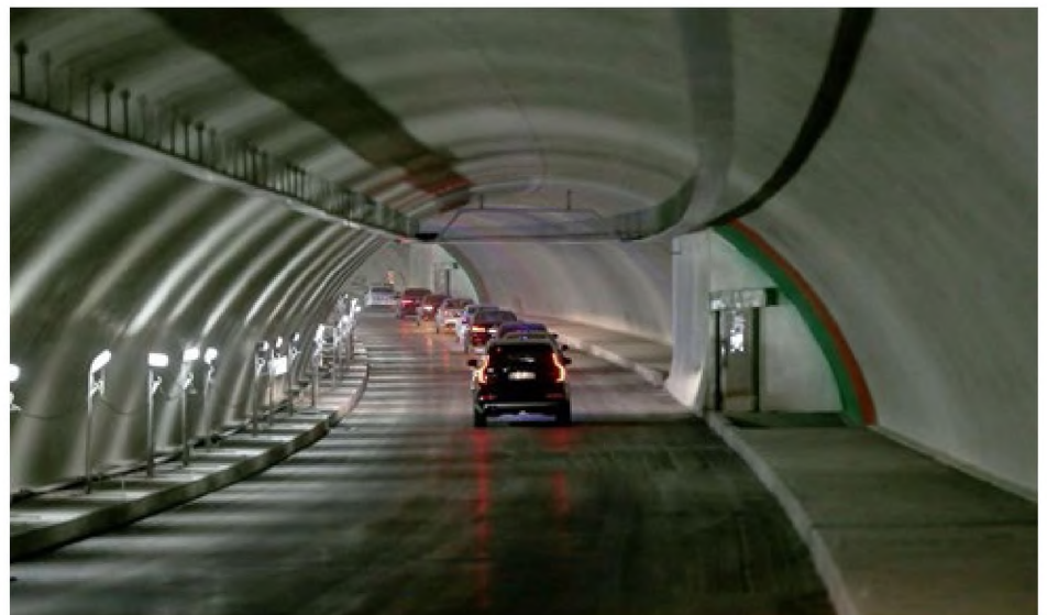
Рис. 4. Верхний ярус тоннеля Евразия для автомобильного движения из Европейской части Стамбула в Азиатскую
