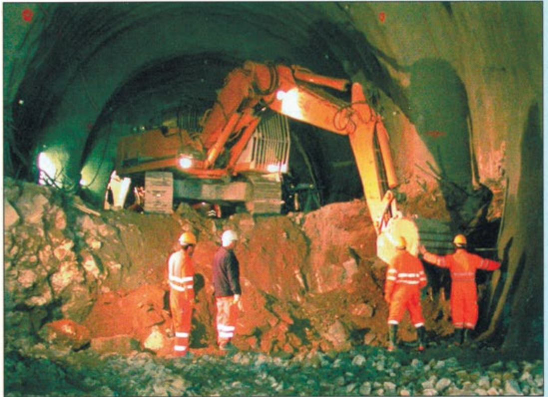
Рис. 40. Строительные работы в Бодио
