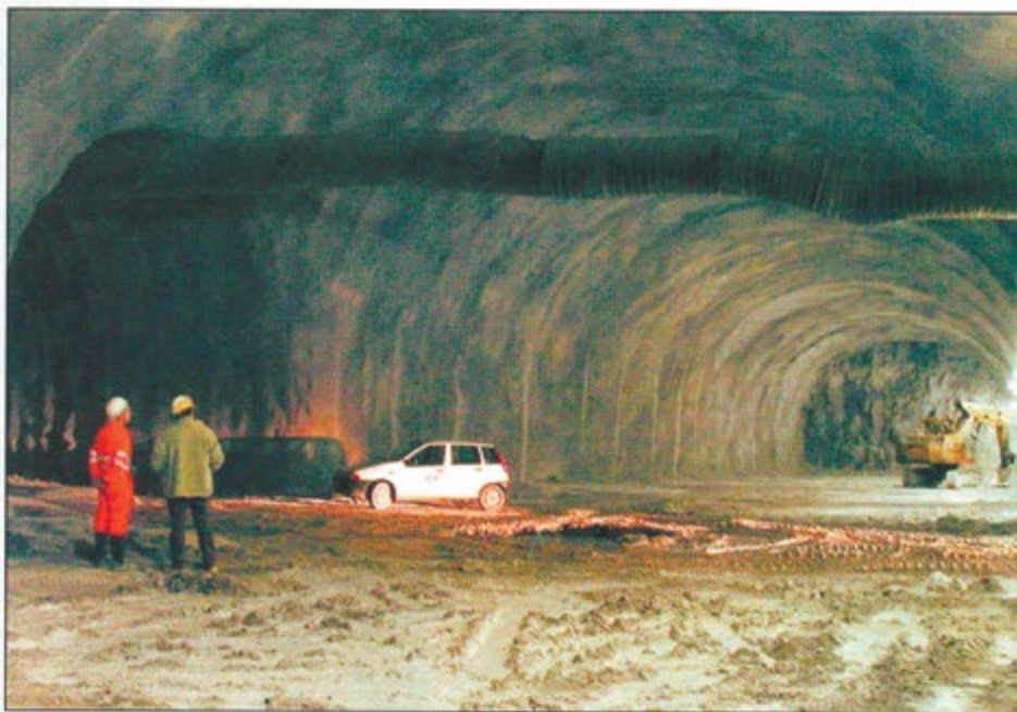
Рис. 28. Сигирино. Частично разработанная полость (рабочая выработка)
