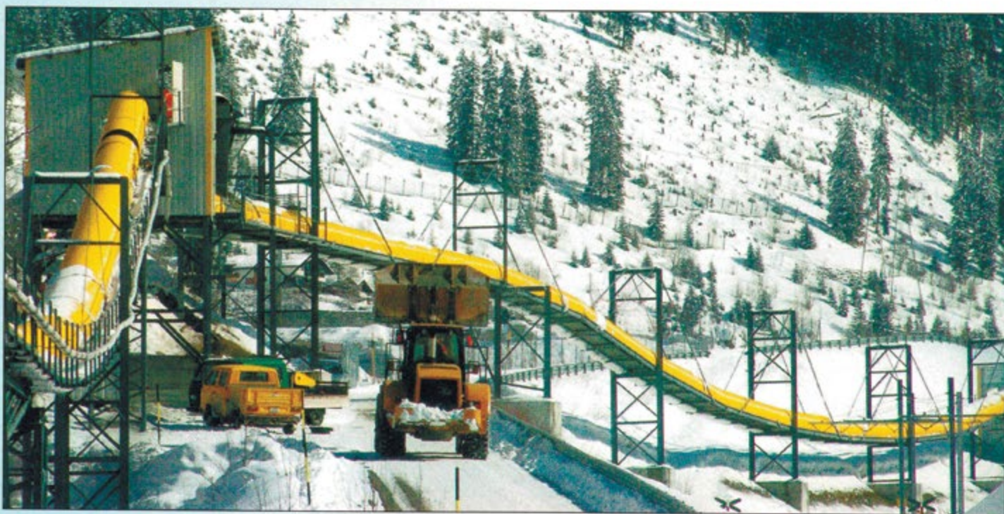
Рис. 41. Закрытый ленточный конвейер в Седруне
