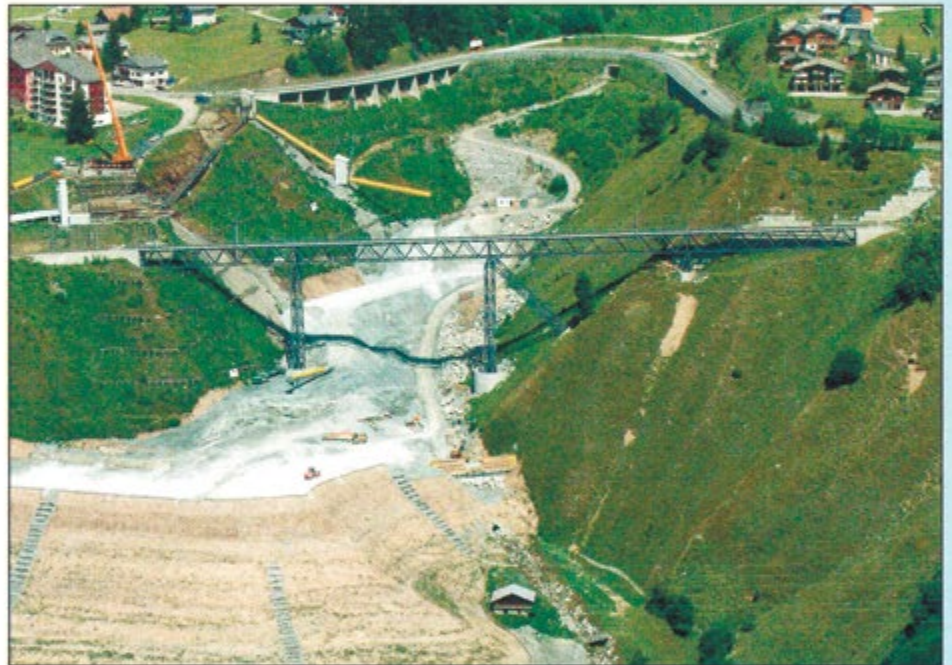
Рис. 30. Железнодорожный мост Валь Бугней, построенный специально для доступа к стройплощадке Седрун
