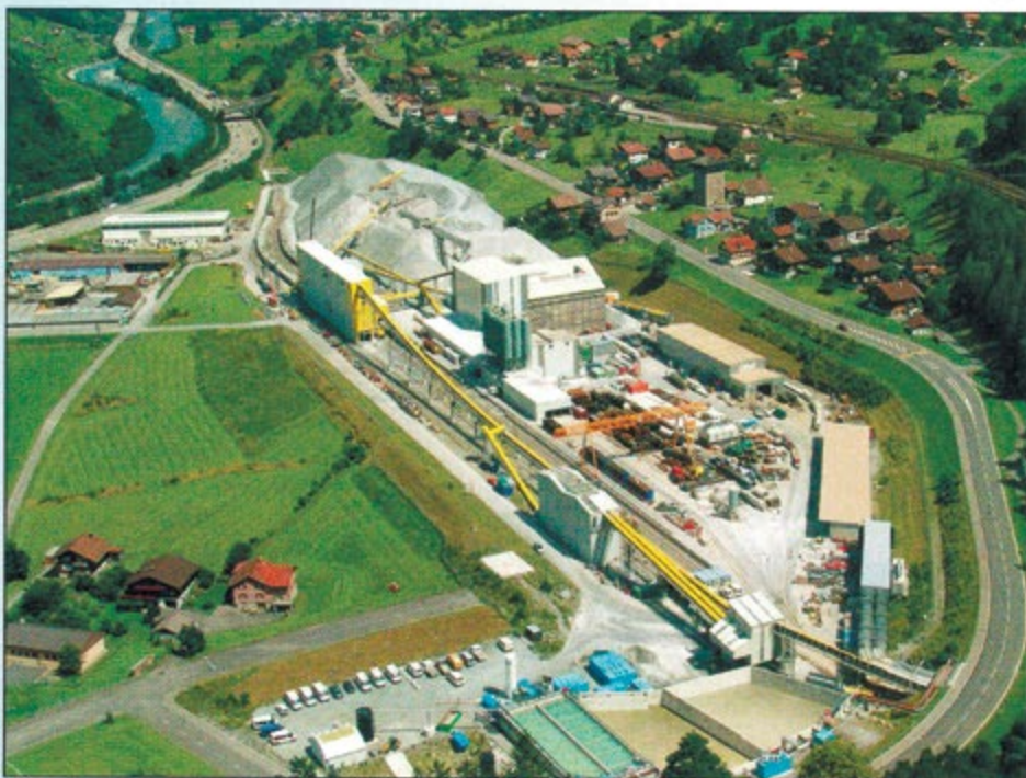
Рис. 19. Строительная площадка Амштег
