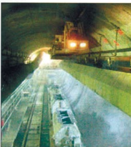
Рис. 21. Установка технического обеспечения и монорельс
