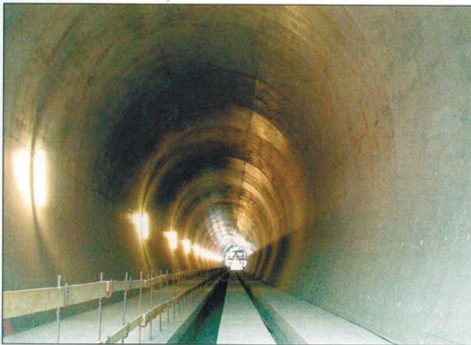
Рис. 50. Обделка тоннеля в Бодно
