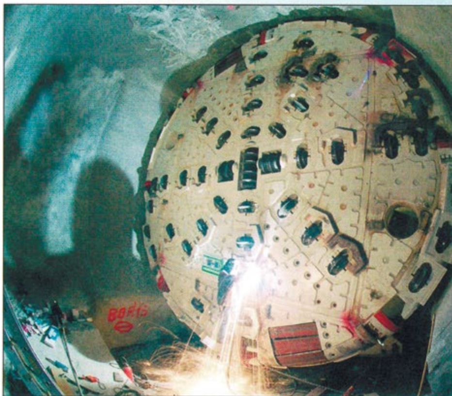
Рис. 33. Болто. Монтаж ТПМК S-210 фирмы Herrenknecht диаметром 8,83 м, работающего с упором в стены
