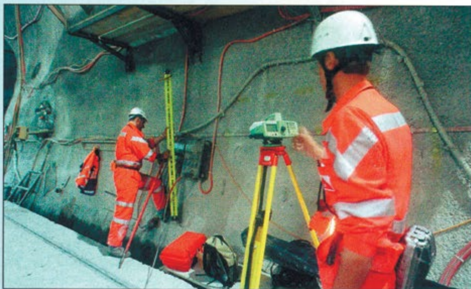
Рис. 32. Нивелирование в основании шахты в Седруне
