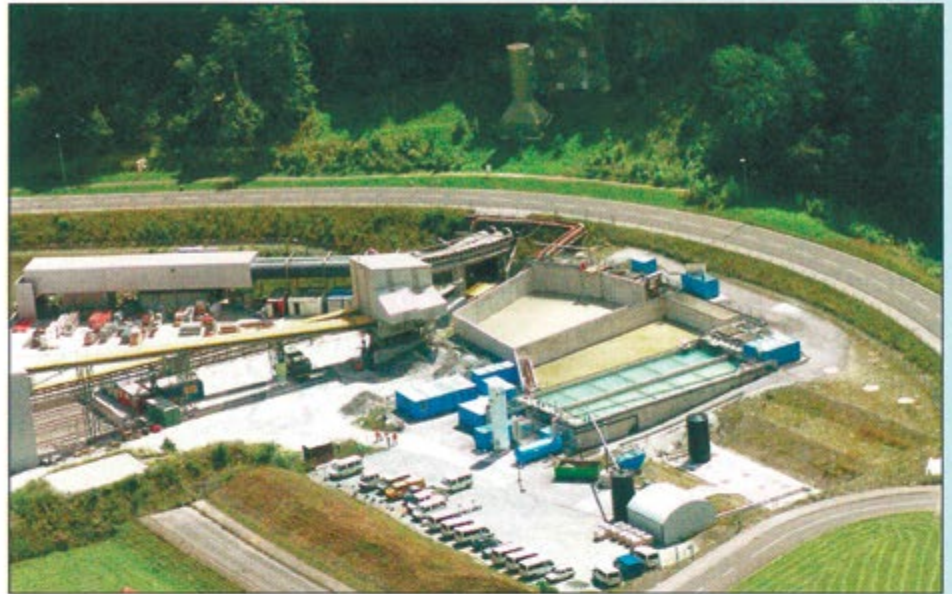
Рис. 29. Станция очистки воды в Амштеге
