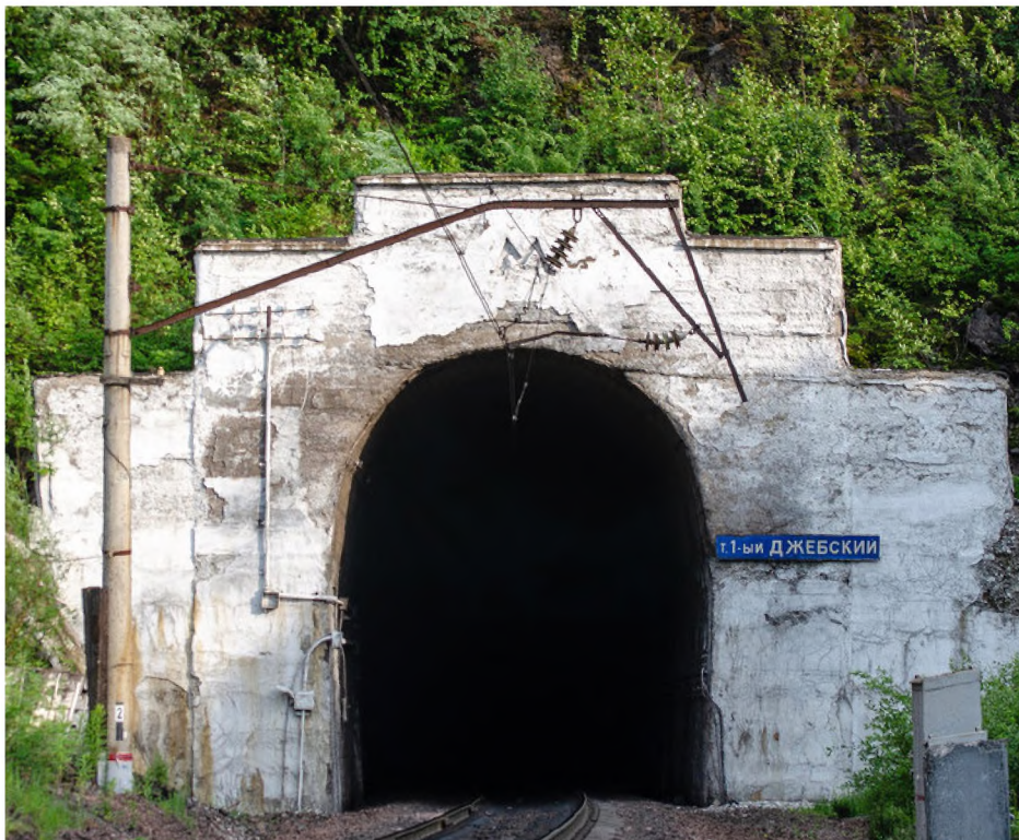
Рис. 1. Вид на Восточный портал существующего 1-го Джебского тоннеля
