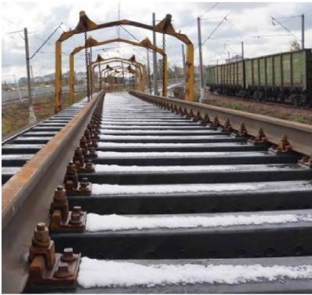
Рис. 6. Практическая проверка композитных шпал на экспериментальном кольце АО «ВНИИЖТ»
