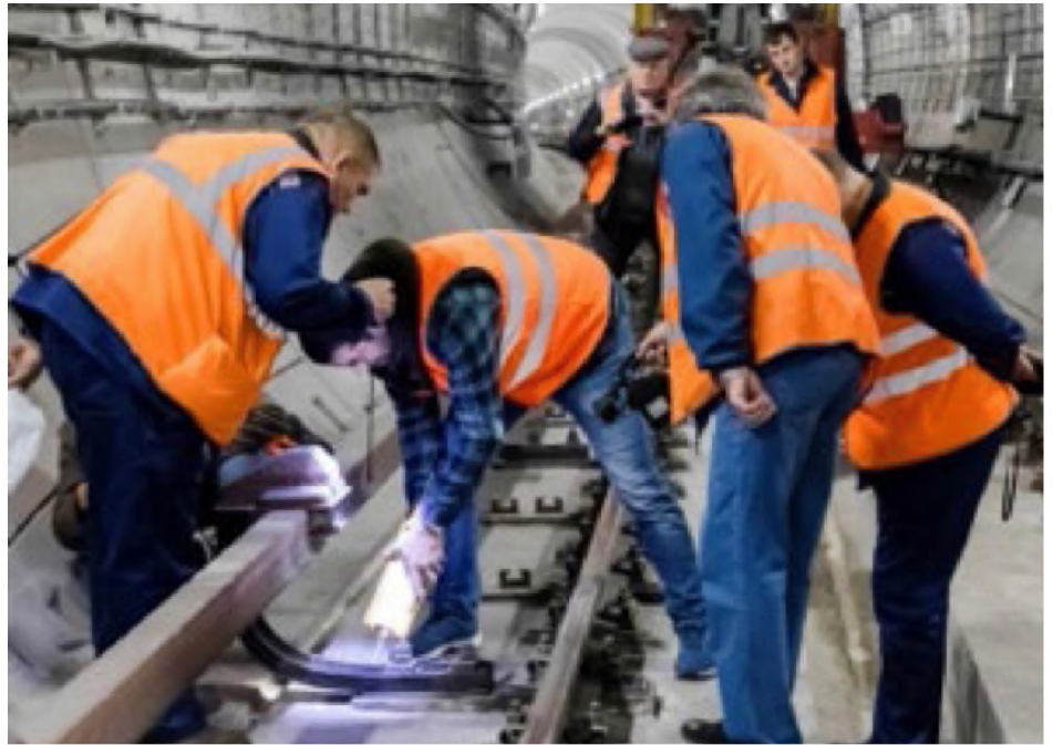
Рис. 10. Применение двухкомпонентной ремонтной смеси ДСРШ
