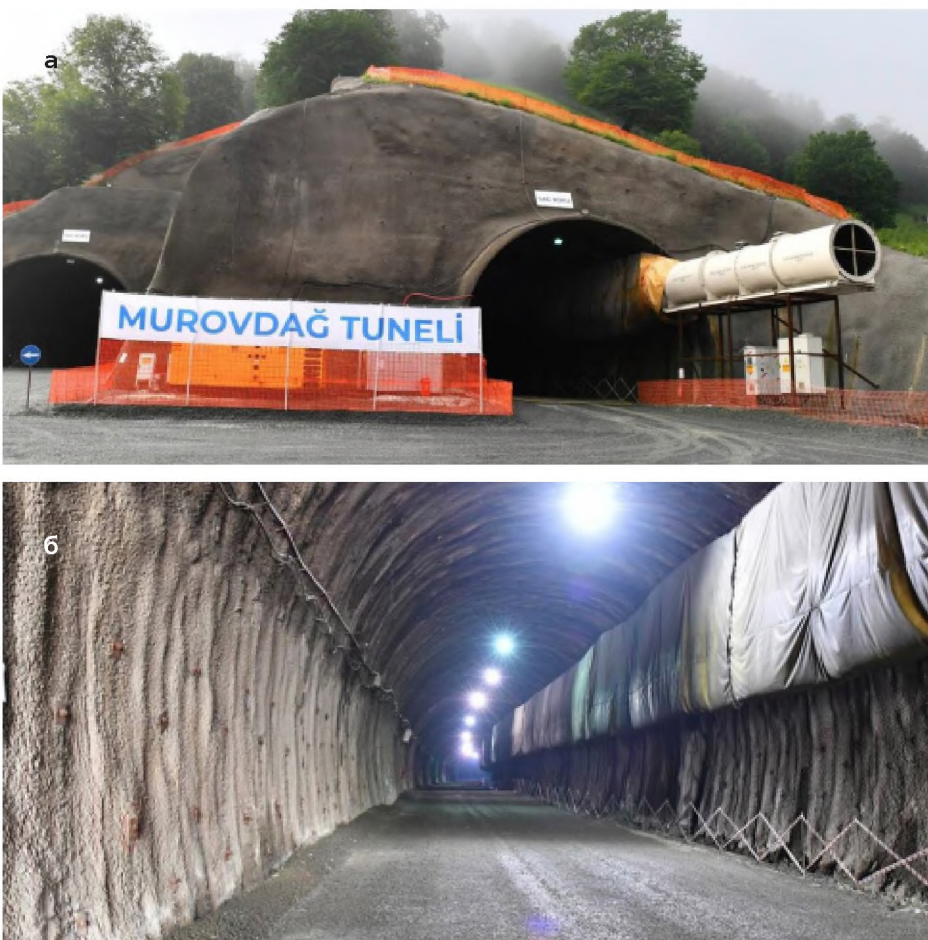
Рис. 4. Вид на портал (а) и поперечное сечение (б) строящегося Муровдагского тоннеля
