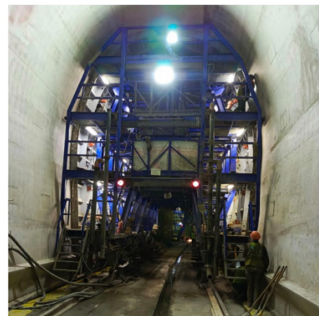
Рис. 11. Устройство постоянной обделки механизированной опалубкой «ГАММА»
