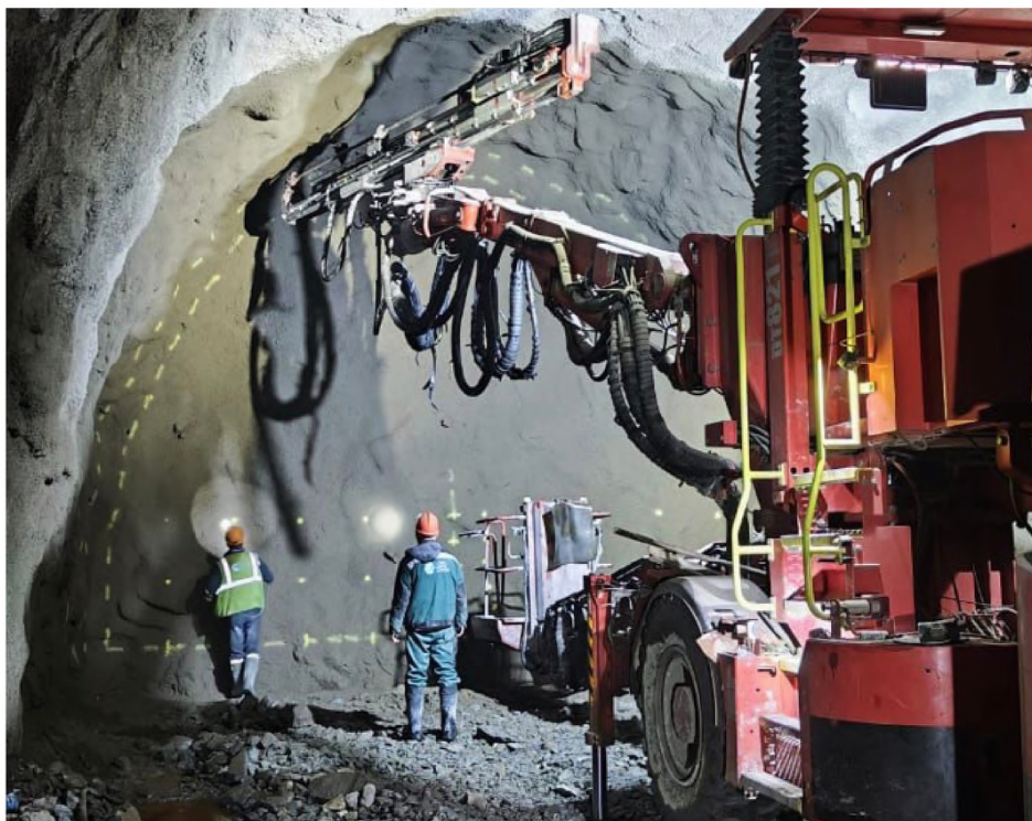
Рис. 7. Проходка буровзрывным способом верхнего уступа тоннеля
