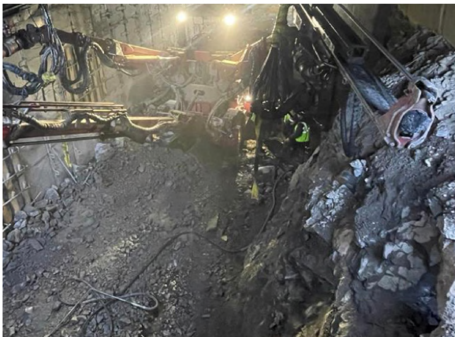
Рис. 8. Проходка нижнего уступа со стороны Восточного портала
