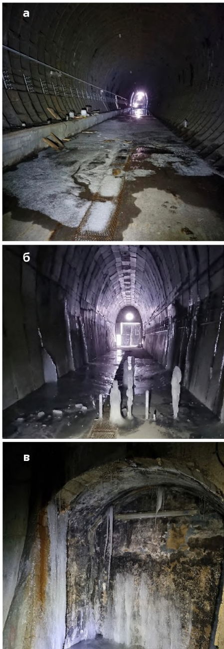
Рис. 2. Наледи в тоннеле: а – западный припортальный участок; б – восточный припортальный участок (сталактиты и сталагмиты); в – наледи в путевой камере на восточном припортальном участке
