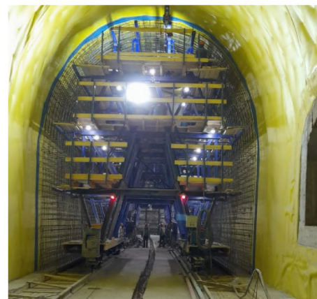
Рис. 10. Армирование постоянной обделки
