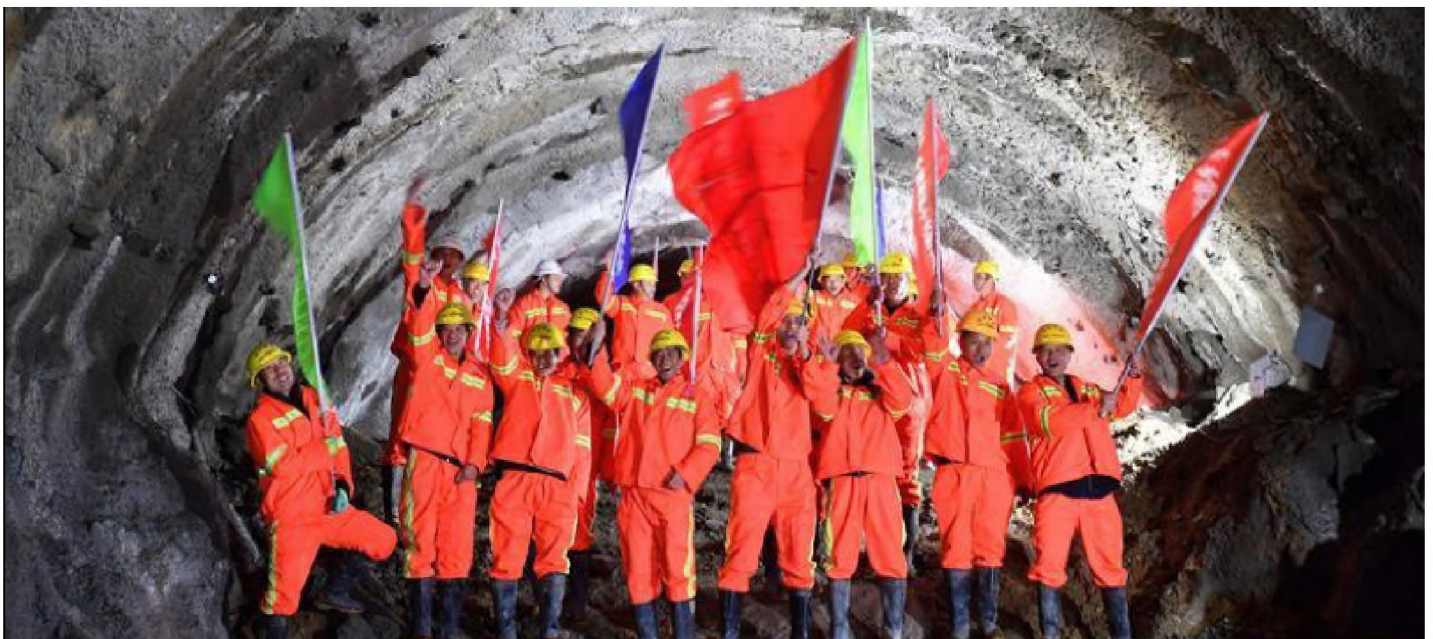
Рис. 1. Завершение работ по строительству тоннеля в провинции Цинхай Тибетского автономного округа
