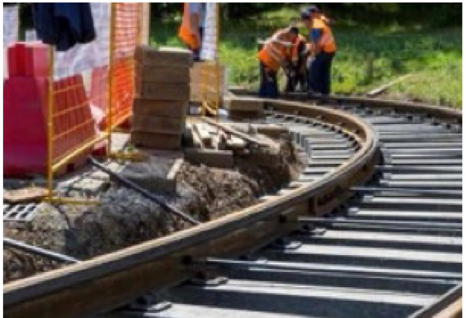
Рис. 8. Опыт эксплуатации композитных шпал
