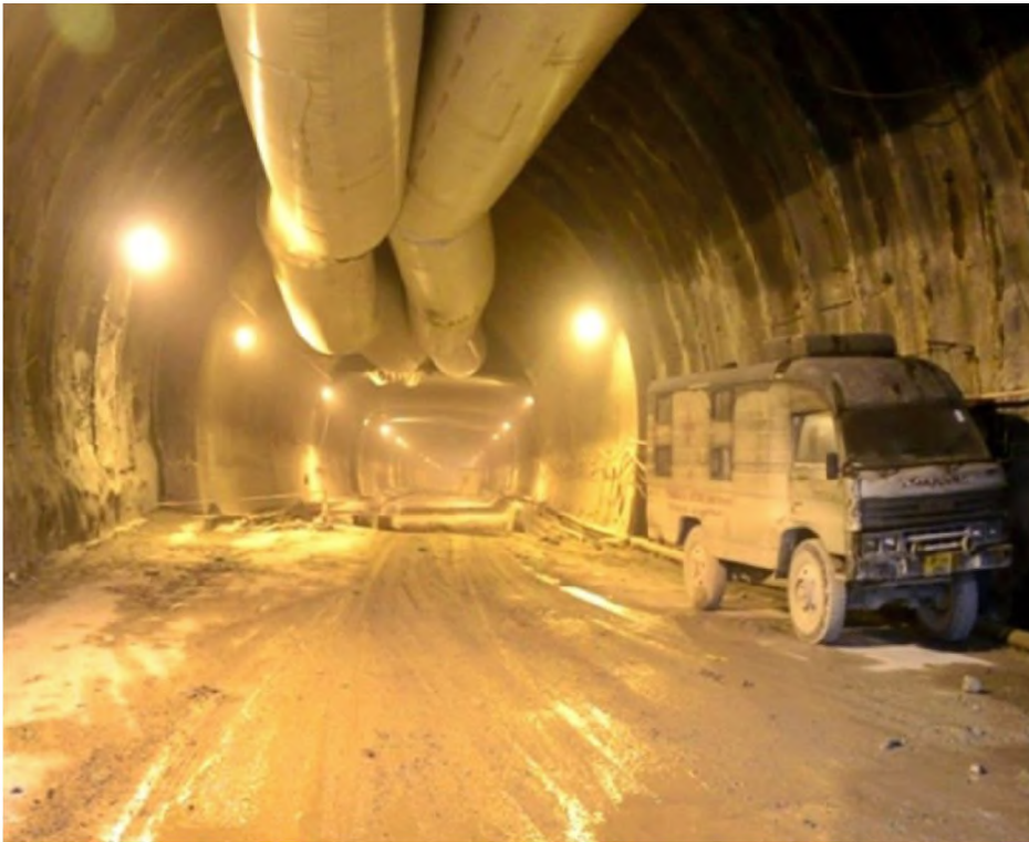
Рис. 2. Сооружение высокогорного тоннеля через хребет Пир Панджал в штате Химачал – Прадеш в Гималаях
