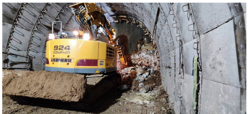
Рис. 6. Механизированная проходка верхнего уступа тоннеля
