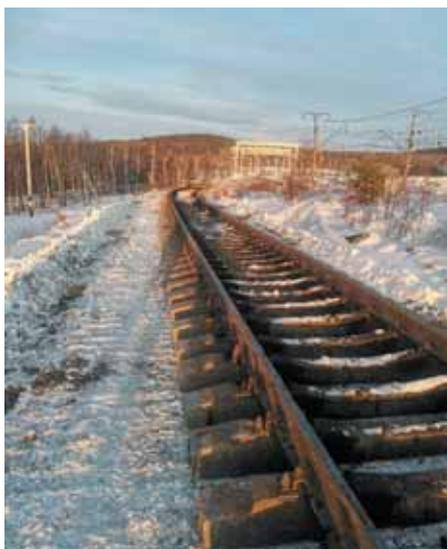
Рис. 4. Железнодорожные пути, построенные по технологии LVT
