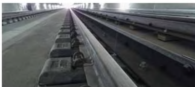
Рис. 6. Готовый железнодорожный путь в новом Керакском тоннеле
