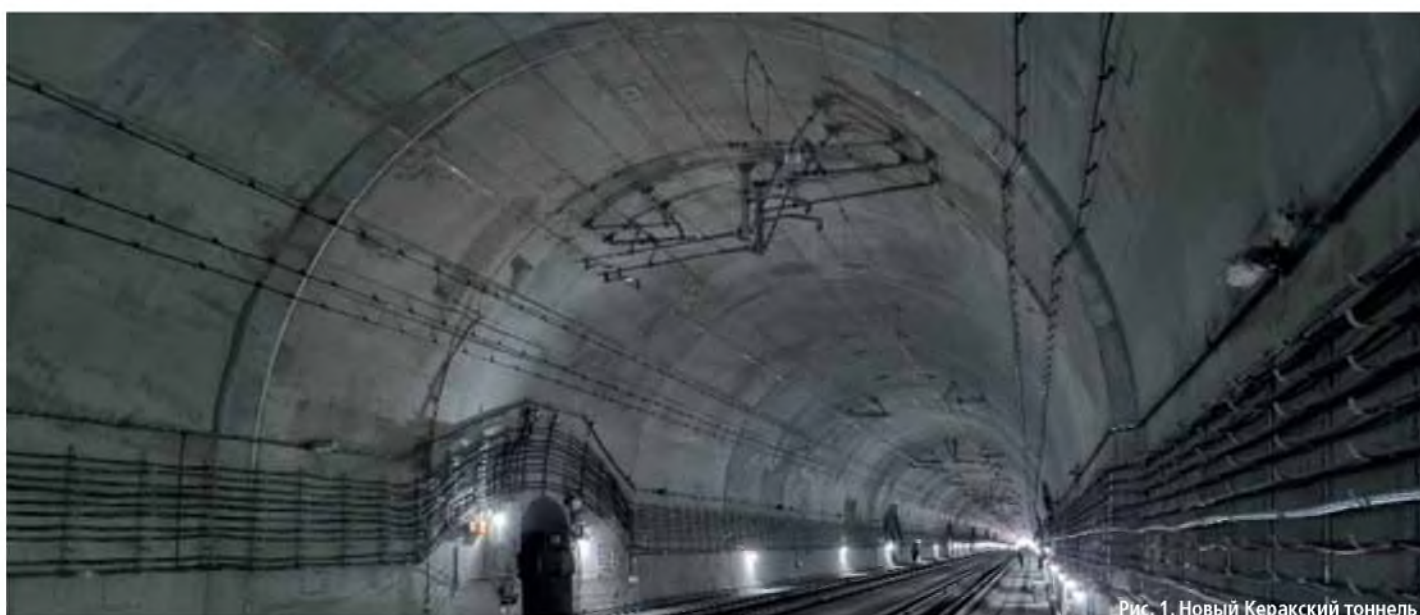
Рис. 1. Новый Керакский тоннель
