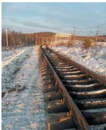
Рис. 4. Железнодорожные пути, построенные по технологии LVT
