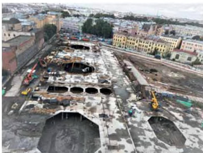
Рис. 4. Строительство подземной части здания с использованием системы Top-Down при строительстве административного здания на застроенной площадке в центральной части Санкт-Петербурга
