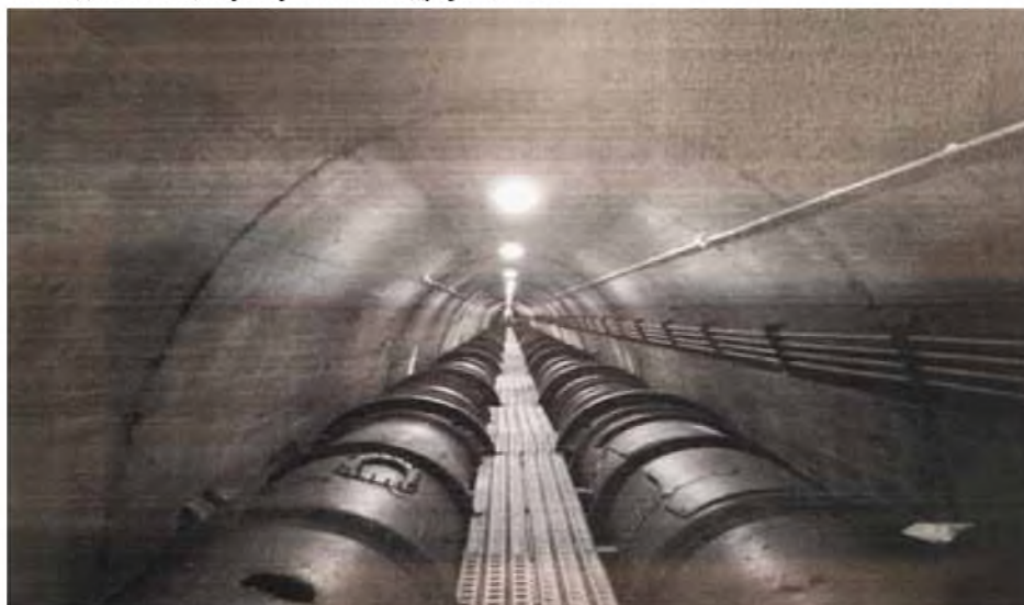
Рис. 5. Донный водоспуск Тушинского гидроузла, 1937 г.
