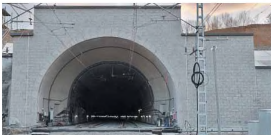
Рис. 2. Портал Нового Керакского тоннеля
