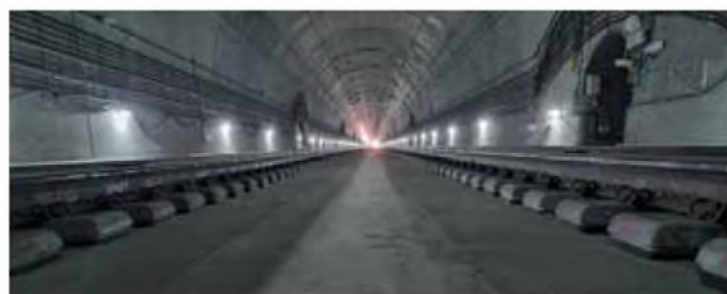
Рис. 5. Схема конструкции железнодорожных путей по технологии LVT
