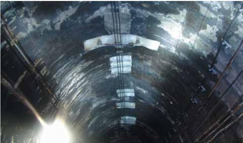
ционными швами формируются капез и струйные течи. В связи с проникновением подземной воды через обделку её внутренняя поверхность практически полностью увлажнена и покрыта продуктами выщелачивания цементного камня. Для защиты контактного провода в местах поступления воды на обделке закреплены металлические защитные экраны, а в местах подвески контактной сети экраны из диэлектрического материала (рис. 5).
