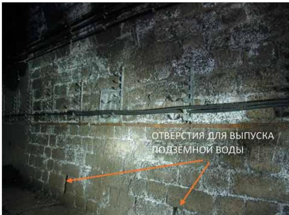
**Рис. 2.** Кладка обделки с отверстиями в основании стен для выпуска подземной воды
