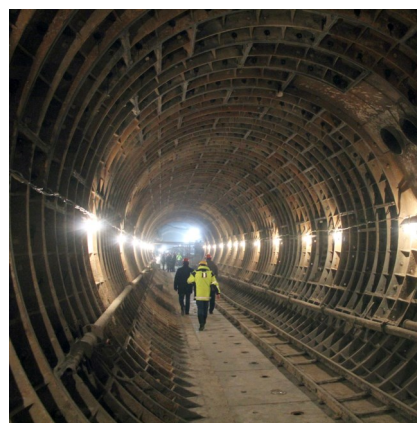
Перегонный тоннель после реконструкции
