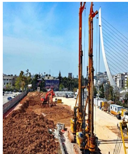
Строительство Линии № 4 метрополитена г. Афины
