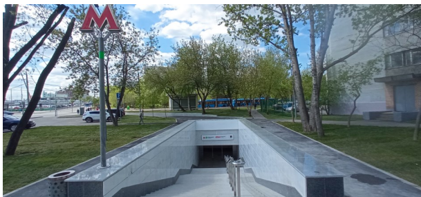
Дополнительный выход из южного вестибюля станции «Царицыно»
