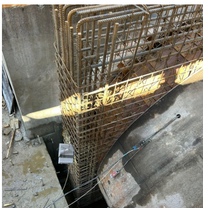
Монтаж армокаркаса узла сопряжения перегонных тоннелей
