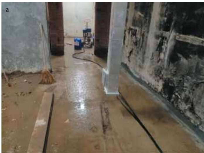
Рис. 7. Ремонт гидроизоляции горизонтального деформационного шва
