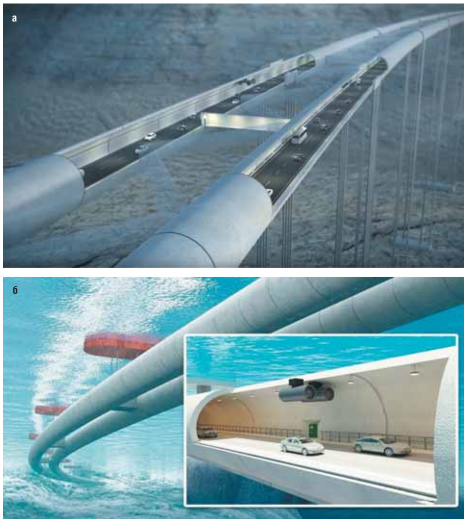
Рис. 6. Проект подводных «плавающих» тоннелей в Норвегии, закрепленных на дне фиорда (а) или на массивных понтонах (б)
