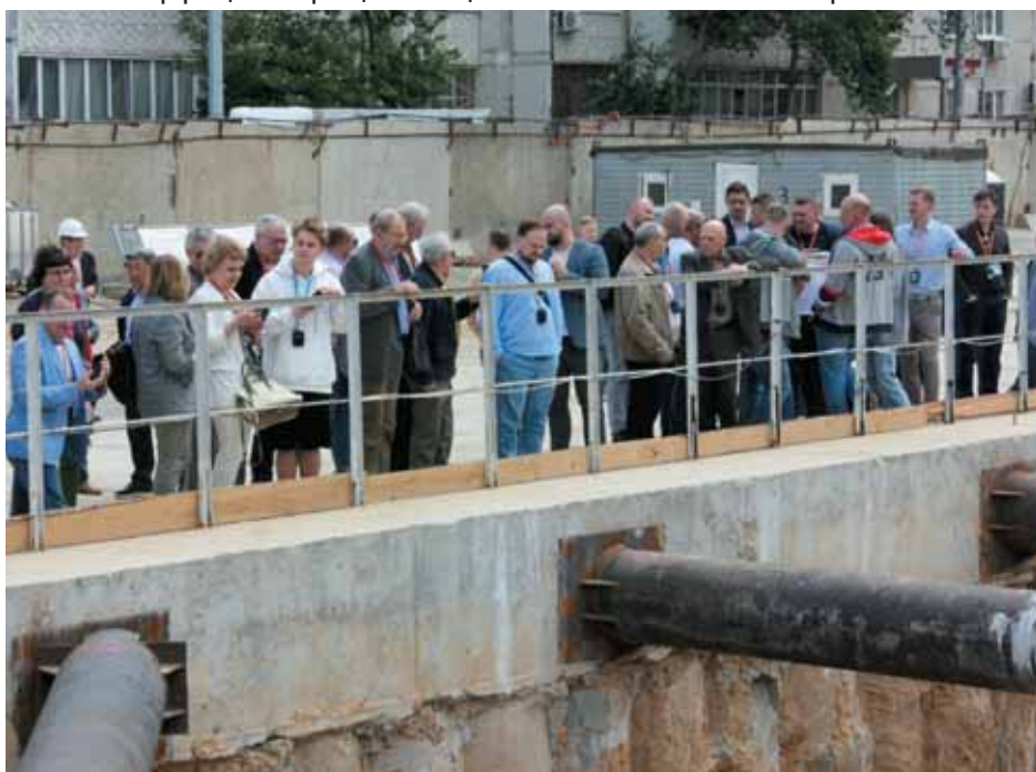
Участники конференции на строящейся станции «100 лет ТАССР» Казанского метрополитена
