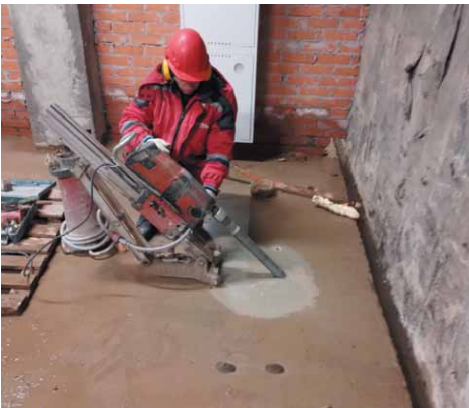
Рис. 6. Контрольное бурение верхней скважины
