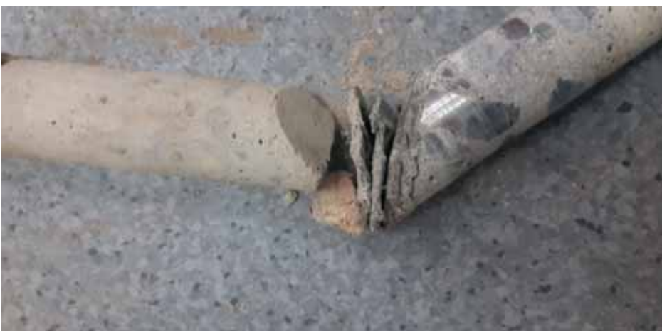
Рис. 5. Фрагмент четырех слоев гидроизоляции из керна верхнего шпура
