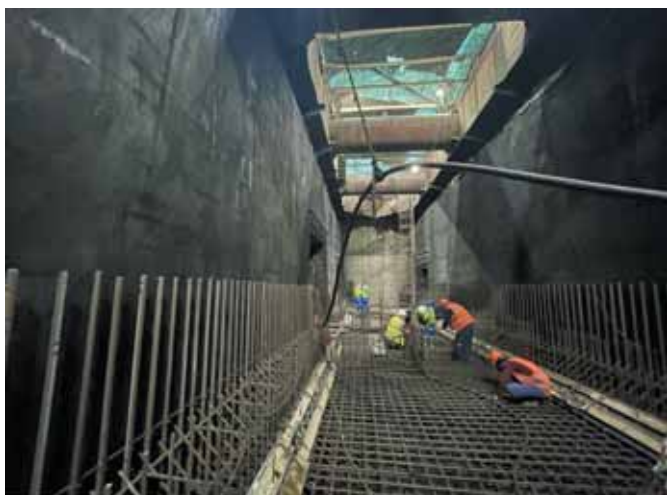
Рис. 2. Вязка арматурного каркаса над напыляемым гидроизоляционным покрытием с двусторонней адгезией с упрочненным поверхностным слоем из геотекстильного полотна и без защитного слоя из мелкозернистого бетона
