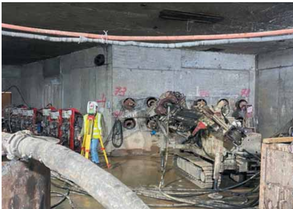
Рис. 4. Горизонтальное бурение с заполнением затрубного пространства обойменным раствором
