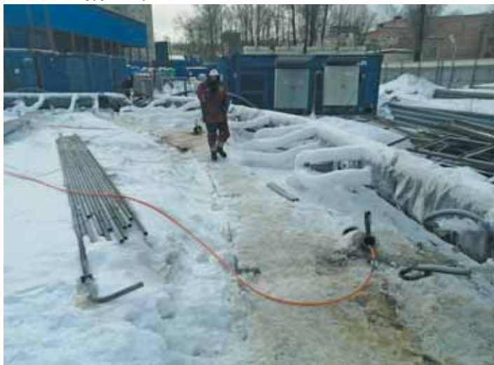
Рис. 1. Изображение приемной и излучающей скважин при производстве МСП по контуру замораживания
