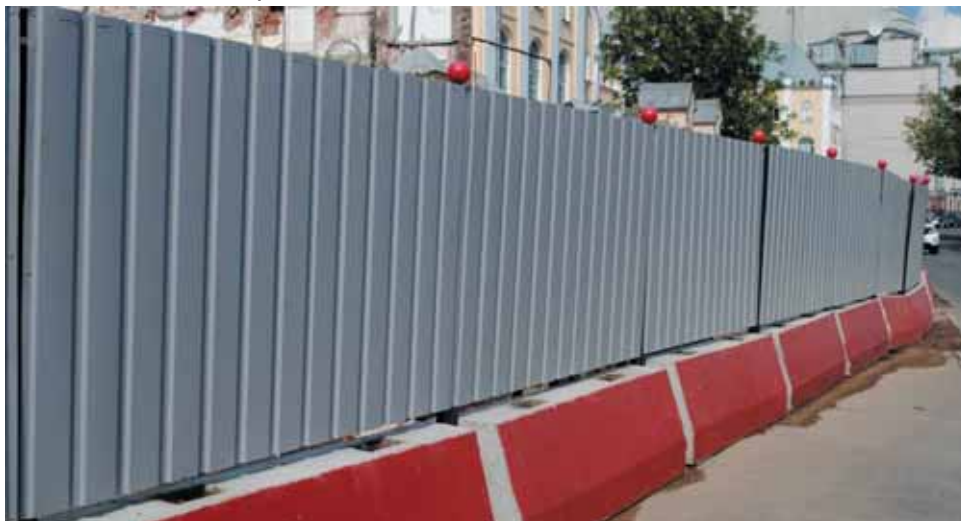
Рис. 6. Металлический забор с бетонным основанием
