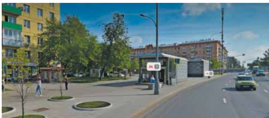
Рис. 9. Наземный выход из метро после реконструкции. Станция «Академическая», 2021 г.
