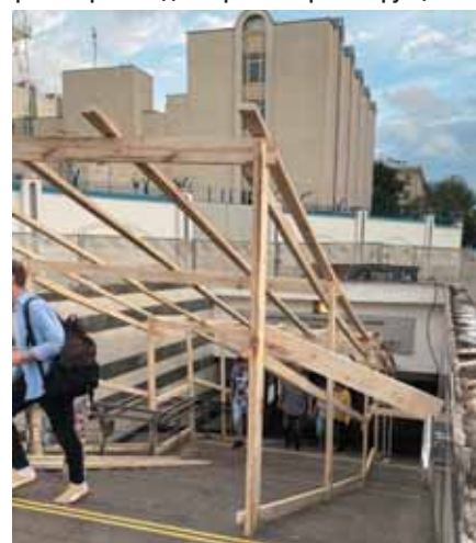
Рис. 7. Сооружение пенала для прохода пассажиров во время ведения работ по реконструкции
