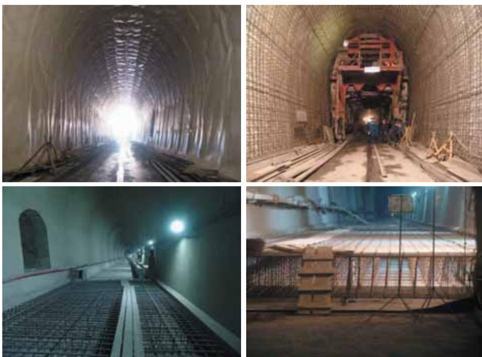
Рис. 3. Установка гидроизоляции и арматуры
