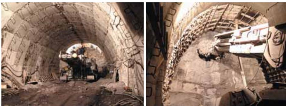
Рис. 1. Механизированная разработка породы
