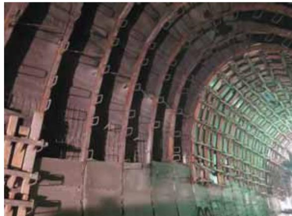
Рис. 6. Консервация тоннеля. Усиление обделки
