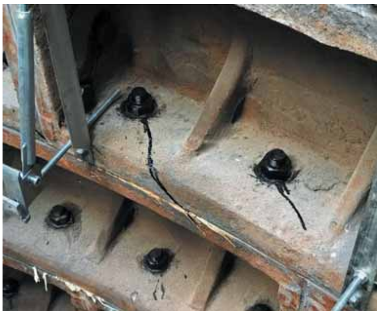
Рис. 1. Пример выполненных работ по инъектированию стыковых соединений полиуретановыми смолами фирмы BASF и Normet
