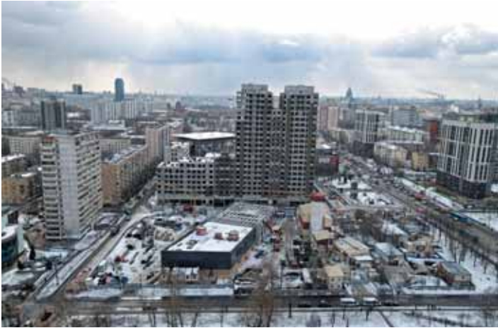
Общий вид на строящийся вестибюль станции «Марьяна Роща» Большой кольцевой линии
