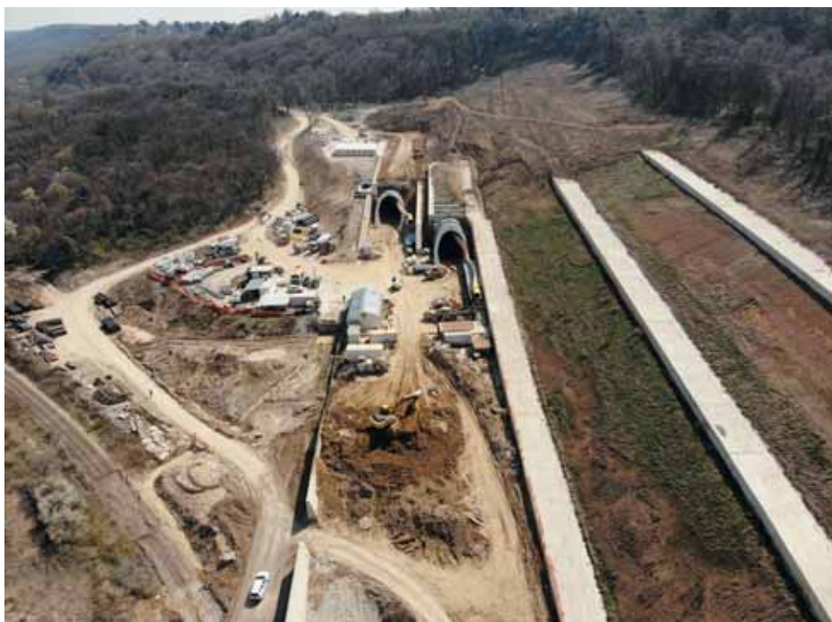
Вид сверху на северные порталы тоннелей Чортановцы в Республике Сербия
