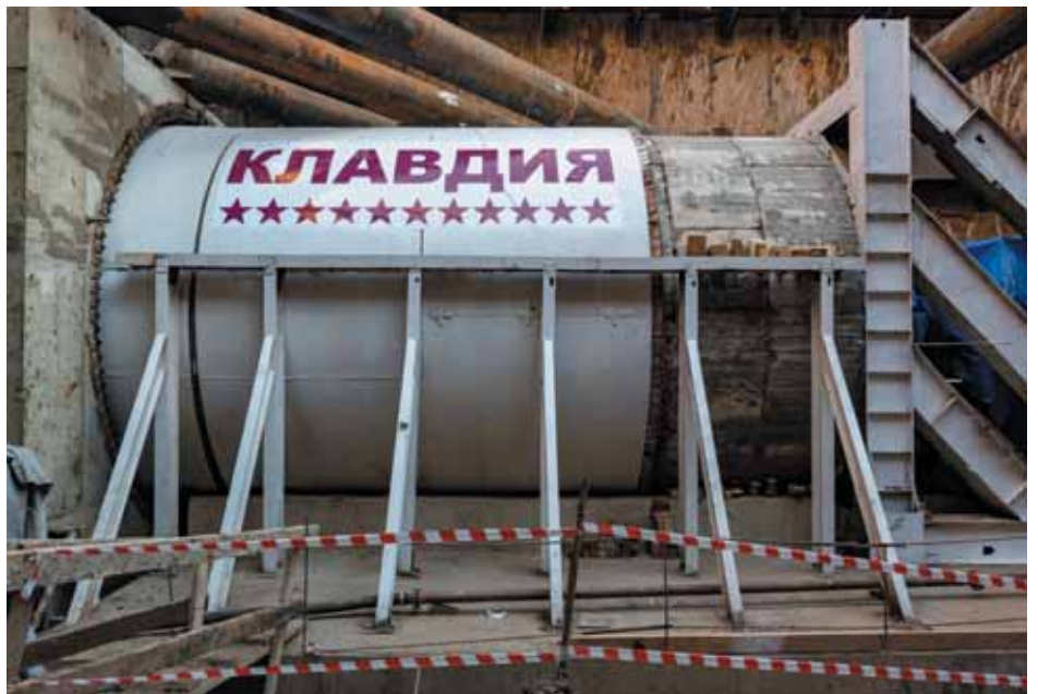
7 декабря 2020 г. началась проходка правого перегонного тоннеля между станциями «Улица 800-летия Москвы» и «Лианозово» Люблинско-Дмитровской линии
