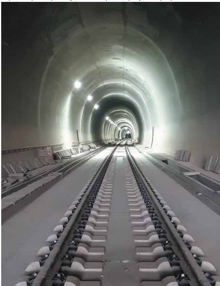
Устройство верхнего строения пути в тоннеле Чортановцы (Республика Сербия)
