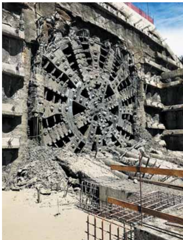
Рис. 7. Сбойка щита с грунтопригрузом забоя «Лючия» фирмы Herrenknecht (диаметр 15,87 м) в июле 2020 г.
