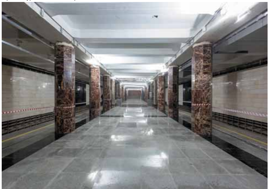
Архитектурно-отделочные работы на станции «Каховская» Большой кольцевой линии
