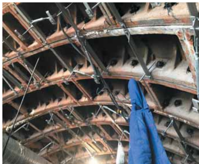
Рис. 2. Пример выполненных работ по уплотнению заобделочного пространства путем нагнетания специально разработанного тампонажного раствора на основе цементно-вяжущей смеси фирмы BASF и инъектирования стыковых соединений полиуретановыми смолами фирмы BASF и Normet
