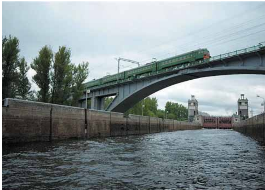
Рис. 9. Железнодорожный мост системы Бачелиса через шлюз № 8 канала им. Москвы
