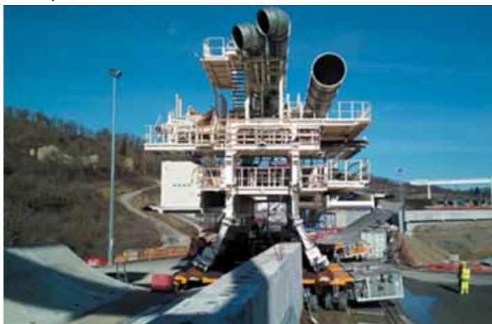
Рис. 5. Самоходный модульный транспортер передвигает предварительно смонтированные элементы технологической тележки
