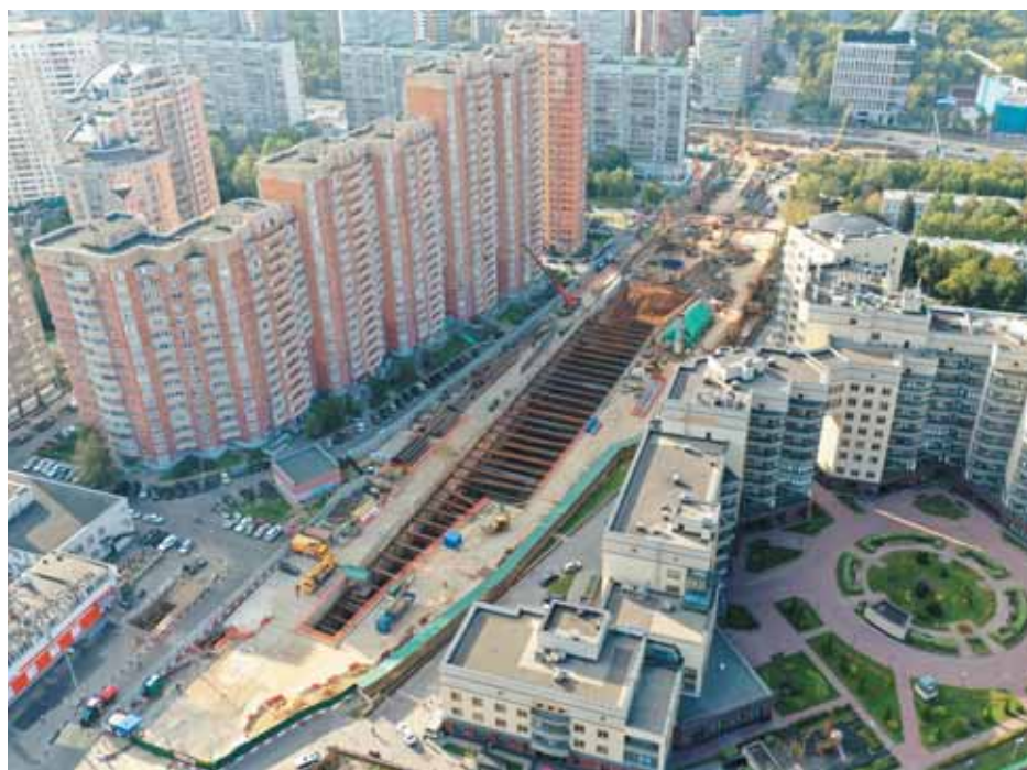
Строительство станции «Улица Новаторов»
