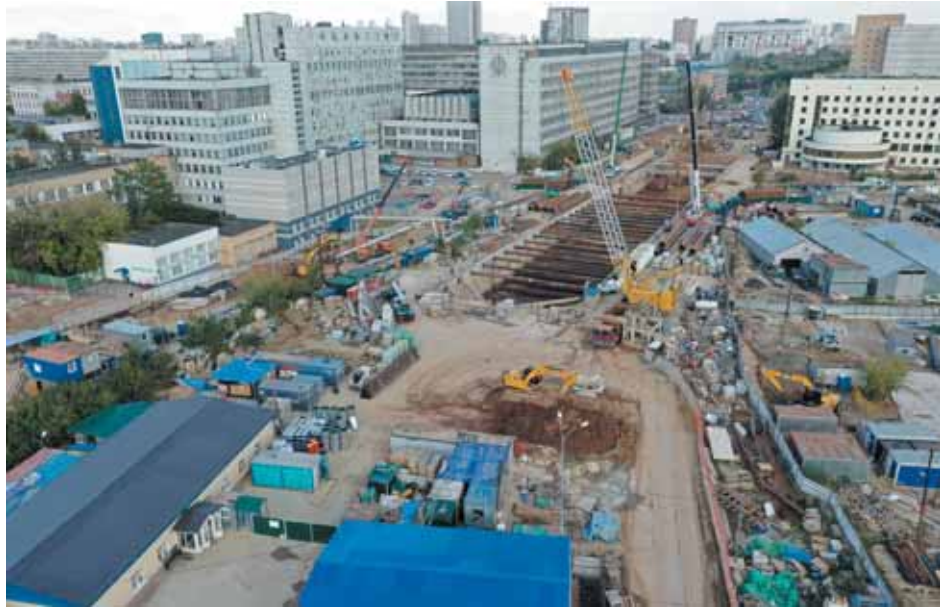
Строительство станции «Воронцовская»
