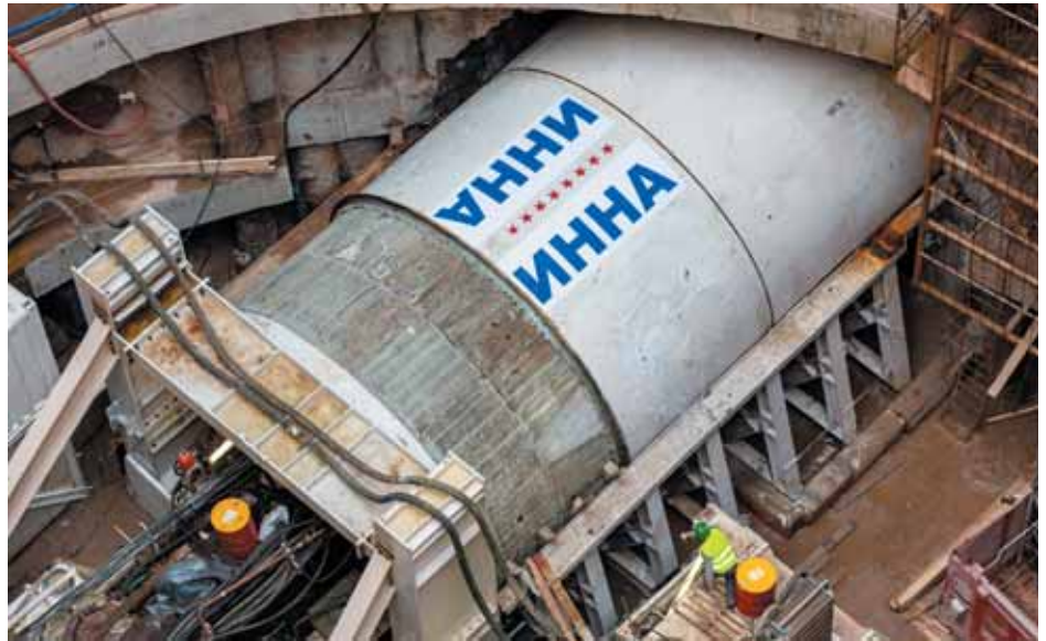
ТПМК Herrenknecht S-772 «Инна» прокладывает левый перегонный тоннель от уникальной круглой камеры за станцией «Ржевская» в сторону «Савеловской» Большой кольцевой линии
