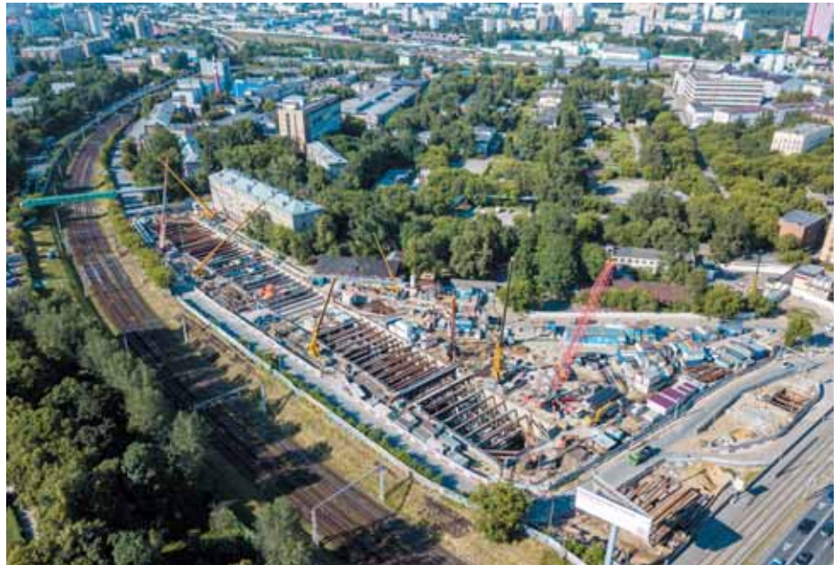
Общий вид на станционный котлован «Авиамоторной»
