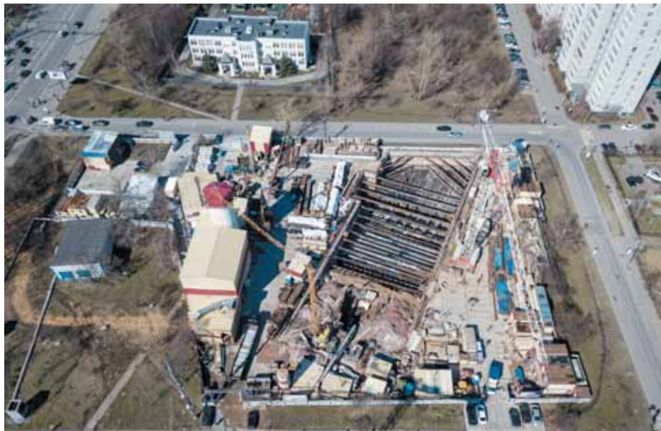
Вид на строительную площадку, где расположится вестибюль станции «Шереметьевская» БКЛ
