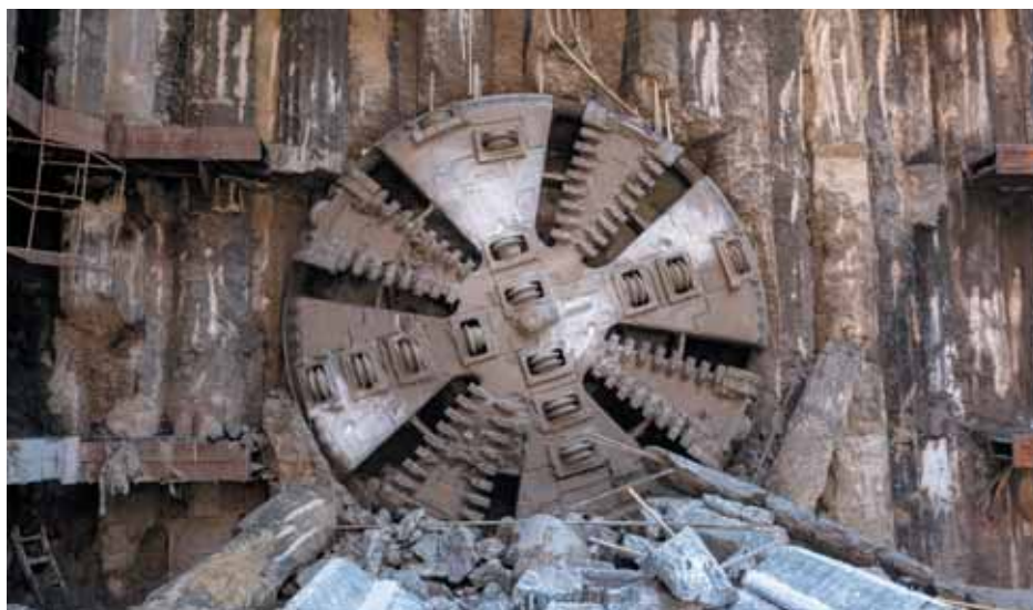
Завершение проходки правого перегонного тоннеля между станциями «Рубцовская» и «Стромынка» БКЛ
