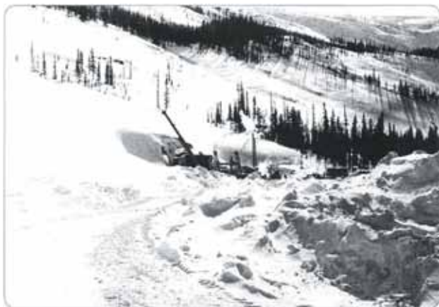
Рис. 10. Начало строительства западного порталного участка Байкальского тоннеля
