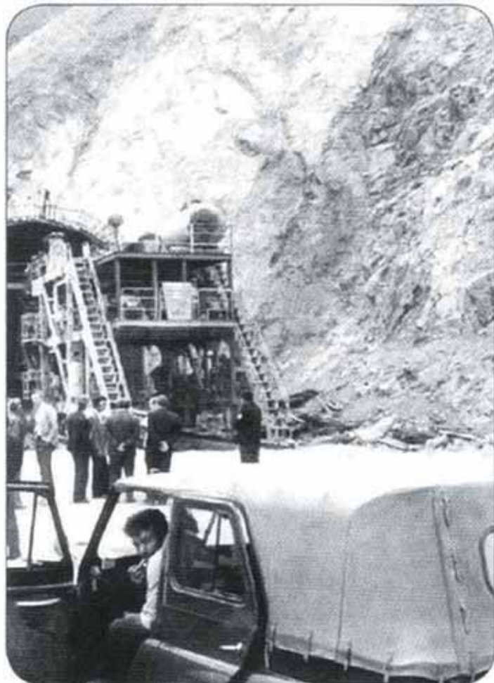
Рис. 12. Врезка на Мысовом тоннеле № 1
