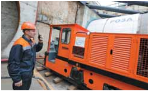
ТПМК «Роза» отправился строить правый перегонный тоннель в сторону станции «Зюзино»
