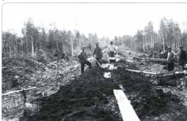
Рис. 3. Строительство подходных железнодорожных линий к магистрали, 1937–1940 гг.
