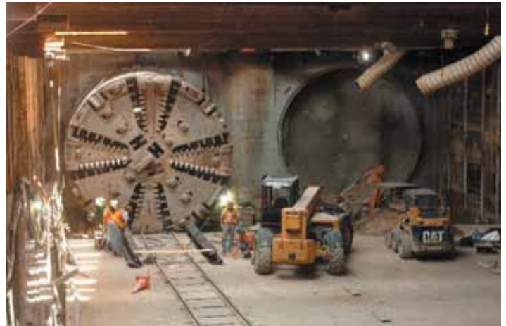
Рис. 4. В 2006 г. два ТПМК «Херренкнехт» S-297/298 успешно завершили проходческие работы для продления Золотой линии метро Лос-Анджелеса. Оба ТПМК являются взрывобезопасными по причине наличия газовых месторождений в почве
