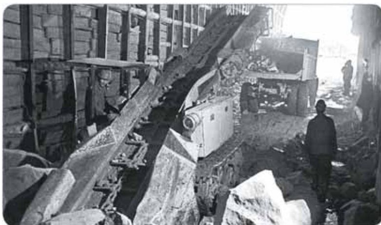
Рис. 11. На проходке Северомуйского тоннеля
