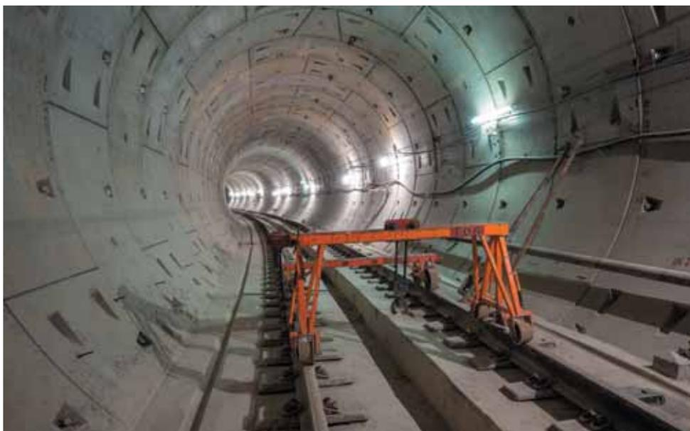
Путевые работы в левом перегонном тоннеле между площадкой № 5.2 и станцией «Рубцовская» БКЛ
