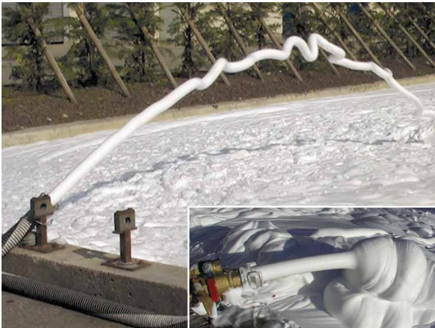
Производственные испытания кондиционера грунта марки CLBF5 производства фирмы «Кондат», Франция
