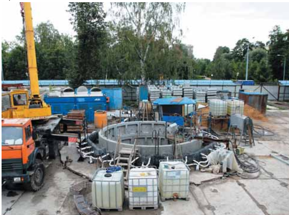
Строительная площадка шахты № 571
