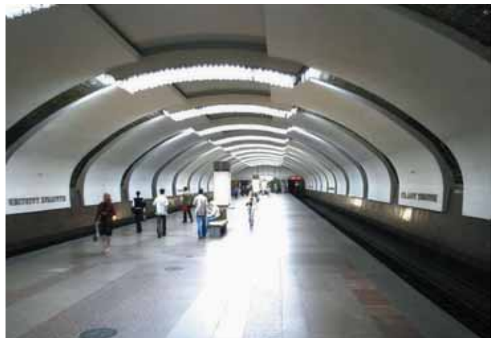
Рис. 8. Односводчатая станция «Институт Культуры»
