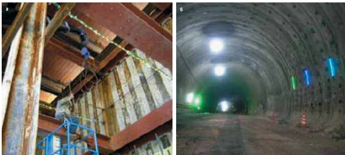
Рис. 3. Автоматизированный мониторинг напряженно-деформированного состояния строительных конструкций с постоянным оповещением о безопасности при помощи световых индикаторов (светодиодов): а – при разработке котлованов; б – при проходке тоннелей
