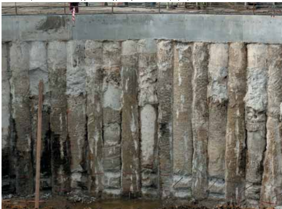
Рис. 12. Ограждающая конструкция из буросекущих свай при разработке котлована
