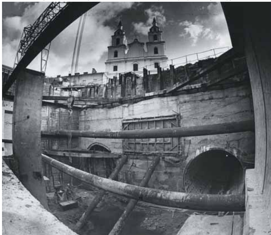
Рис. 4. Близкое расположение строительной площадки метро к Кафедральному собору
