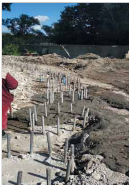
Рис. 6. Общий вид «стены в грунте» из бурсекущихся свай
