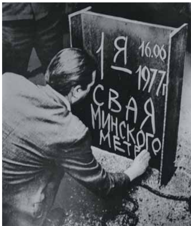
Рис. 1. Первая свая в котлован будущей станции «Парк Челюскинцев»
