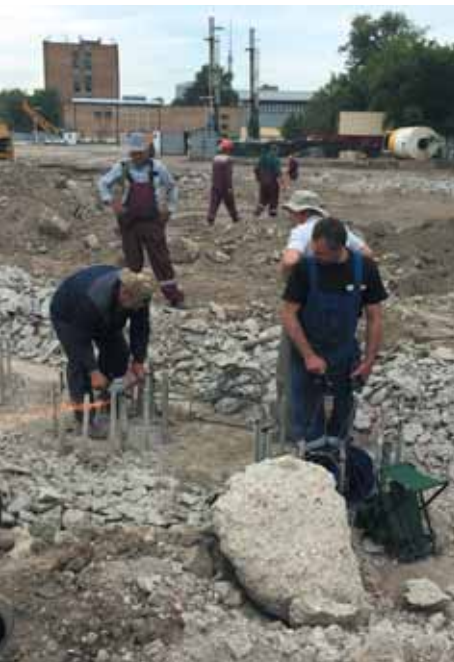
Рис. 4. Подготовка трубок перед испытаниями
