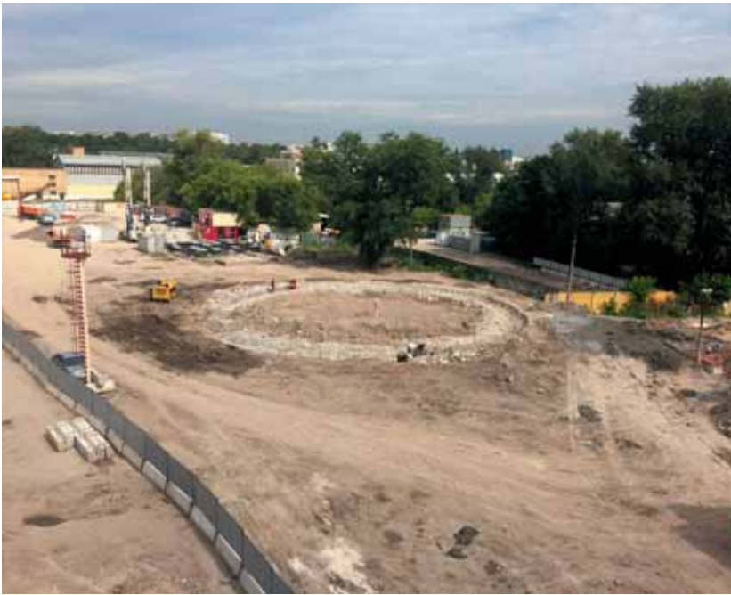
Рис. 2. Общий вид стройплощадки № 17
