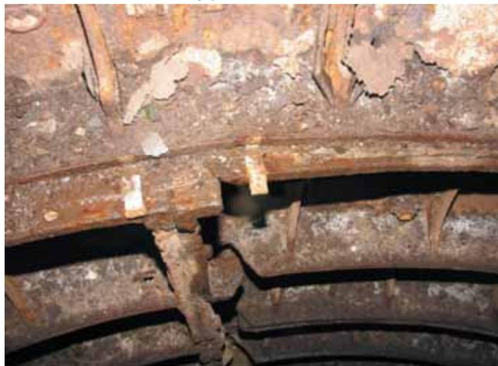
этом устранение дефектов (заделка отверстий) представляет собой сложную техническую задачу. Как известно чугун с трудом поддается сварке. Таким образом заварить отверстия путем установки накладок в большинстве случаев не представляется возможным.
