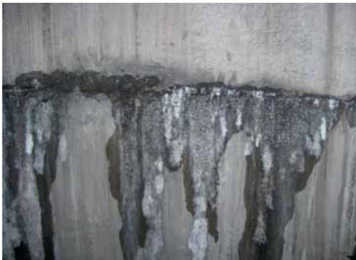
Рис. 6. Пример наличия трещин в спинке, ребрах и бортах тубинга чугунной обделки ствола шахтной вентиляции. Установлены маяки для контроля динамики раскрытия трещин
