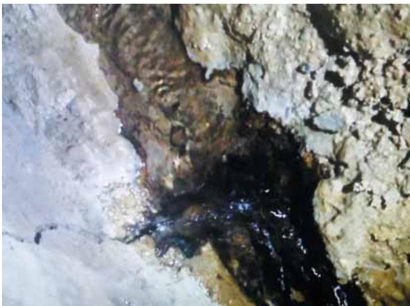
Рис. 4. Интенсивная течь на днище коллектора
