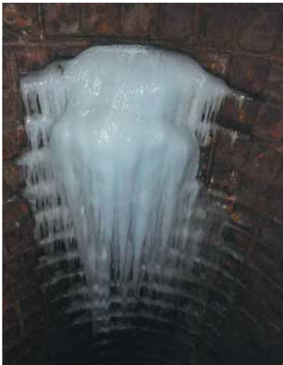
Рис. 4. Пример обледенения участка чугунной тубинговой обделки ствола шахтной вентиляции
