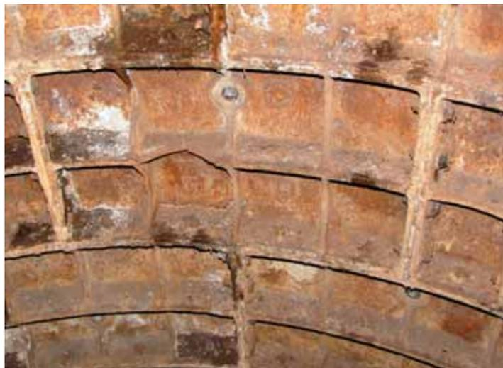
**Рис. 8. Пример наличия излома тубингов чугунной обделки ствола шахтной вентиляции со смещением внутрь ствола**
