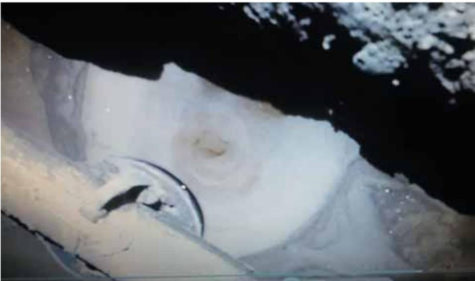
Рис. 7. Напорная течь на лотке коллектора с частичным выносом пены инъекционной смеси на начальной стадии инъектирования
