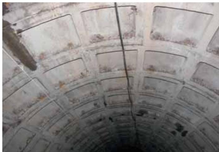
Рис. 2. Общий вид железобетонной тюбинговой обделки ствола шахтной вентиляции
