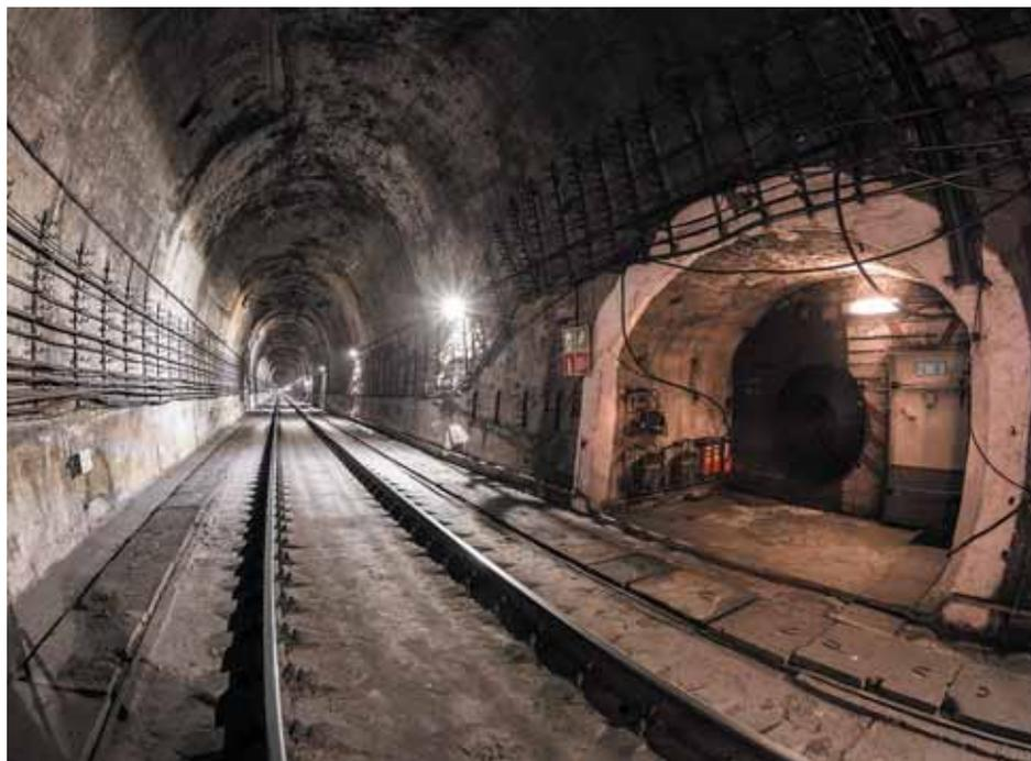
Рис. 1. Ниша в тоннеле, построенном горным способом
