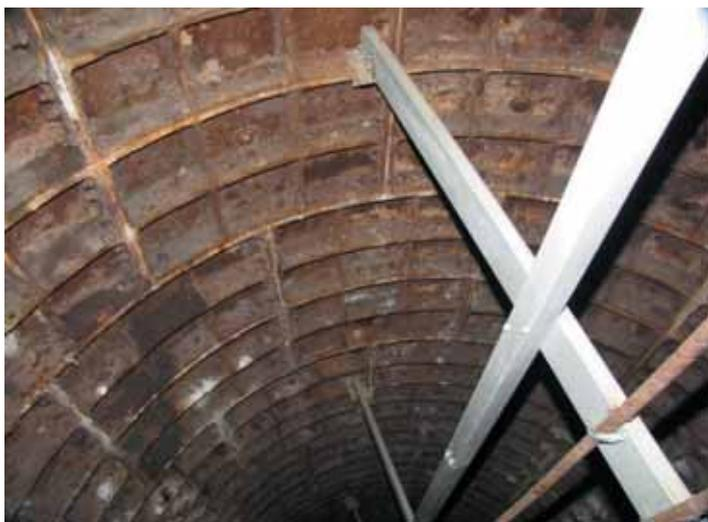
Рис. 1. Общий вид чугунной тюбинговой обделки ствола шахтной вентиляции
