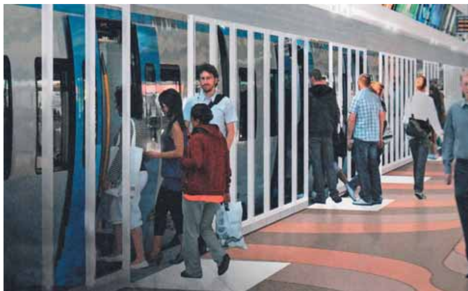
Рис. 3. Раздвижные двери, отделяющие платформу от путей на станции Стокгольмского метро
