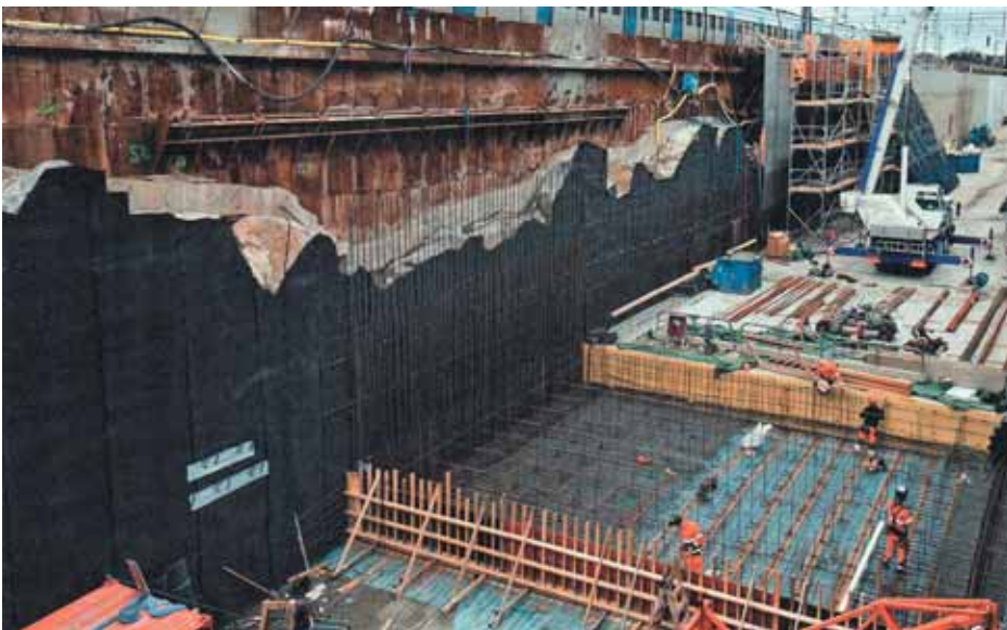
Рис. 6. Шпунтовое ограждение котлована
