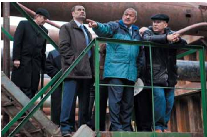
Обсуждение хода строительства станции метро «Северный вокзал»
