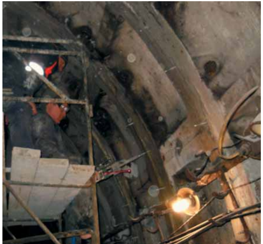
Рис. 4. Инъектирование усиленного полимером гидрогеля MC-Injekt GL-95 TX в крестовинах схождения тубингов по технологии с использованием двухкомпонентного инъекционного оборудования MC-I 700
