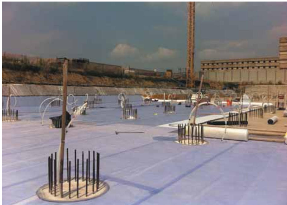
Рис. 3. Гидроизоляционная система, выполненная из прозрачной мембраны LOGICBASE V-T
