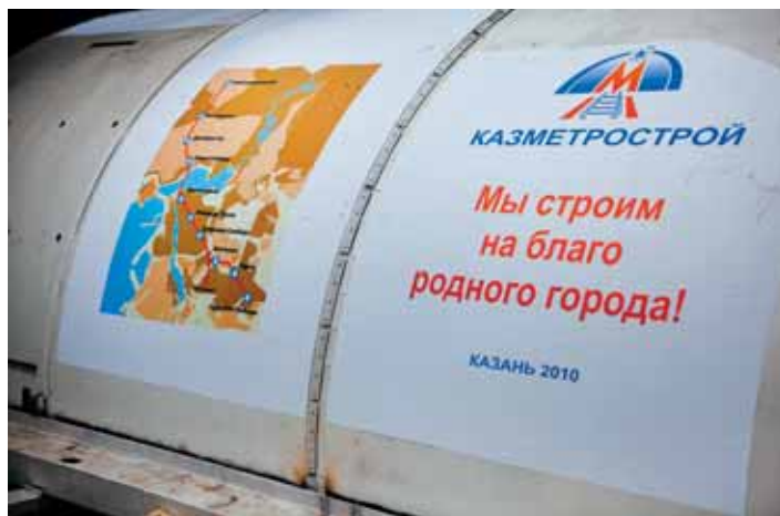
Пуск тоннелепроходческого комплекса «Алтынчэч»
