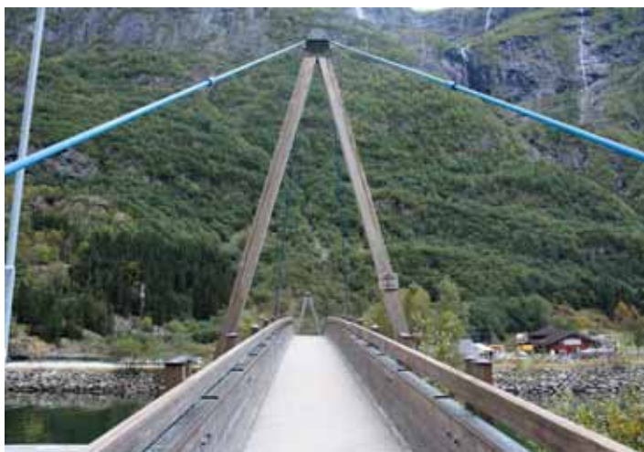
Рис. 10. Подвесной Хардангерский мост перед тоннелем
