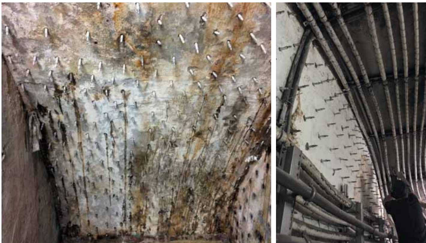
Рис. 5. Растровое инъецирование станционных помещений и кабельных галерей Петербургского метрополитена двухкомпонентным эластомером MC-Injekt 2300 top (группа Д) с целью остановки фильтрации воды через дефекты и пористую структуру бетона
