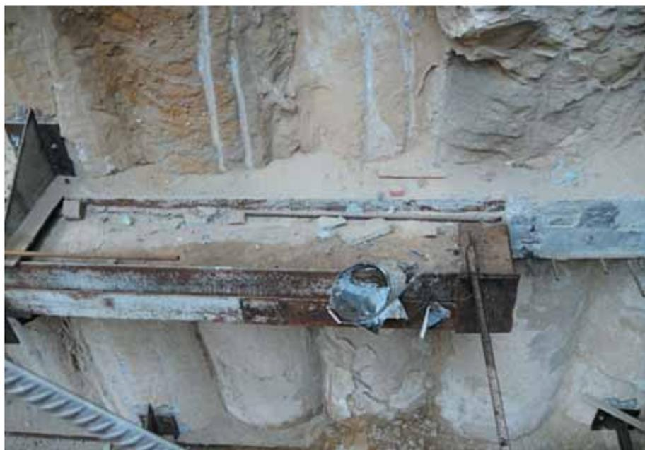
Рис. 5. Обычное качество поверхности свай ограждения после вскрытия котлована
