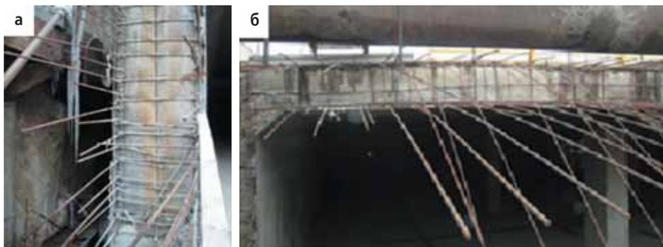
Рис. 2. Конструктивные элементы из монолитного железобетона: а – стена толщиной 1000 мм; б – перекрытие толщиной 800 мм
