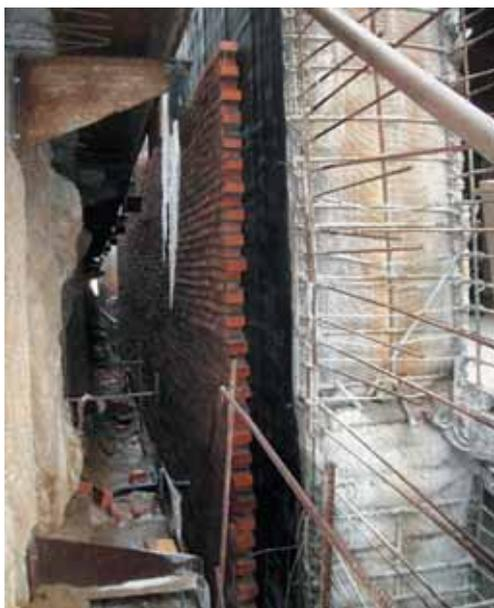
Рис. 4. Защита гидроизоляционной мембраны по стенам кирпичной кладкой в полкирпича
