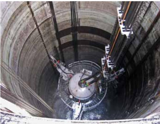
Проходка ствола комплексом фирмы «Херренкнехт АГ» VSM 7800/5600
