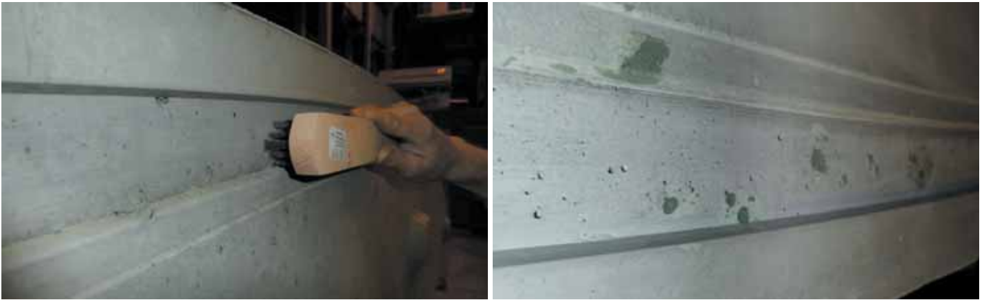
Рис. 2. Поры бетона перед оклейкой уплотнителя должны быть зачищены стальной щеткой и заполнены раствором
