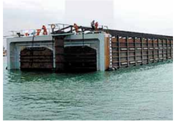
Рис. 14. Транспортировка сталебетонной секции (Турция)
