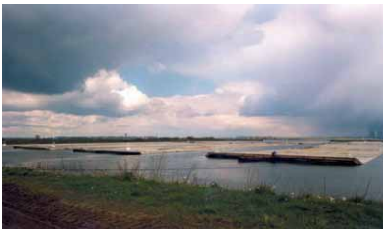
Рис. 11. Секции тоннелей, подготовленные для транспортировки (Нидерланды)
