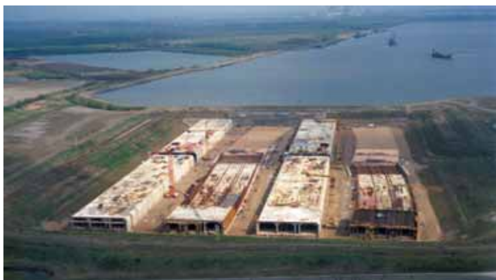
Рис. 9. Сооружение секции тоннелей в специальном котловане (Нидерланды)
