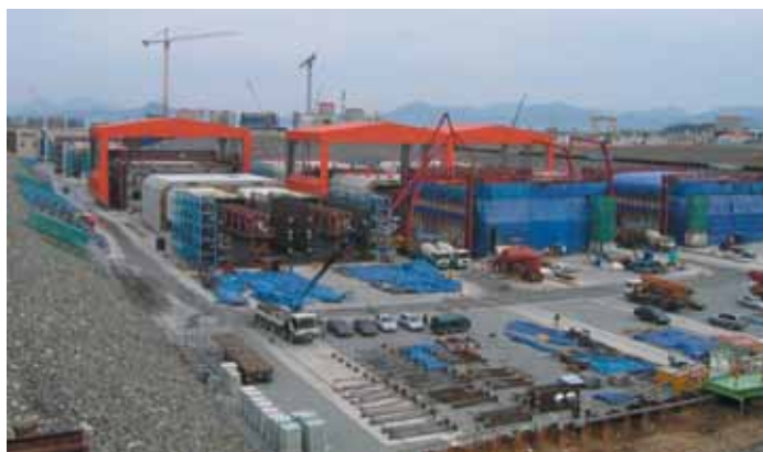
Рис. 10. Вид площадки для одновременной отливки нескольких секций тоннеля (западный берег залива Jinhae)
