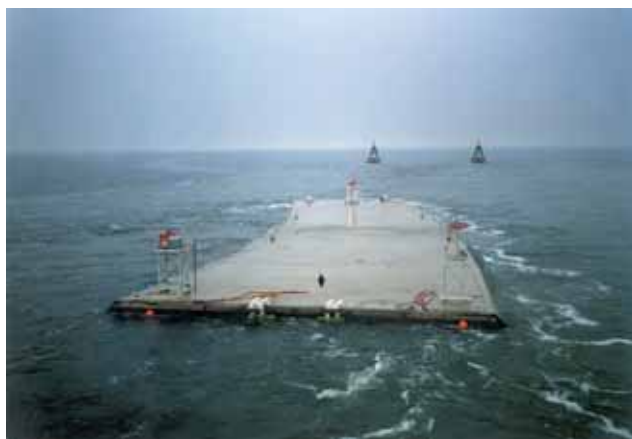
Рис. 12. Транспортировка железобетонной секции к месту погружения (Нидерланды)
