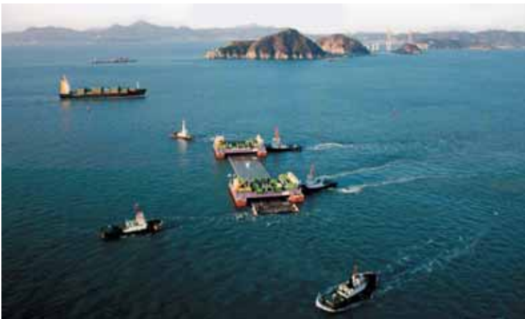
Рис. 16. Погружение секций со специальной баржи
