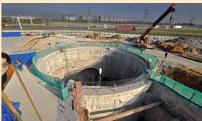
Сооружение стартового котлована
