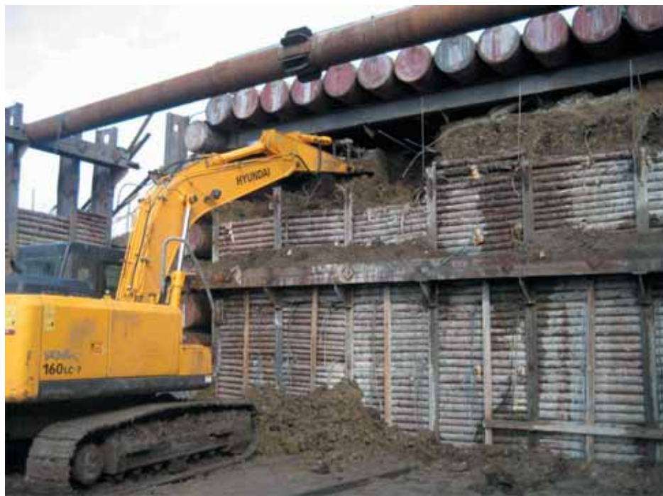
Рис. 1. Строительство тоннеля под железной дорогой Виноградная – Георгиевск
