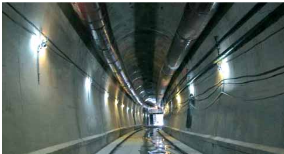
Вид на припортальный участок тоннеля с монолитной железобетонной обделкой
