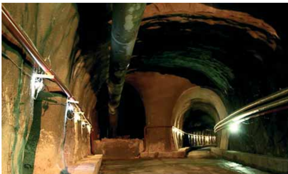
Узел стыковки с обгонным тоннелем Юкспорского тоннеля № 1
