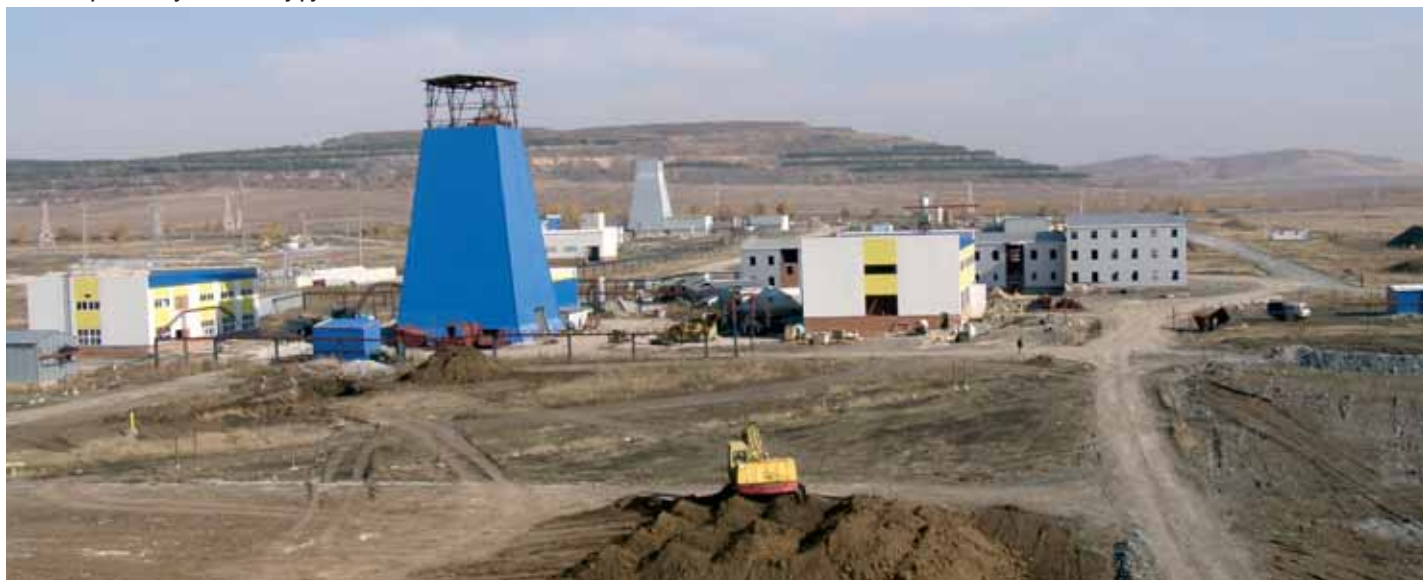
Вид на строительную площадку рудника «Чебачий»
