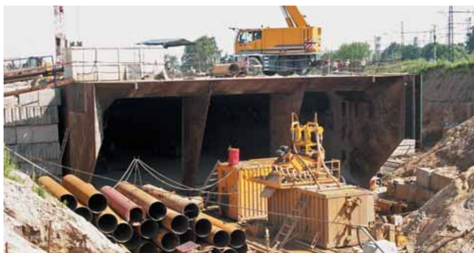
Рис. 1. Вид на ножевую часть продавливаемого тоннеля
