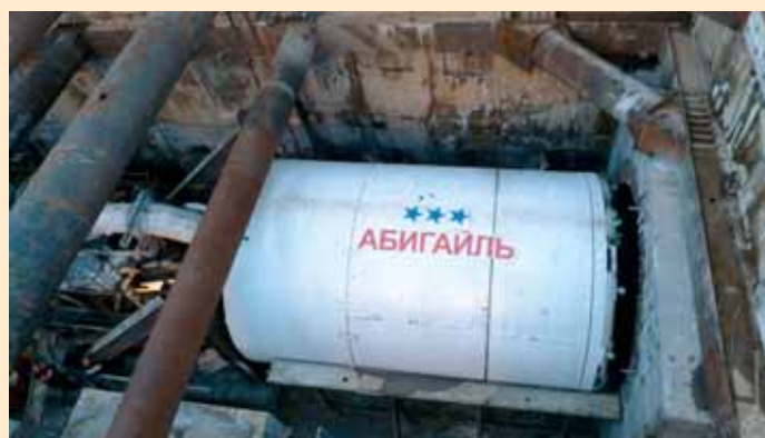
ТПМК «Ловат-238» в стартовом котловане. Три звезды означают пройденные тоннелепроходческим комплексом тоннели
