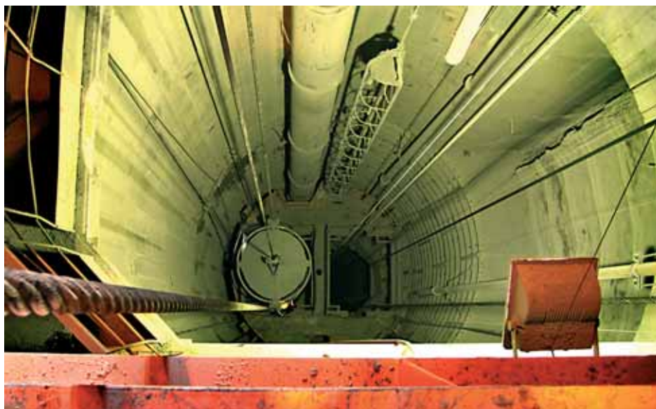
Проходка вертикального ствола на Усольском калийном комбинате
