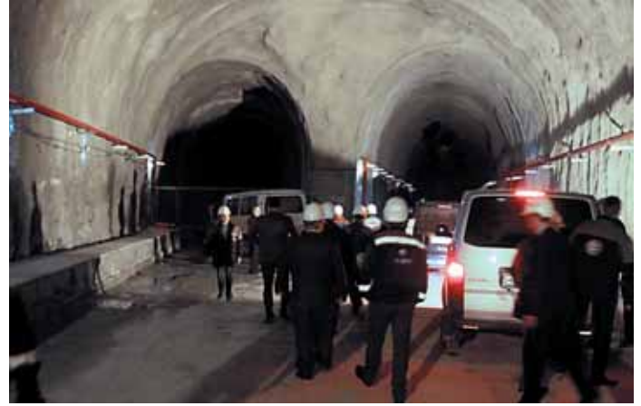
Участок сопряжения тоннелей № 1 и 2
