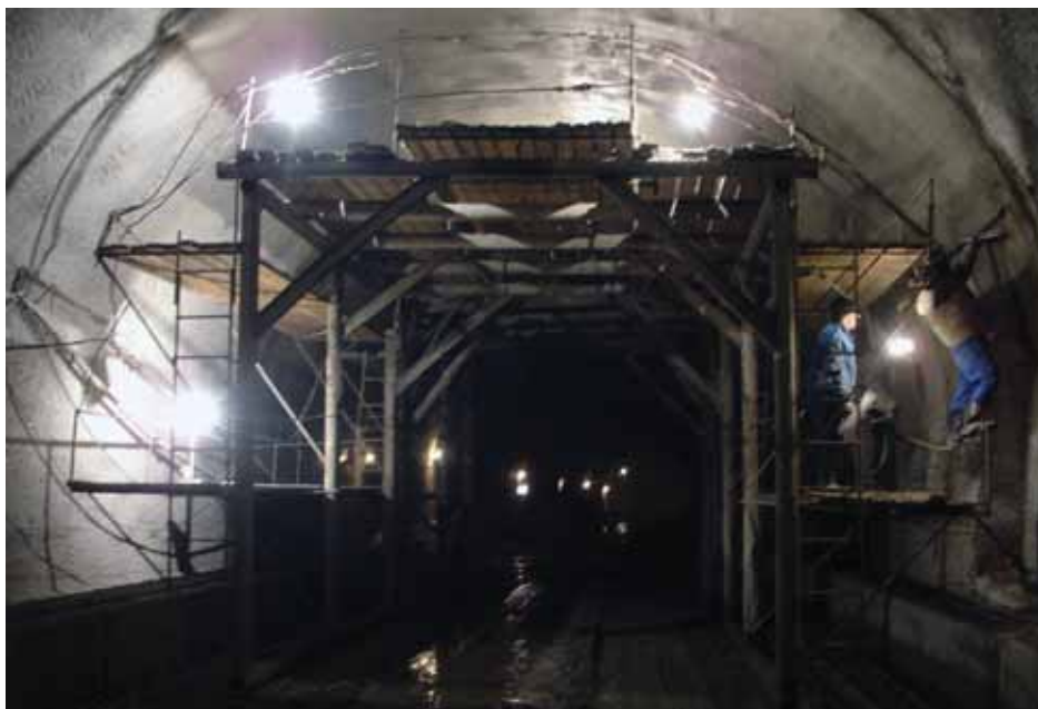
Рис. 4. Работа с Nafufill KM250 в тоннеле
