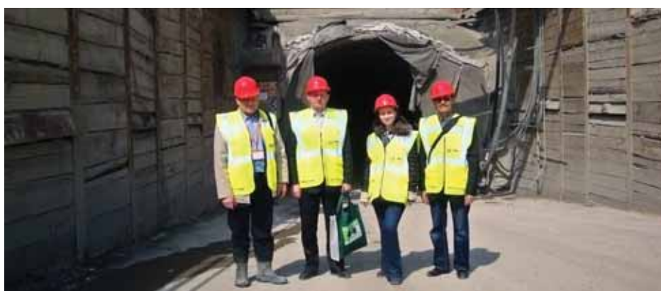
Специалисты ОАО «Трансинжстрой» и ОАО «Минскметропроект» на строительстве подземного комплекса Бланка в г. Прага
