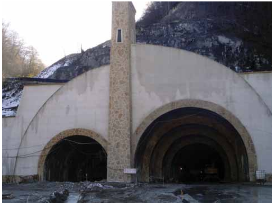
Рис. 2. Северный портал тоннеля в период реконструкции
