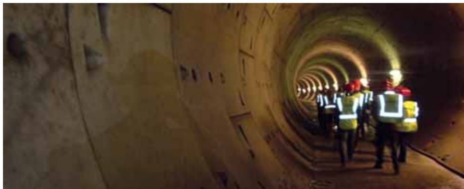
Строительство новой линии Пражского метрополитена
