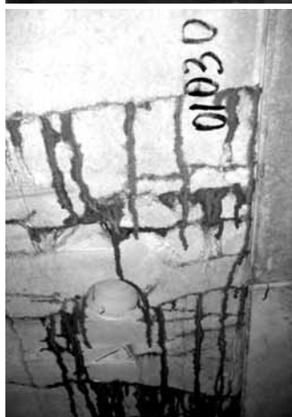
Рис. 2. Образование трещин в блоках обделки от действия щитовых домкратов (2004 г.)
