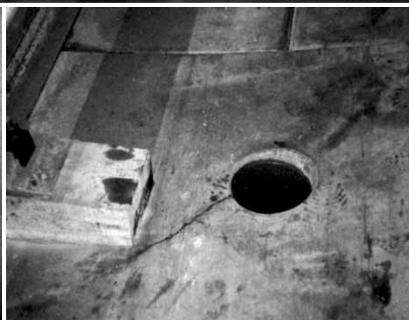
Рис. 2. Образование трещин в блоках обделки от действия щитовых домкратов (2004 г.)
