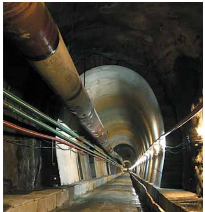
Участок построенного тоннеля
