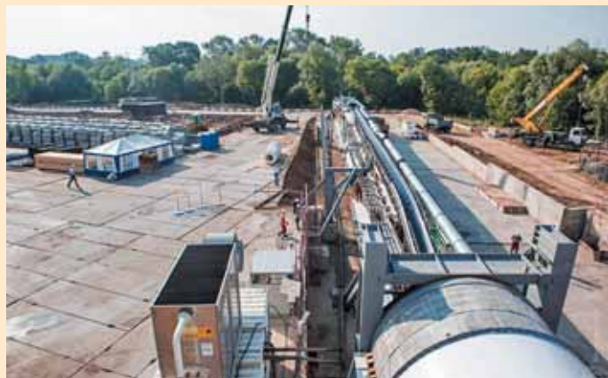
Тоннелепроходческий комплекс фирмы «Херренкнехт» на монтажной площадке
