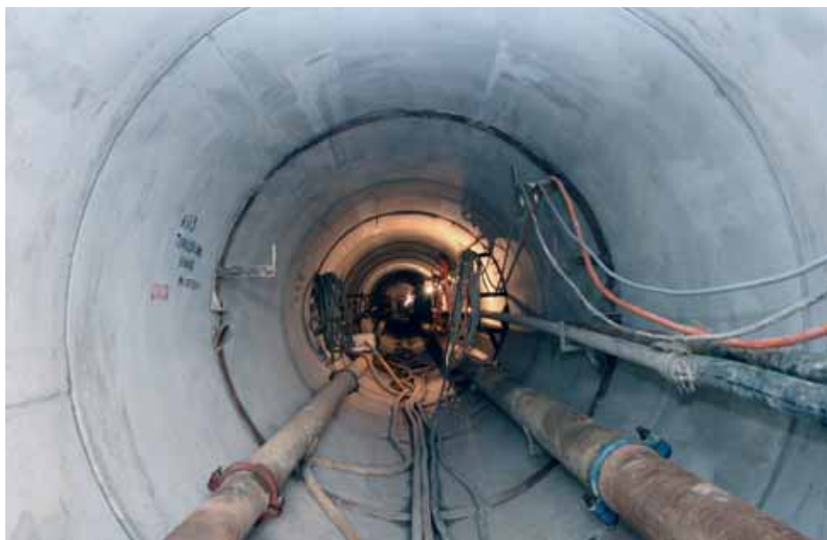
Участок готового тоннеля
