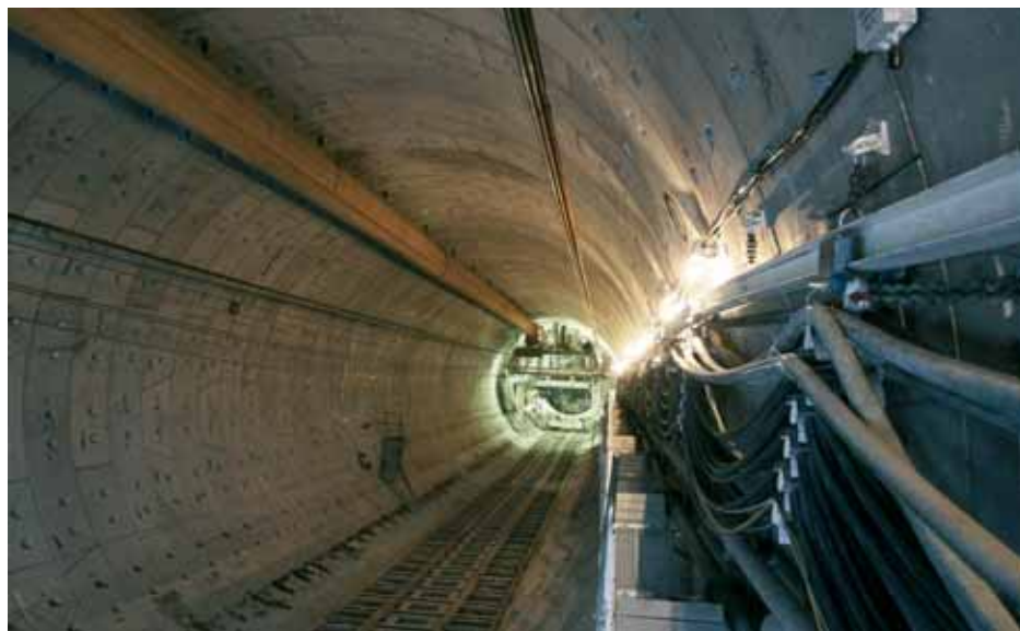
Готовый тоннель наклонного хода на ст. «Обводный канал»
