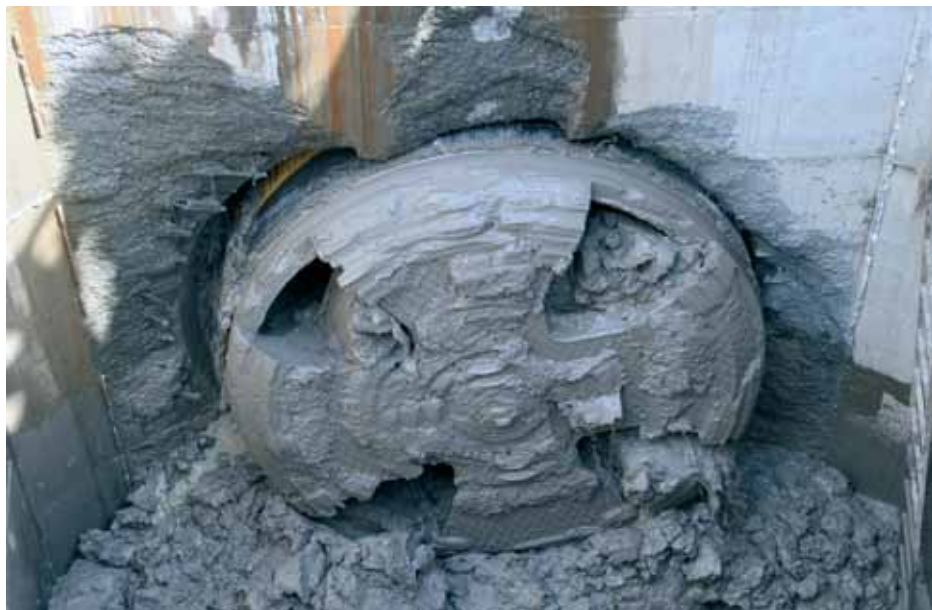
Выход щита в демонтажную камеру
