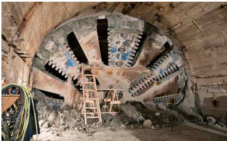
Завершение наклонного хода ТПМК «Аврора» на ст. «Обводный канал»
