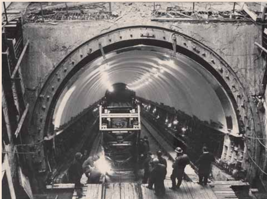
Монтаж эскалаторов на ст. «Гостинный двор». На фото видны новые зонты, впервые внедренные на строительстве первого участка Невско-Василеостровской линии метро
