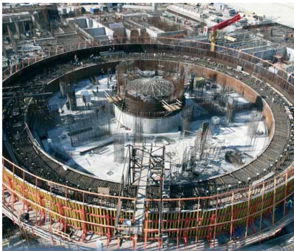
ЛАЭС-2, строительство атомного реактора
