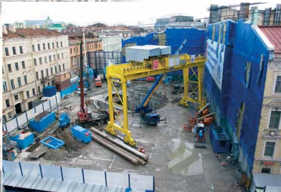
Начало работ по проходке наклонного хода ст. «Адмиралтейская»
