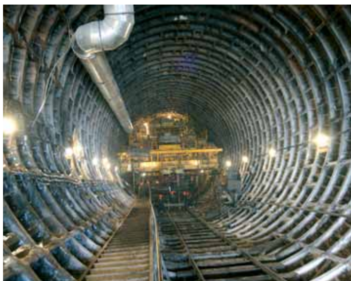
Прокладка наклонного хода на ст. «Международная»
