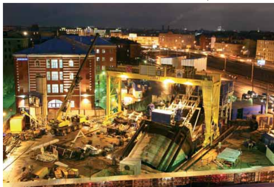
Начало проходки наклонного хода на ст. «Обводный канал» в октябре 2009 г.
