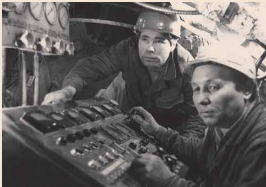
Операторы тоннелепроходческого комплекса марки КТ
