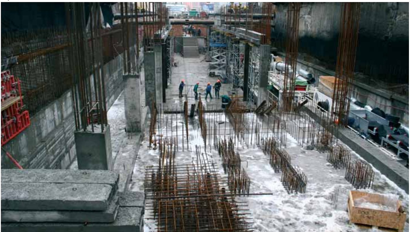
Строительная площадка станции «Демеевская»
