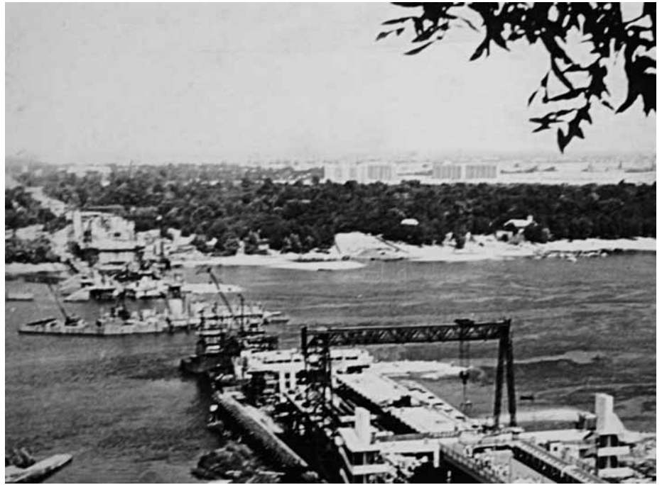
Строительство метромоста через Днепр
