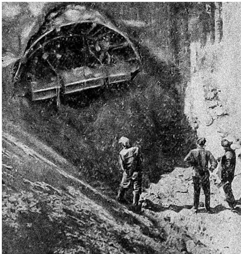
Выход щита в котлован демонтажной камеры после завершения проходки
