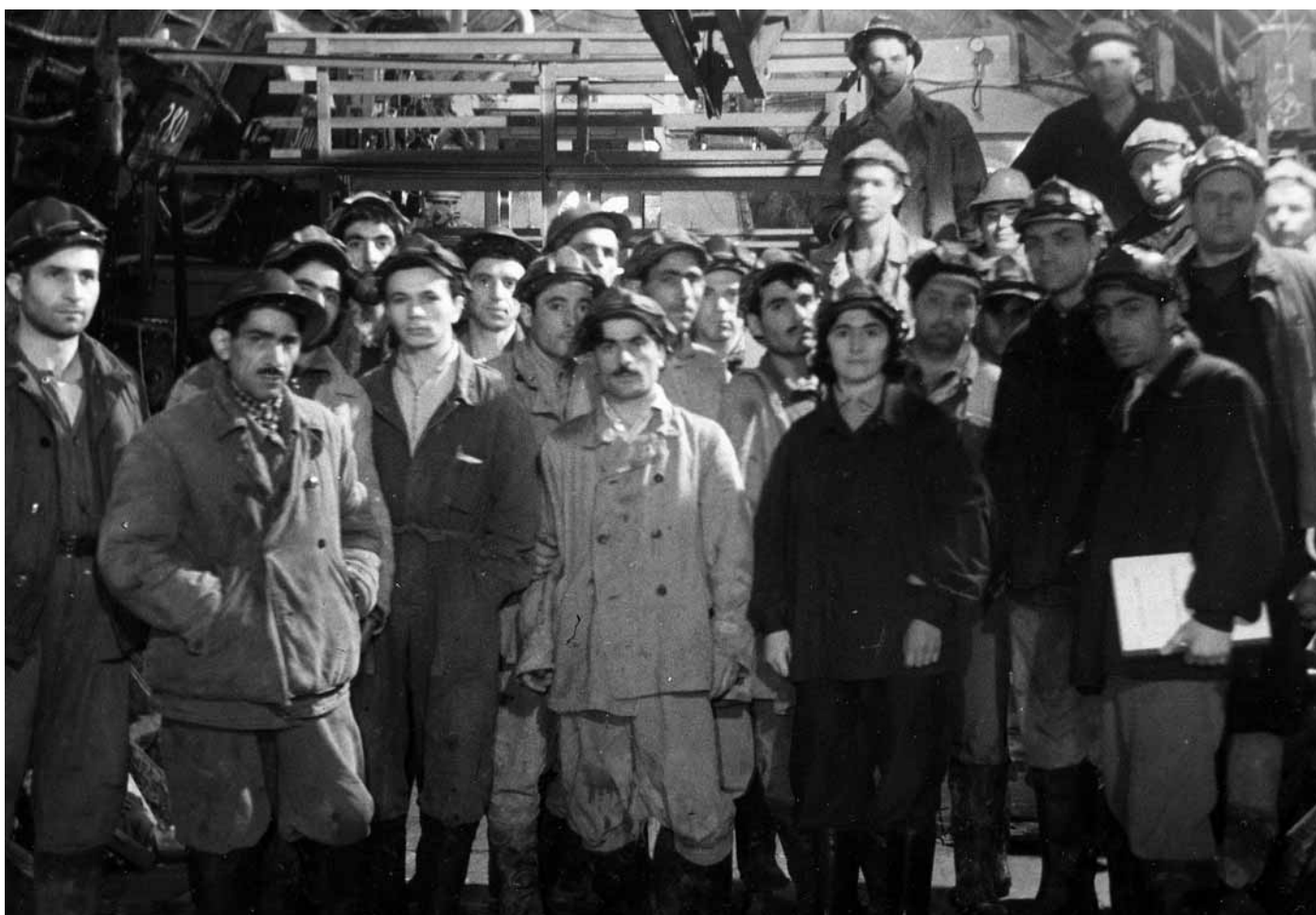
Строители Бакинского метрополитена перед первым спуском в кессон (апрель 1963 г.)
