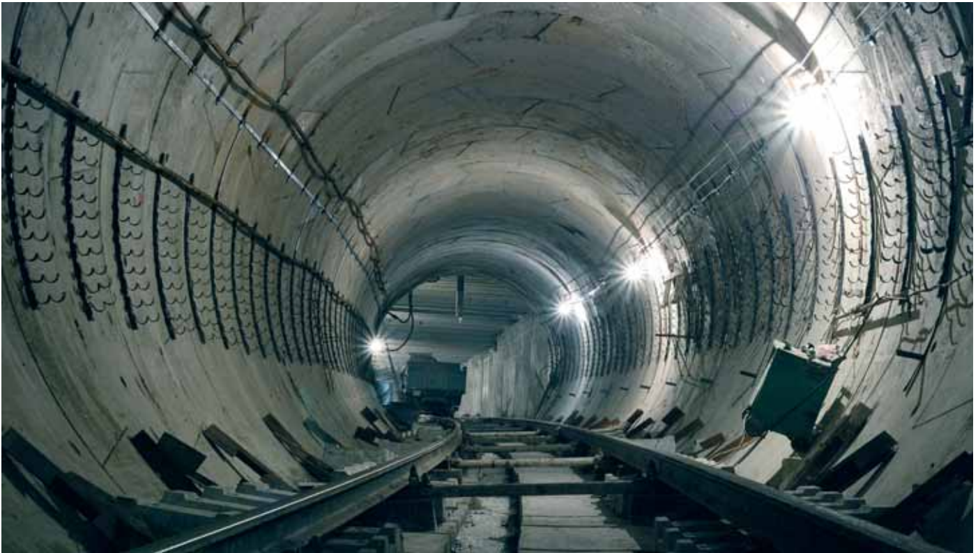
Перегонный тоннель с железобетонной обделкой
