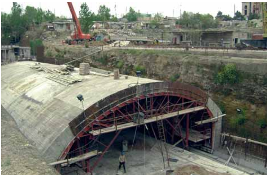
Передвижная опалубка на строительстве станции «Азадлыг проспекти»
