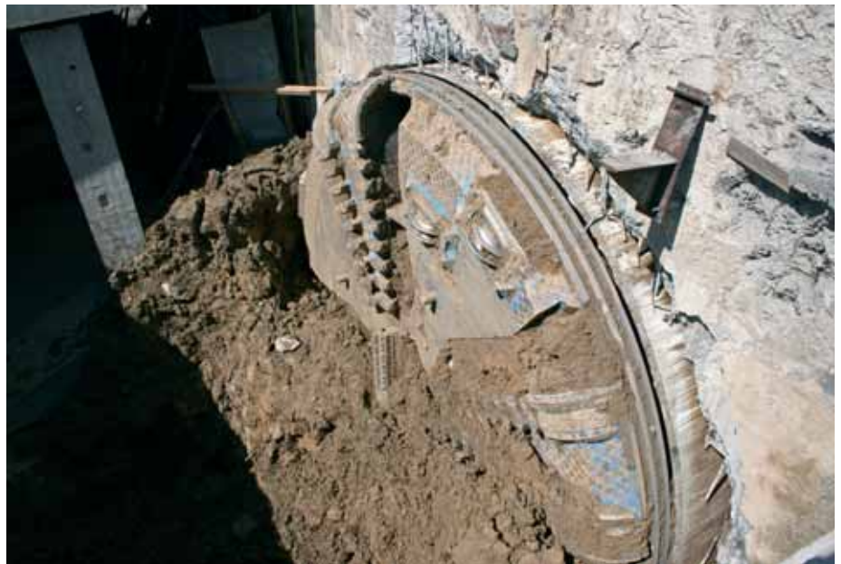
Выход щита. Сбойка
