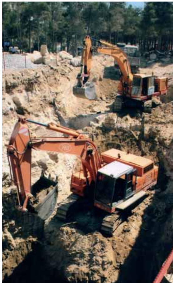
Сооружение раструба для будущей станции «Мушфиг» и депо 2
