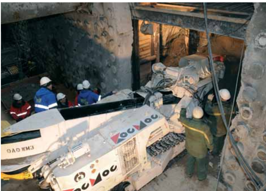
Начало проходки Алабяно-Балтийского тоннеля
