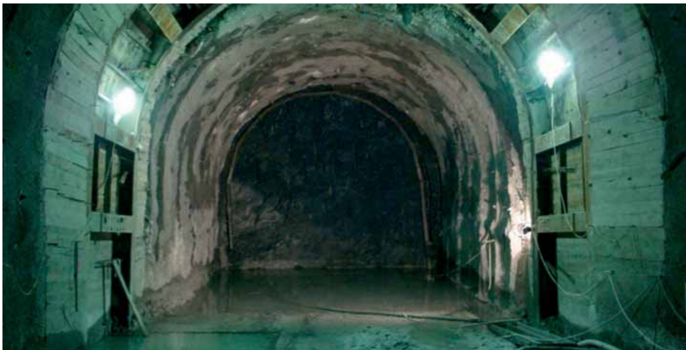
Специальная конструкция упорной рамы для монтажа ТПМК
