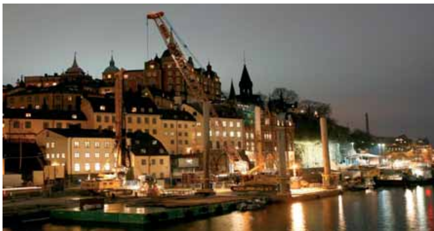
Строительство объездной дороги у южного котлована
