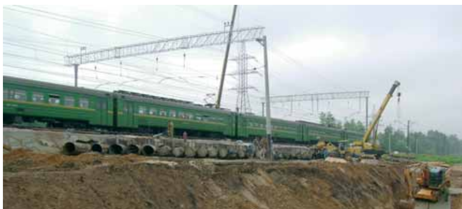
Экран из труб под железнодорожным полотном
