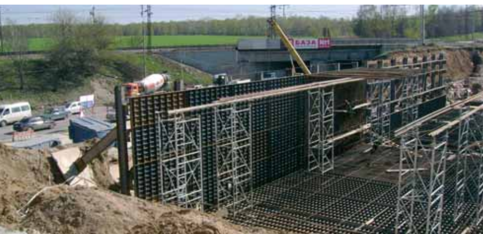
Смонтированные карты металлоизоляции
