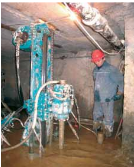
Выполнение работ на буровом станке «Figaro» в г. Екатеринбурге
