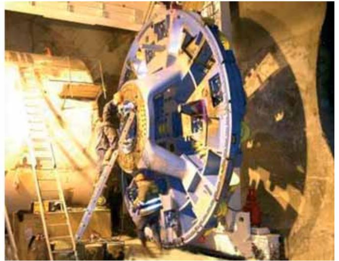
**Монтаж ТПМК в поперечной камере ст. «Алматы» на глубине 40 м**
