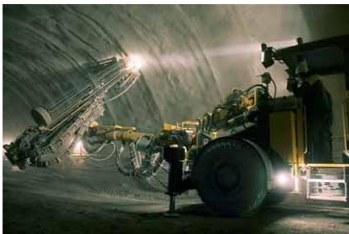
Рис. 10. Устройство анкеров установкой Boltek LC
