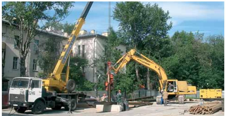
Рис. 4. Вибропогружение шпунта Larssen
