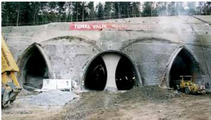
Рис. 2. Схема проходки смежных тоннелей
