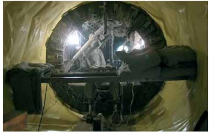
Рис. 2. Монтаж геотекстильного и гидроизоляционного слоев
