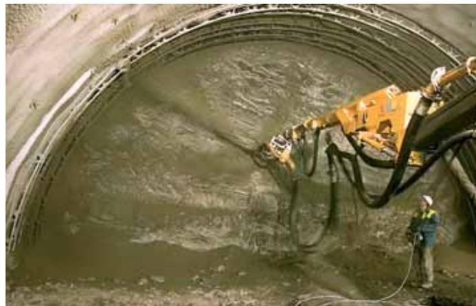
Рис. 9. Нанесение набрызг-бетона установкой Sika PM-500
