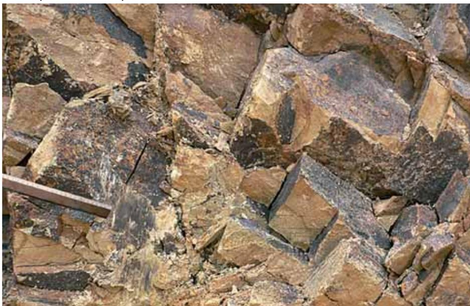
Рис. 2. Одиночная трещина в ИГЭ-18", заполненная глинистым материалом, на фоне сильной скрытой трещиноватости
