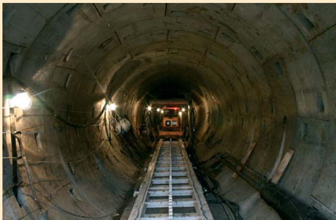
Гребенчатая рельсовая дорога для выдачи грунта на поверхность
