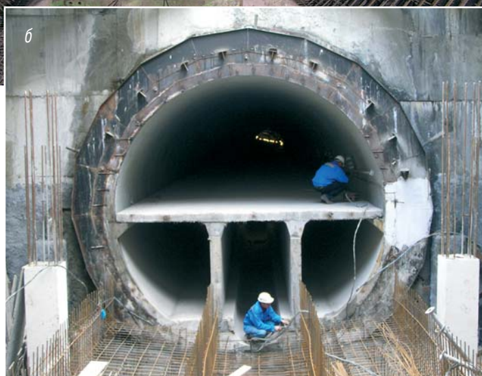
Сооружение вторичной обделки тоннеля диаметром 6 м:
