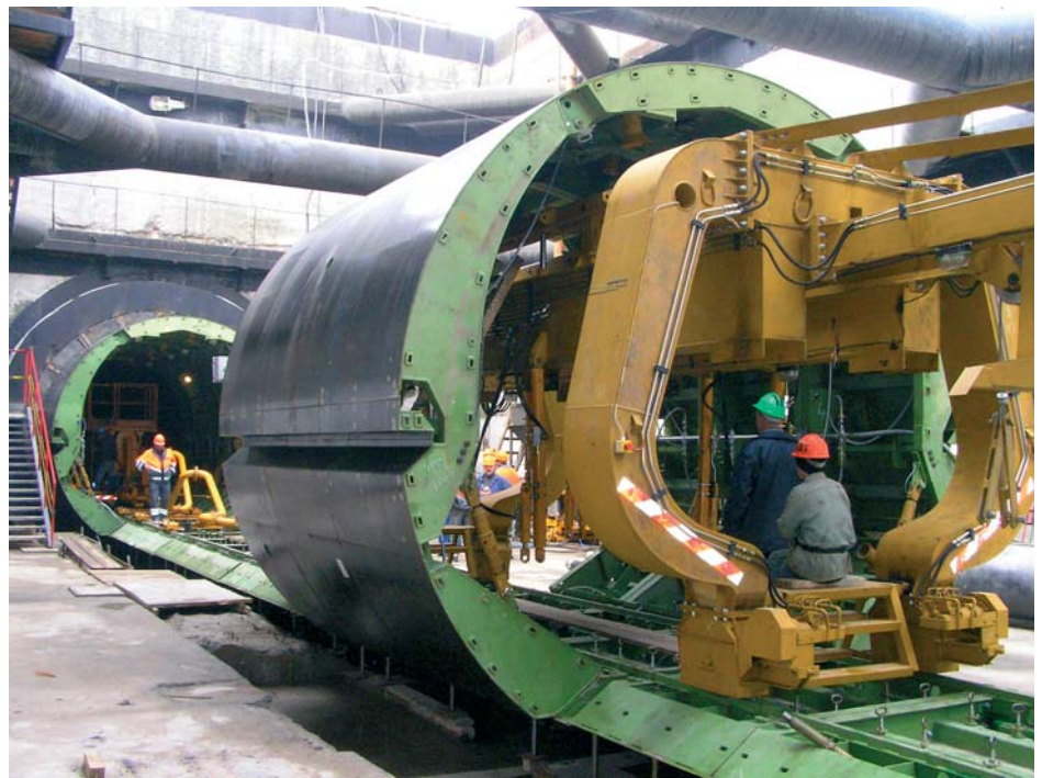
Механизированная передвижная опалубка фирмы «CIFA», Италия
