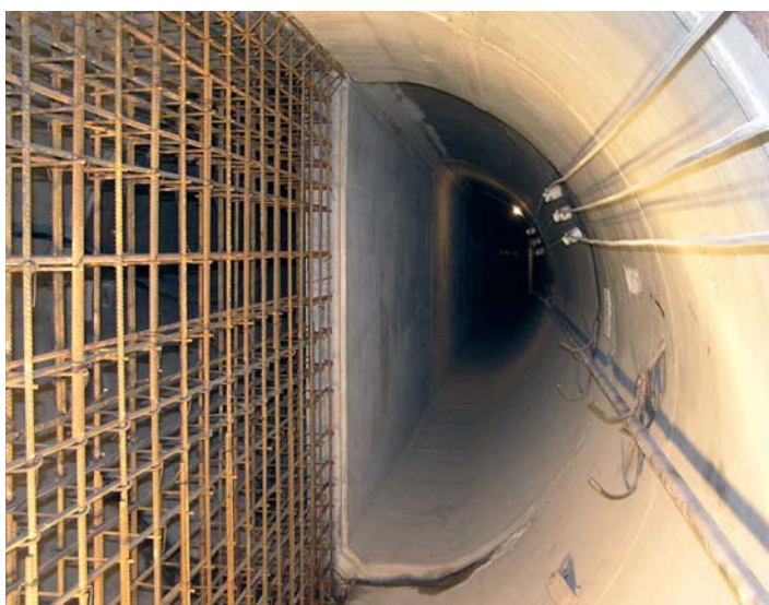
Сооружение вторичной обделки тоннеля диаметром 3,5 м
