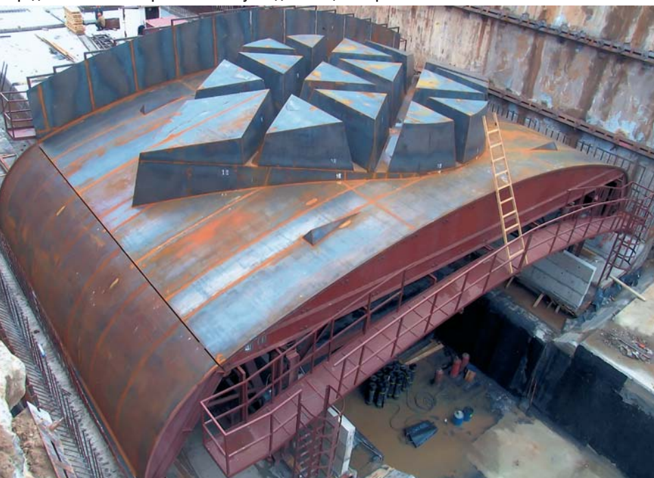
Передвижная механизированная опалубка для станции «Строгино»
