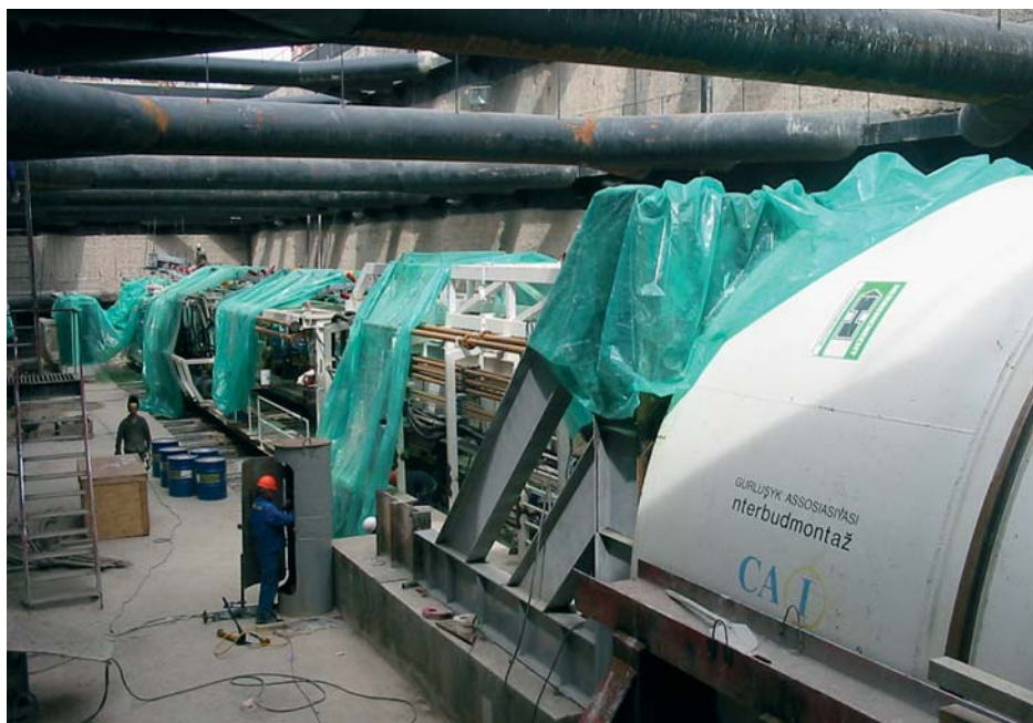
Тоннелепроходческий механизированный комплекс «Херренкнехт» диаметром 6 м в монтажной камере
