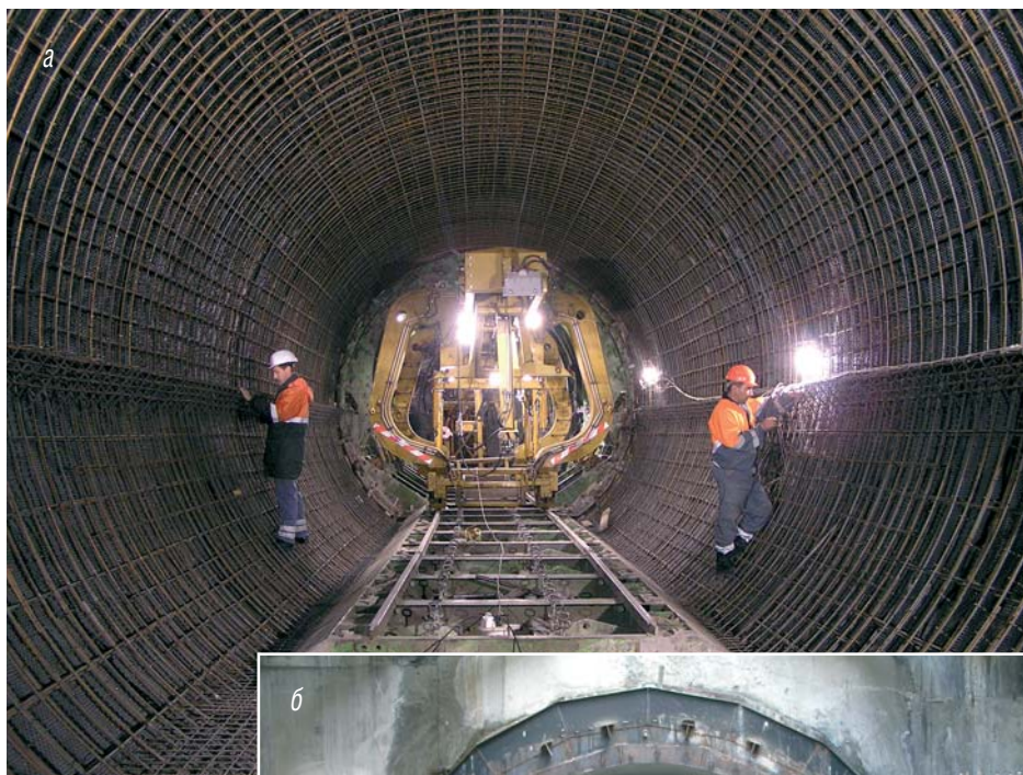
Сооружение вторичной обделки тоннеля диаметром 6 м:
