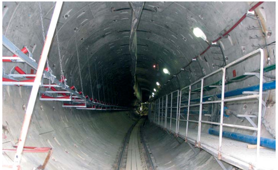
Первые метры проходки. Монтаж тоннельного ленточного конвейера
