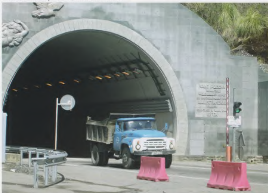
Рис. 6. Южный портал Мацестинского тоннеля
