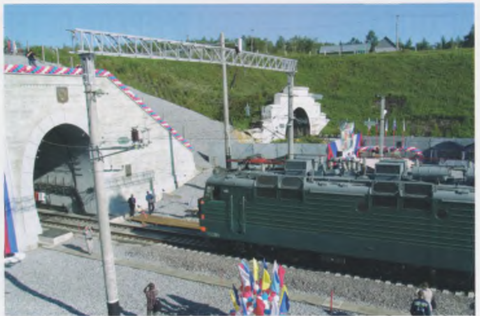
Открытие движения по Лагар-Аульскому тоннелю
