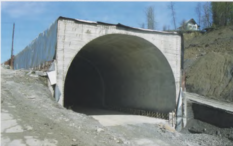
Рис. 1. Южный портал строящегося тоннеля № 3
