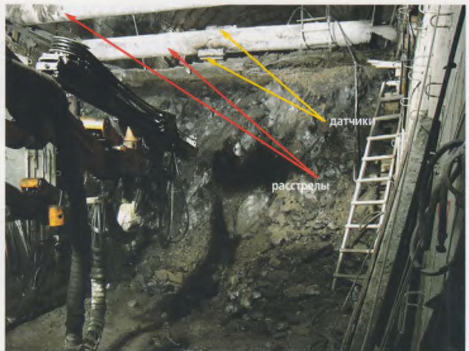
Рис. 6. Установка расстрелов для предотвращения горизонтальных смещений крепи при разработке уступа (на высоте +2 м от УГР)
