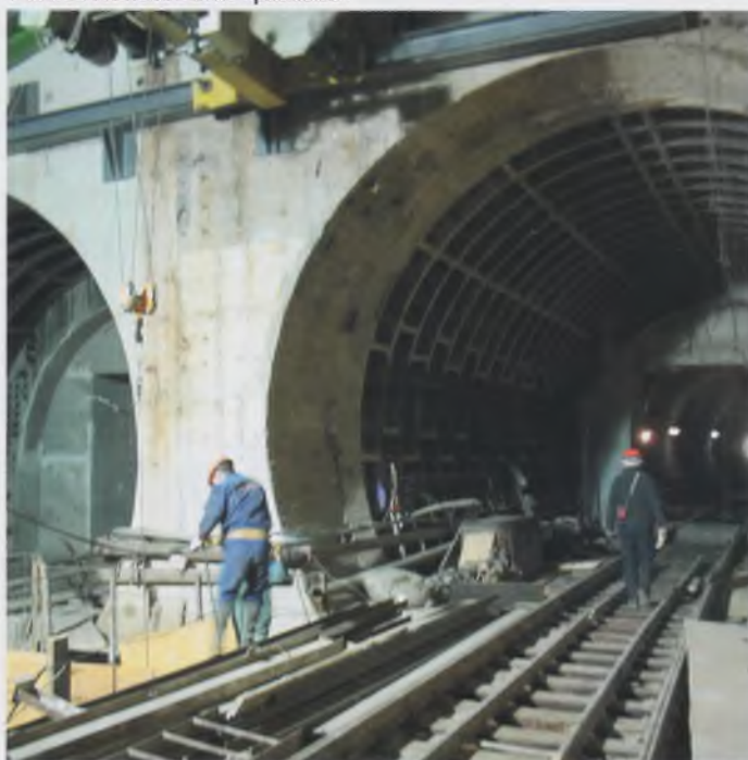
Участок тоннеля в зоне «размыва»
