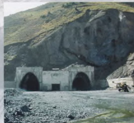
Северный портал автодорожного тоннеля Анзоб в Таджикистане
