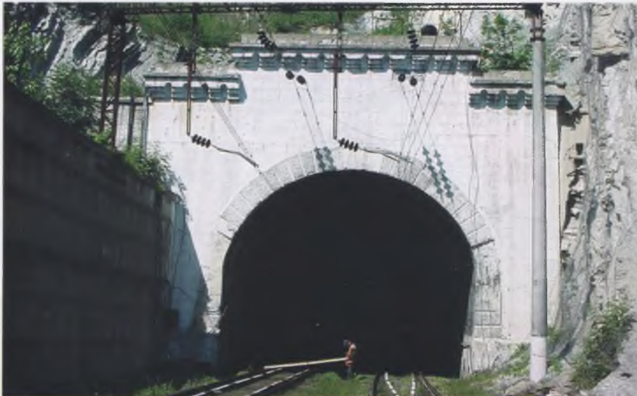
Южный портал существующего Большого Новороссийского тоннеля
