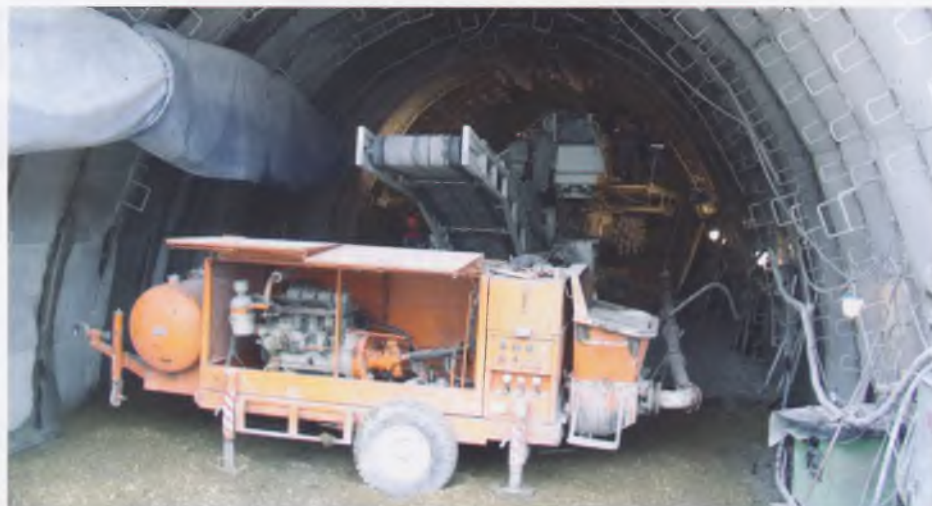
Проходка тоннеля со стороны Северного портала
