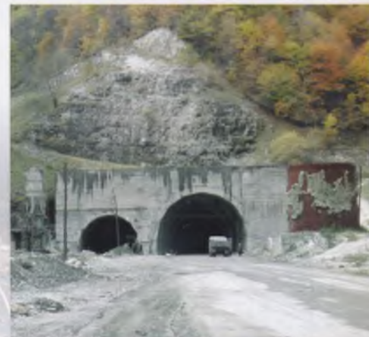
Северный портал Гимринского автодорожного тоннеля в Дагестане
