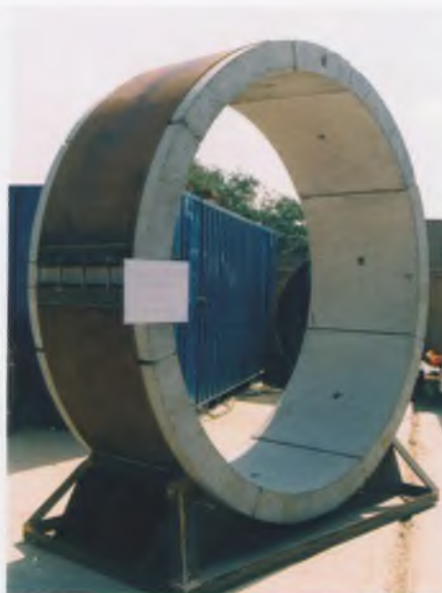
Собранное кольцо железобетонной обделки тоннеля, используемое на ТПМК «Ловат»
