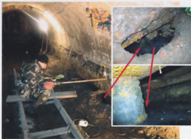
Специалисты ЗАО «Триада-Холдинг» ведут работы по зондированию обделки коллекторного тоннеля
