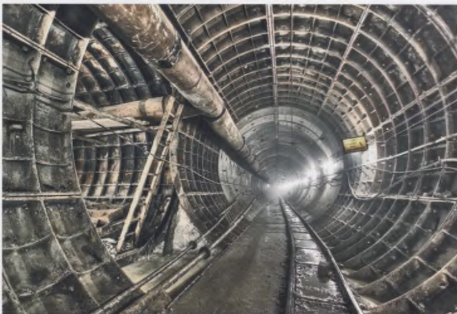
Правый перегонный тоннель «Сретенский бульвар» - «Трубная». Слева - примыкание венттоннеля
