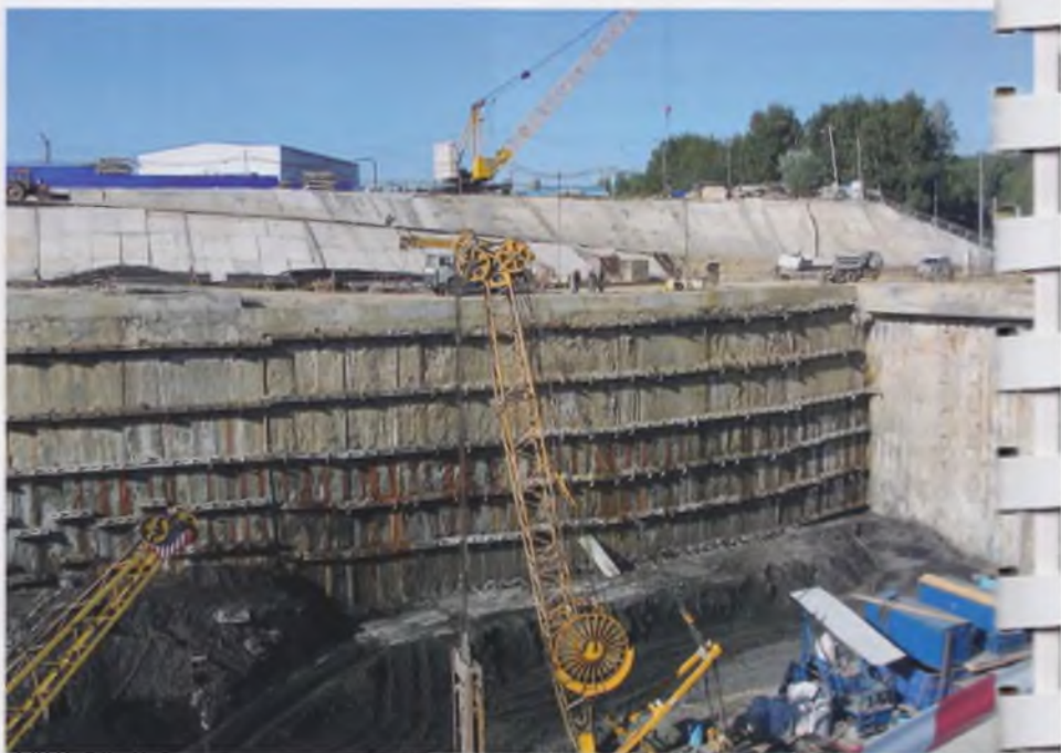
Метод «стена в грунте» в сочетании с грунтовыми анкерами получил широкое распространение на Московском метрострое
