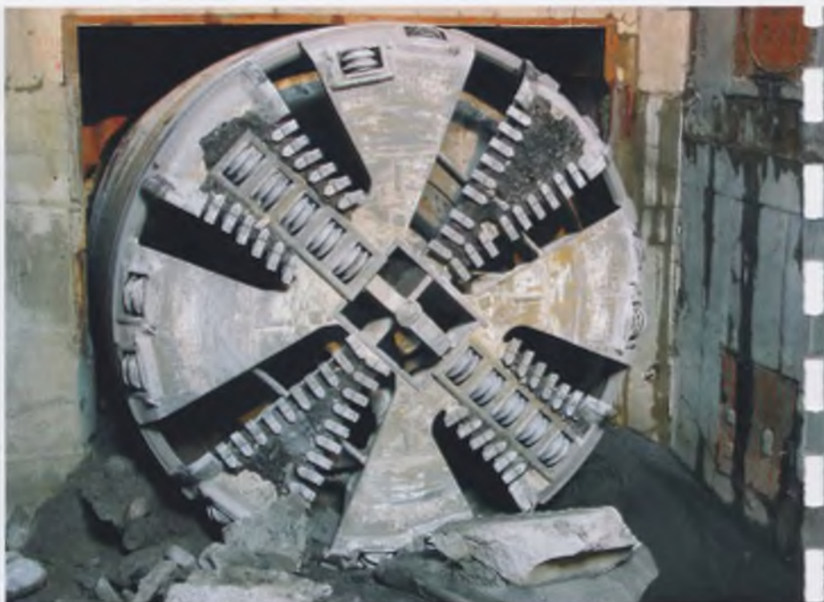
Завершена проходка сервисного тоннеля под Серебряноборским лесничеством
