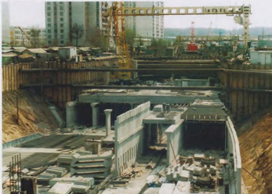
Строительство камер съездов за станцией «Бульвар Дмитрия Донского»
