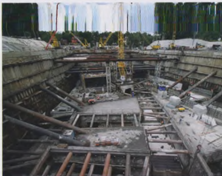
Участок открытого способа работ в точке «Д» Серебрянборских тоннелей
