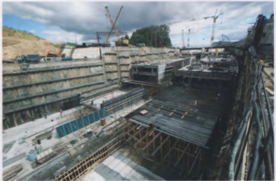
Сооружение тоннелей на участке Краснопресненского проспекта
