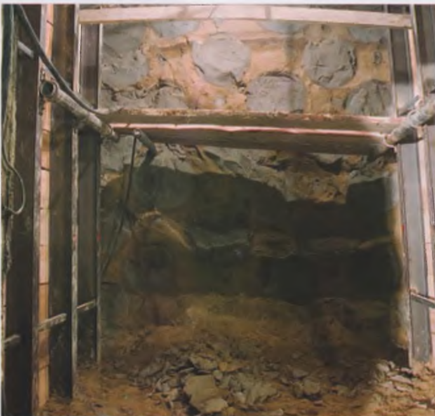
Грунтовый массив, закрепленный по технологии «jet-grouding» в сбойке № 5
