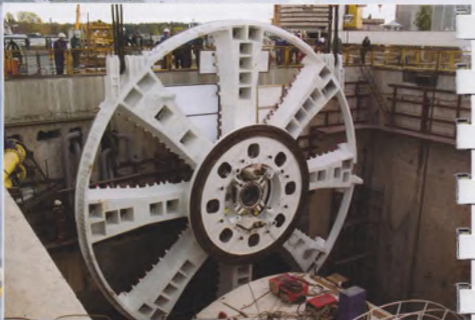
Монтаж ротора ТПМК «Херренкнехт» Ø14,2 м
