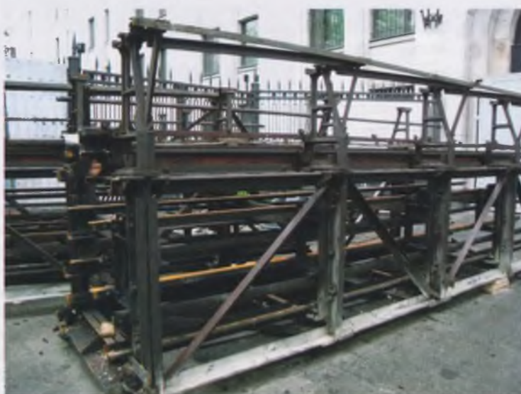
Демонтированная зона эскалатора на ст. «Арбатская»
