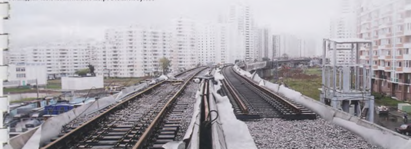
Эстакадная часть линии легкого метро в Южном Бутове
