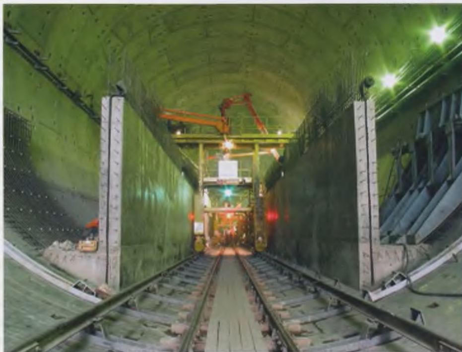
Сооружение тоннеля метрополитена в Серебряноборском тоннеле
