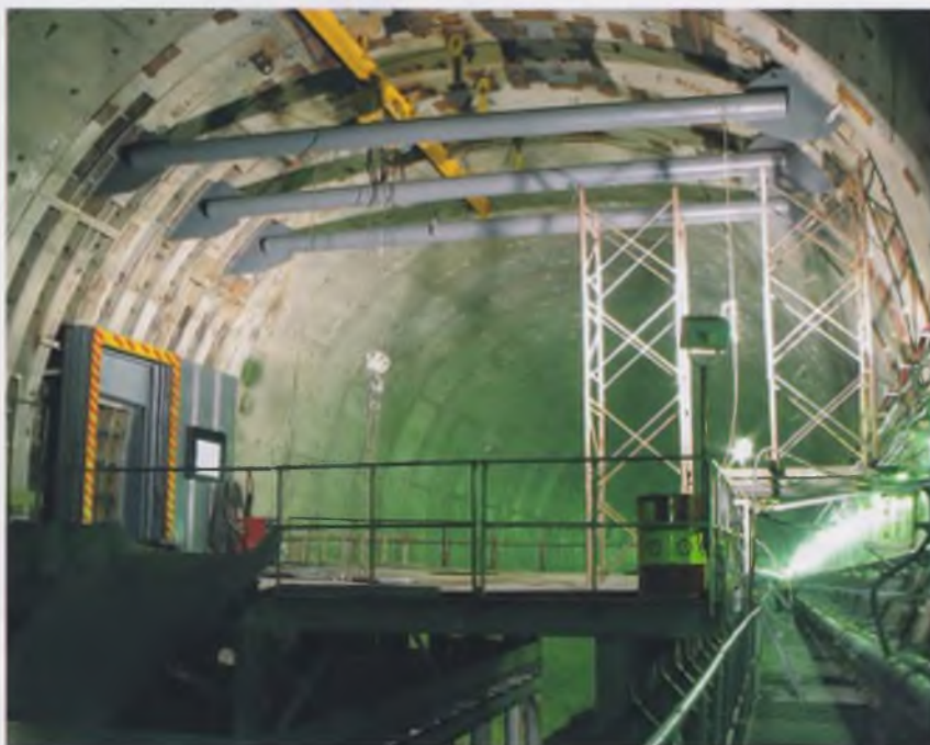
Подготовительные работы перед началом проходки сбойки № 5
