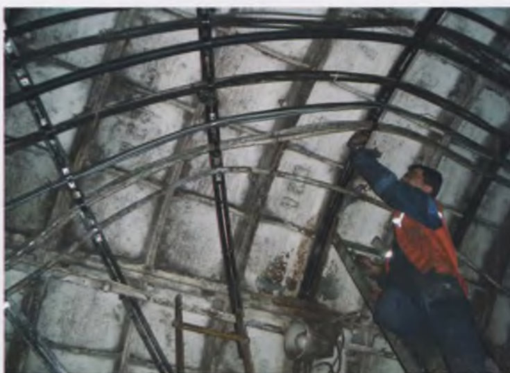
Монтаж кабелей на ст. «Трубная»
