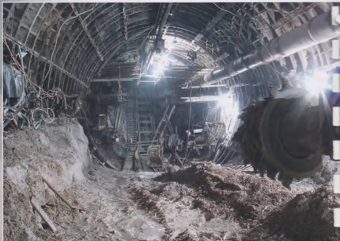
Разработка лотка в подводящем коридоре № 1 проходческим комбайном
