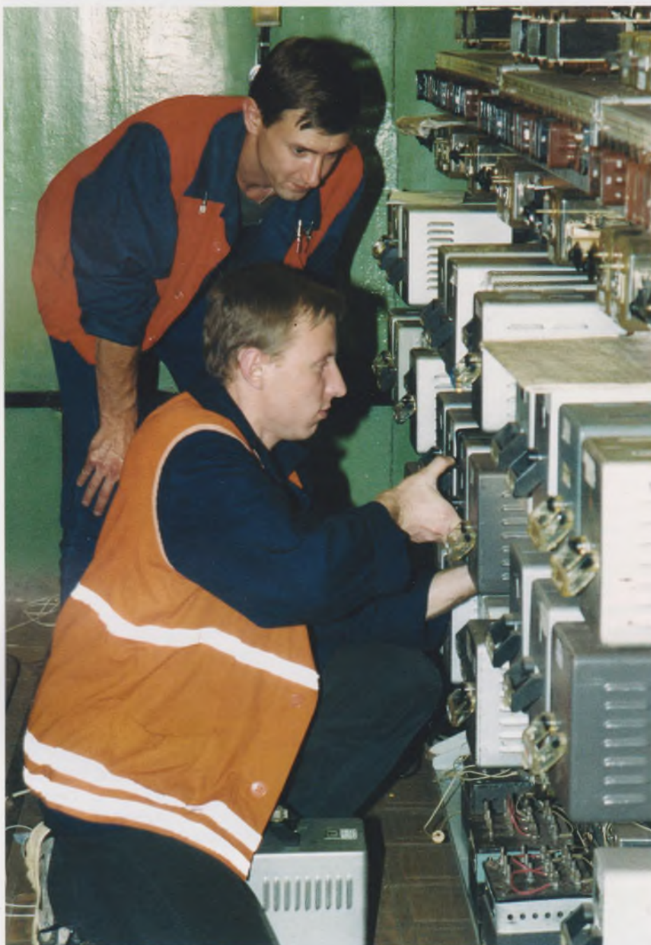
Замена аппаратуры рельсовых цепей в релейной
