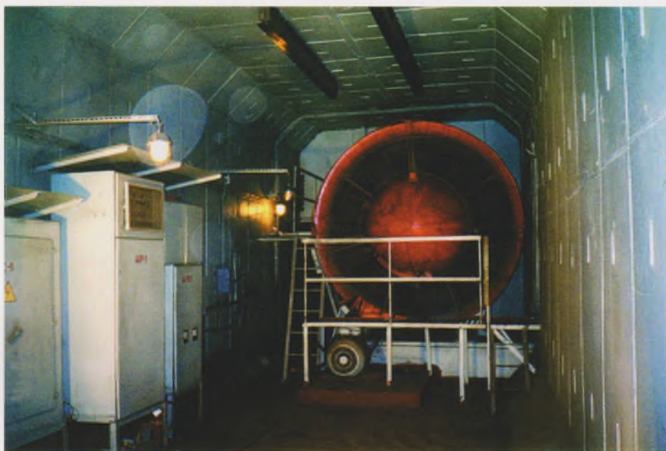
Реконструируемая вентиляционная шахта
