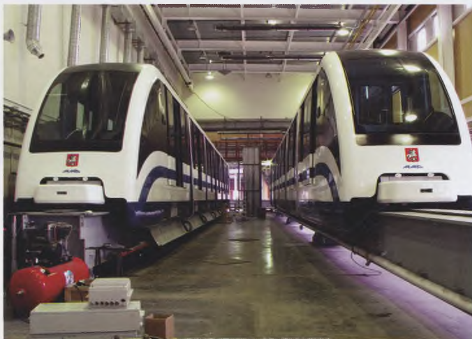
Рис. 4. В депо: слева – пункт текущего ремонта, справа – диагностики
