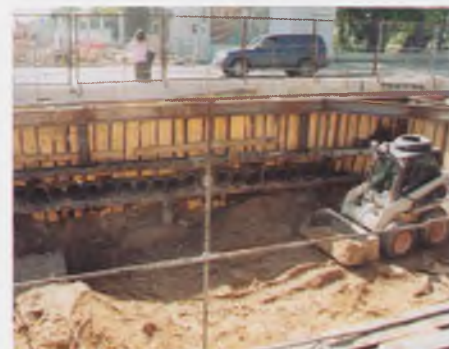
Рис. 4. Углубление котлована
