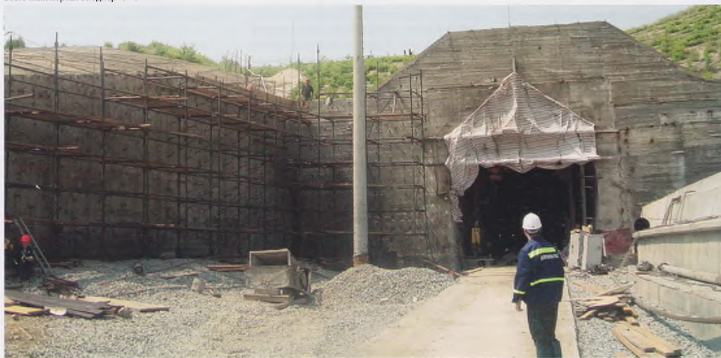
Восточный портал с подпорной стенкой
