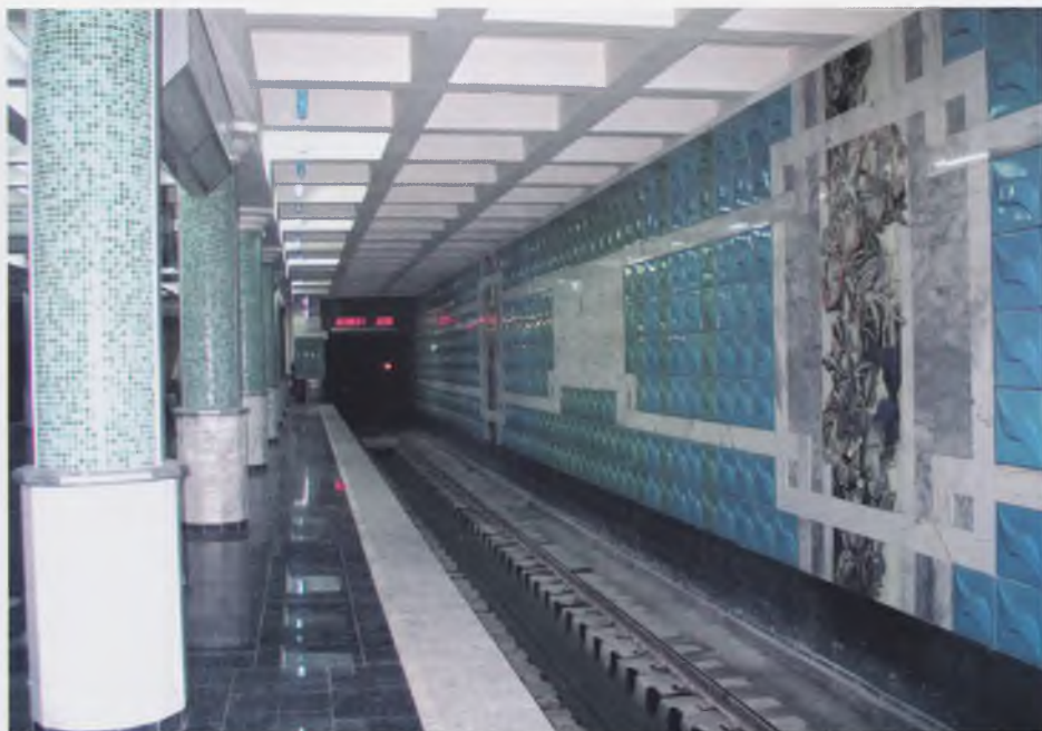
Рис. 6. Путевая стена ст. «Ботанический сад» с художественными вставками
