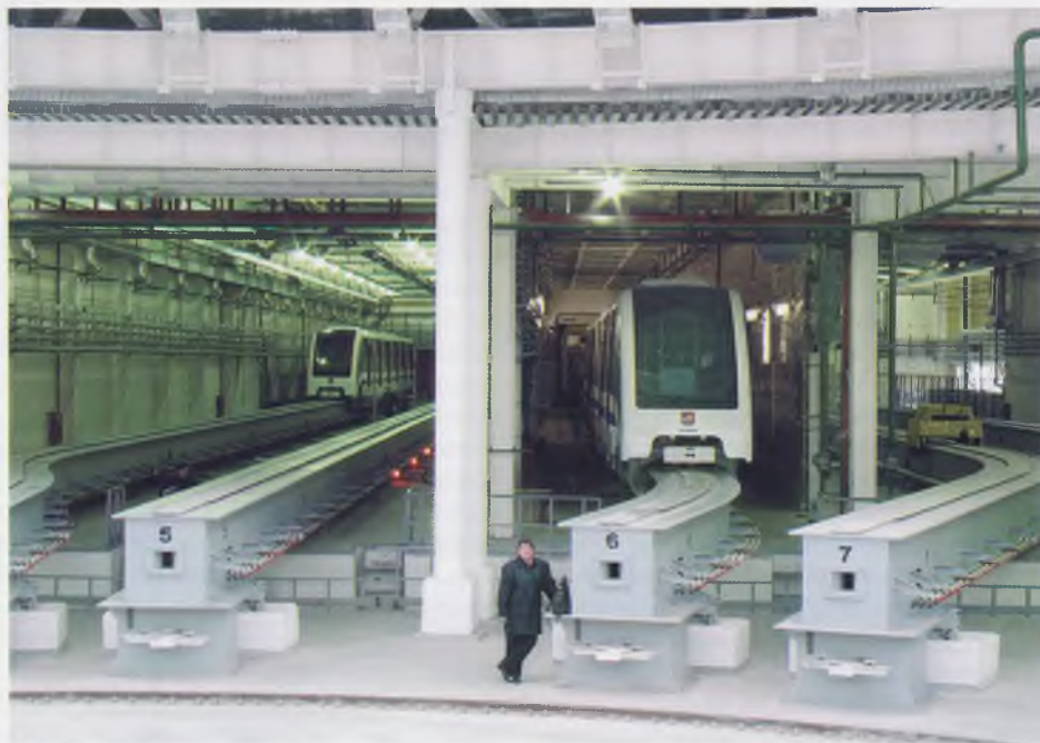
Пути для отстоя составов
