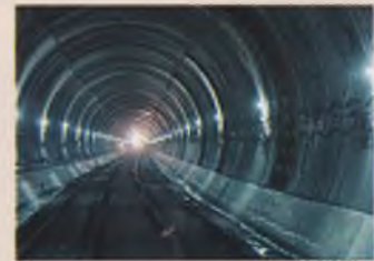
Внутренний вид тоннеля
