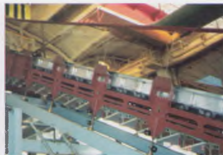
Рис. 10. Металлоконструкция эскалатора ЭТХ (с зеркальными щитами балюстрады) на регулируемых винтовых опорах с виброподушками изолирована от бетона и не подвержена коррозии
