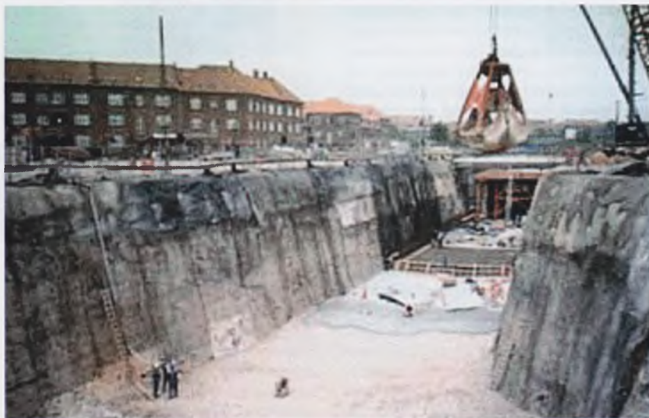
Рис. 4. Крепление стен котлована анкерными сваями «Титан», используемыми в качестве нагельного крепления
