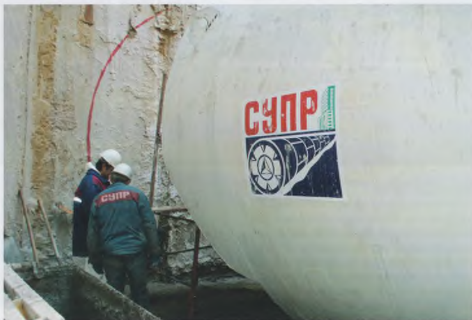
ТПМК фирмы CSM «BESSAC» в стартовом котловане
