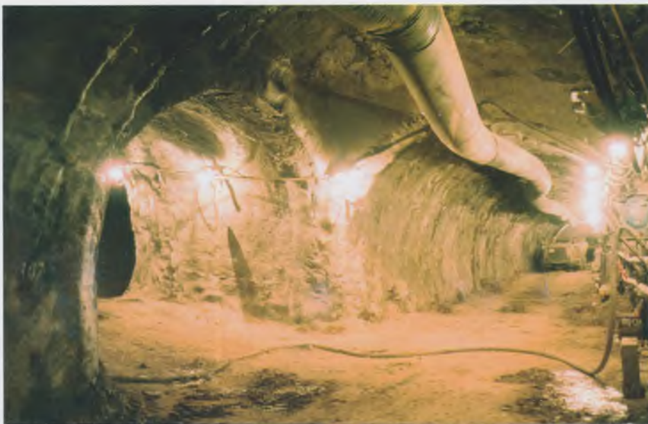
Вид на сбойку между центральной и северной штольнями
