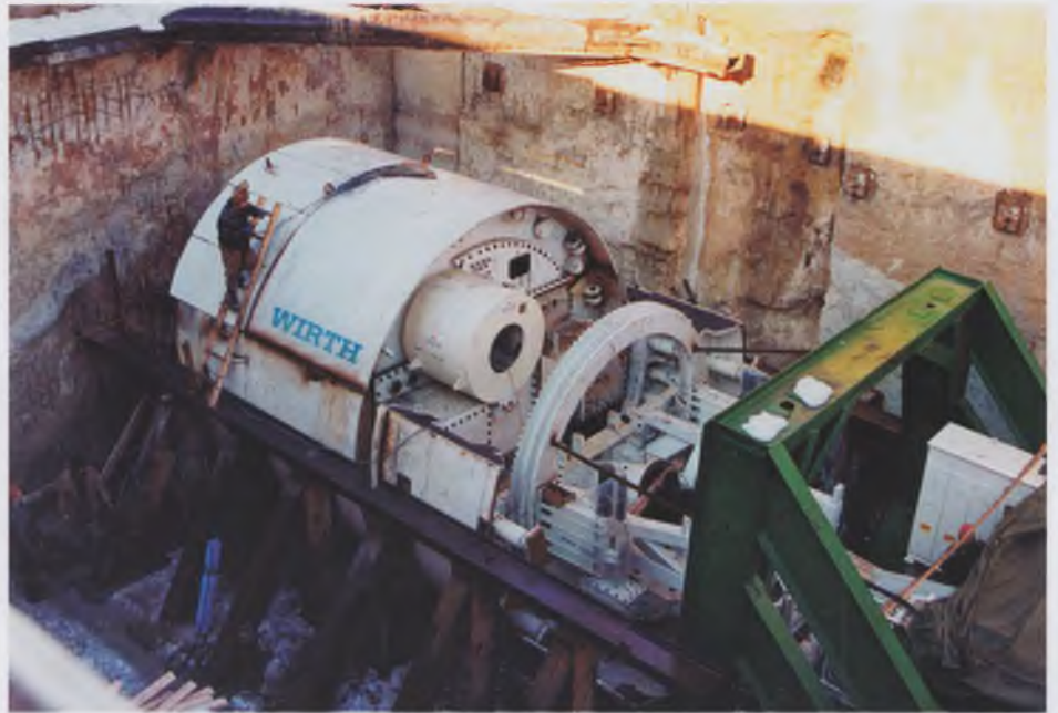
Монтаж щитового механизированного комплекса фирмы «WIRTH» на перегоне «Святошин» – «Житомирская»
