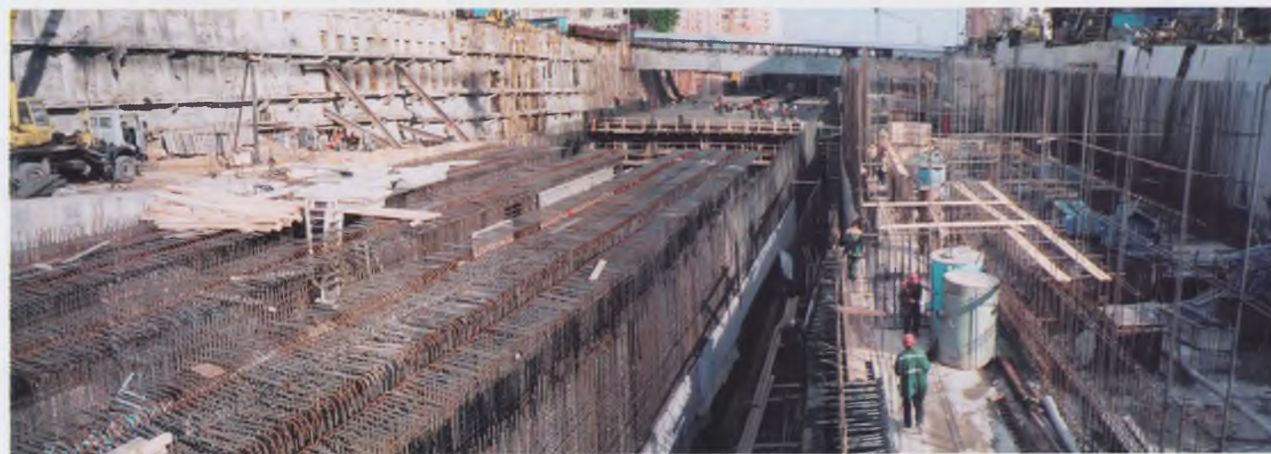
Рис. 8. Точка «А». Панорама строительства тоннелей обоих направлений на участке от демонтажной камеры до ул. Ф. Энгельса, июль 2003 г.
