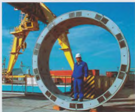
Рис. 7. Обделка тоннеля диаметром 3,5 м
