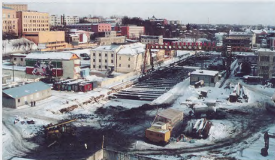
Котлован станции метро «Площадь им. Тукая» в г. Казани
