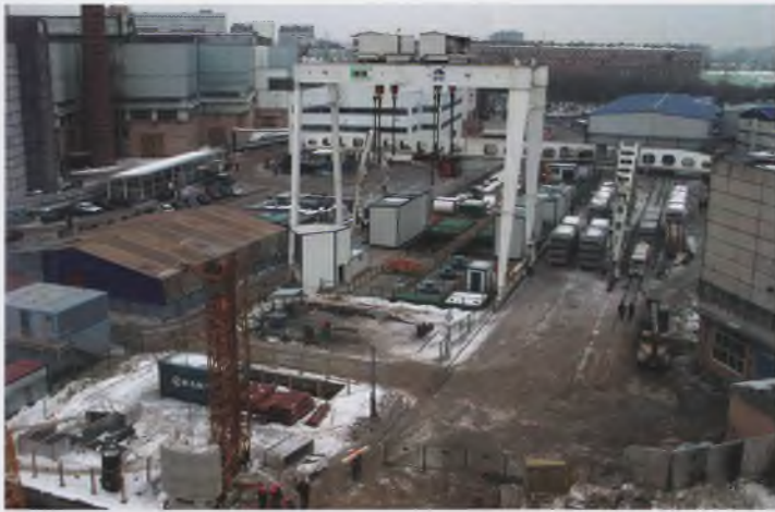
Рис. 4. Точка «В». Базовая стройплощадка. Вид с северной эстакады, январь 2003 г.
