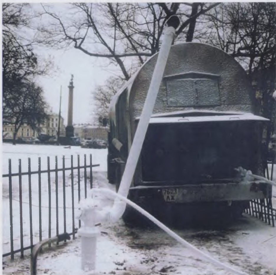
Рис. 1. Установка для подмораживания затрубного пространства технологических скважин
