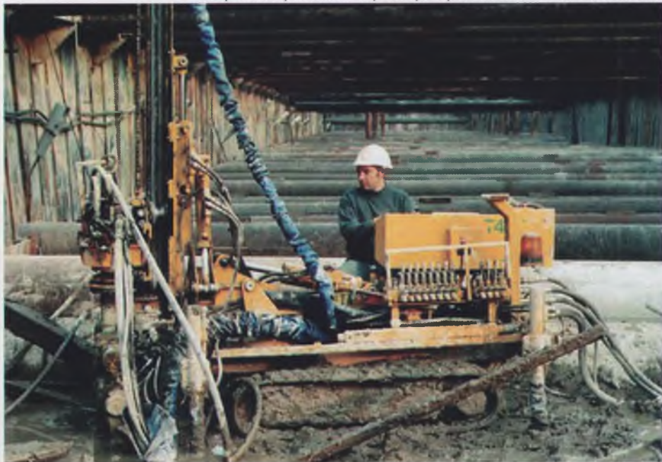
Устройство горизонтальной противοфильтрационной завесы в днище котлована
