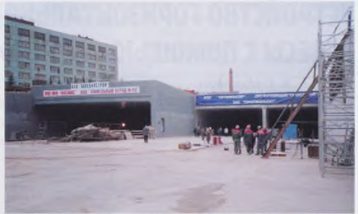
Рис. 11. Портал тоннеля в точке «В»
