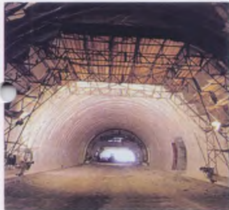
Устройство пленочной гидроизоляции. Автодорожный тоннель на трассе Измир-Айдын
