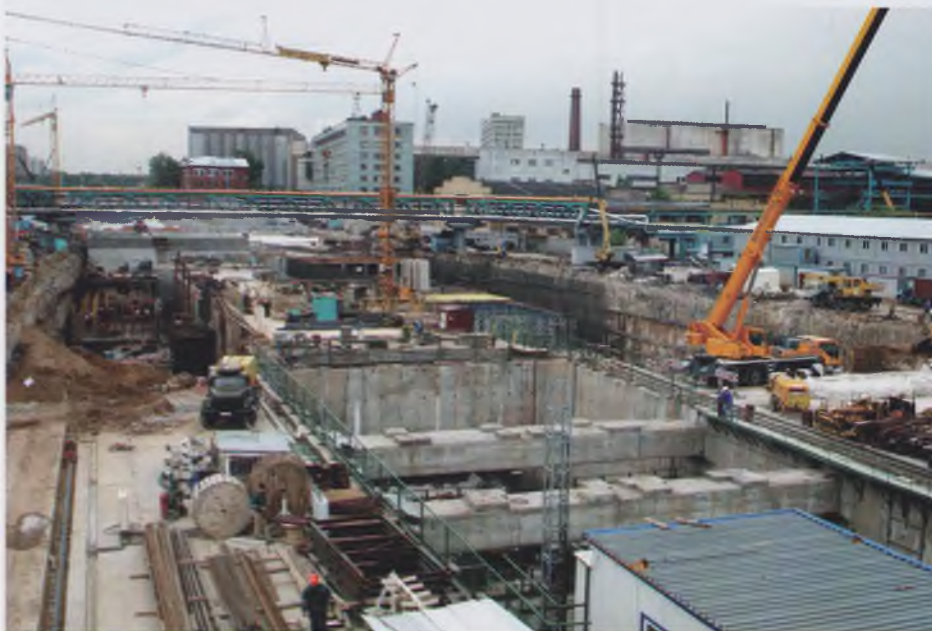
Панорама строительства. Точка «В» июль 2003 г.
