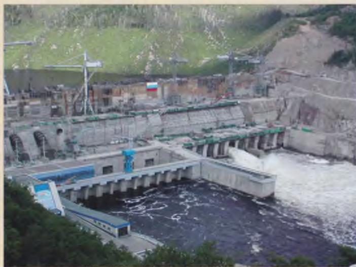
Плотина Бурейского гидроу-
