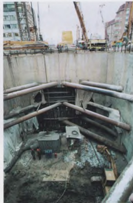
Рис. 9. Крепление демонтажной камеры
