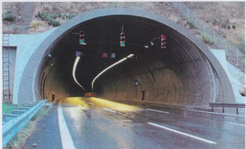
Портал автодорожного тоннеля на трассе Измир-Айдын
