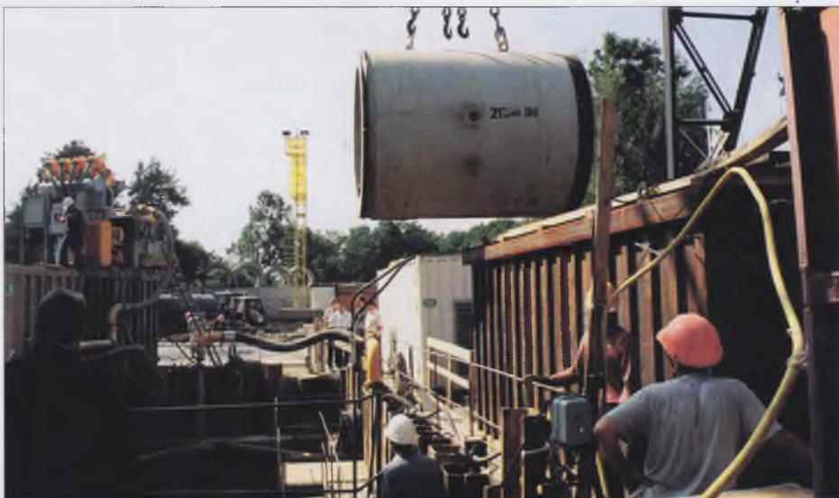
Процесс подачи труб в стартовый котлован
