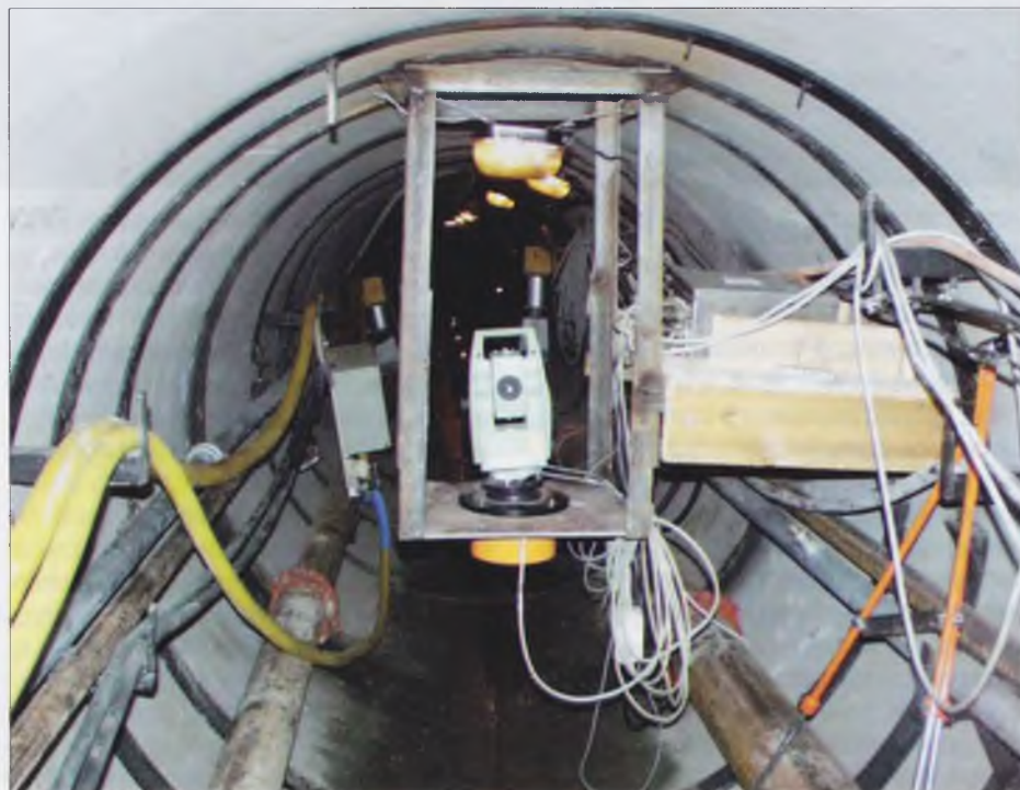
Вид готового тоннеля с системой наведения AVN 2000
