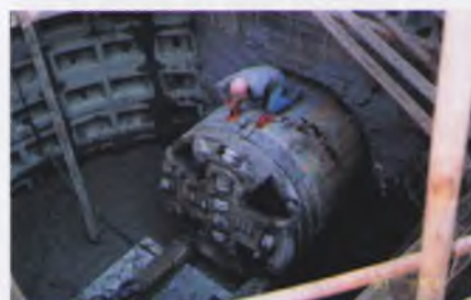
Выход щита AVN-2000
