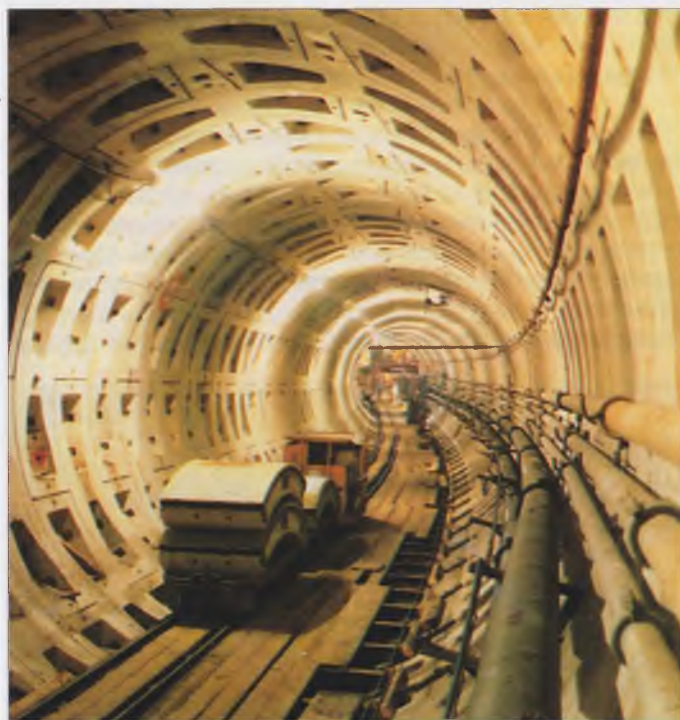
Строительство перегона на линии 7
