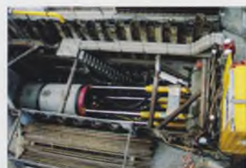
Стартовый котлован с пресс-рамой и трубой наружного диаметра 2,5 м
