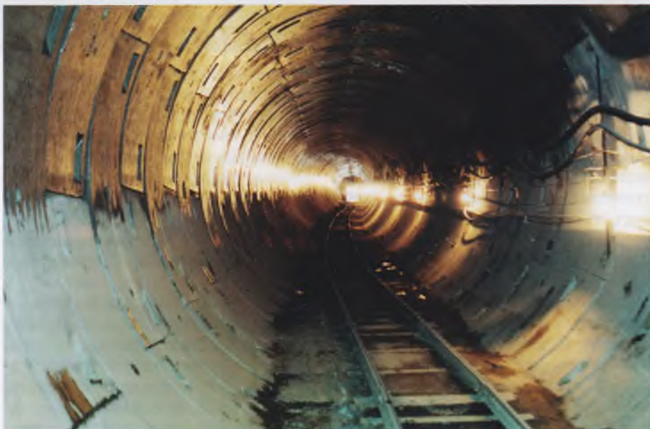
Вид готового тоннеля
