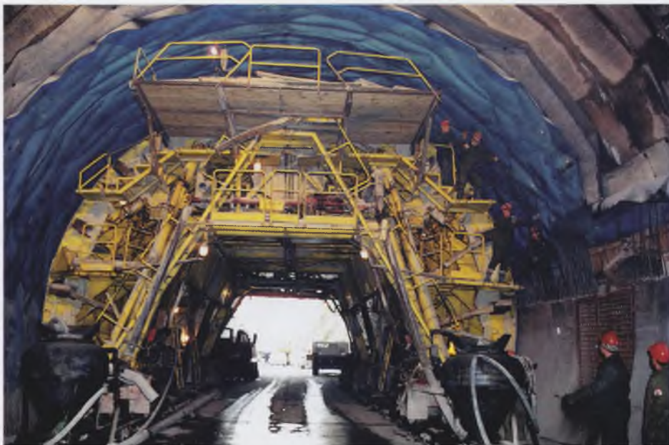
Устройство гидроизоляции на Краснополяском тоннеле
