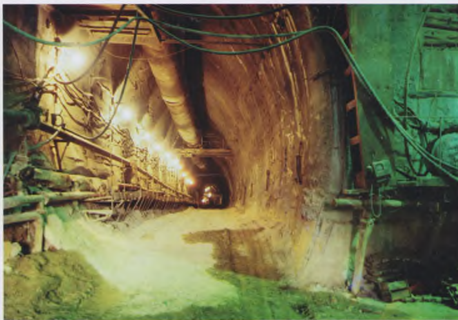
Рис. 2. Штольня "Северная" с НБ крепью
