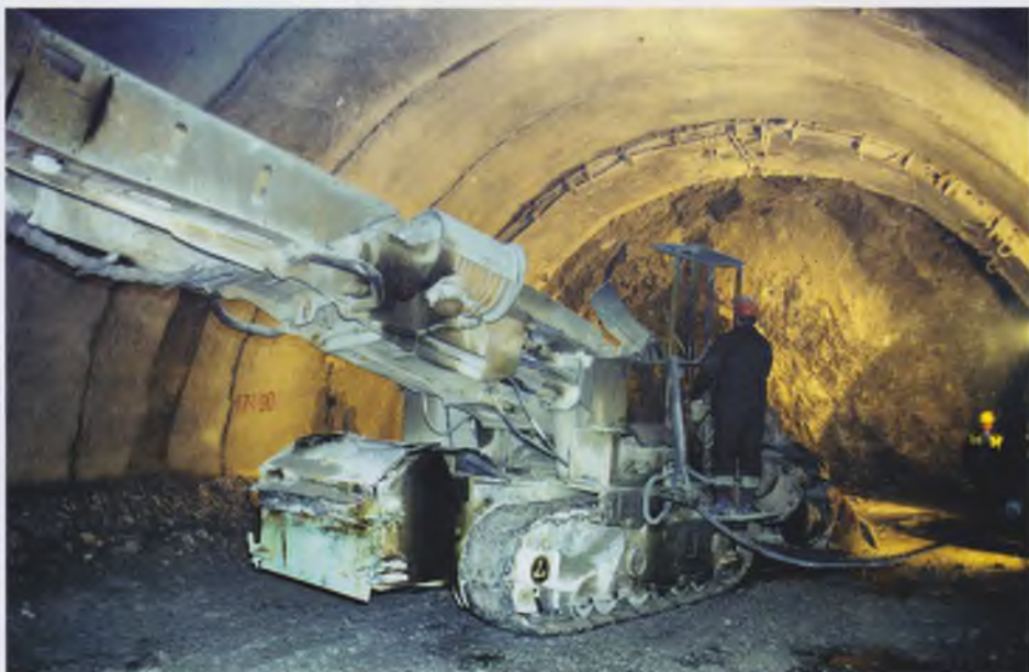
Погрузка грунта породопогрузочной машиной ПНБ-4
