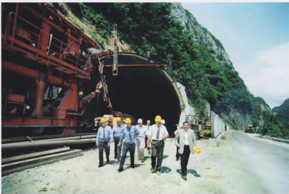
Строительство Краснополянского тоннеля
