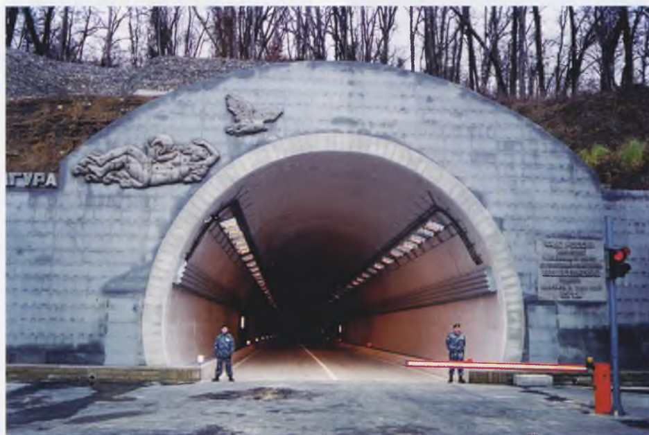
Южный портал Мацестинского тоннеля
