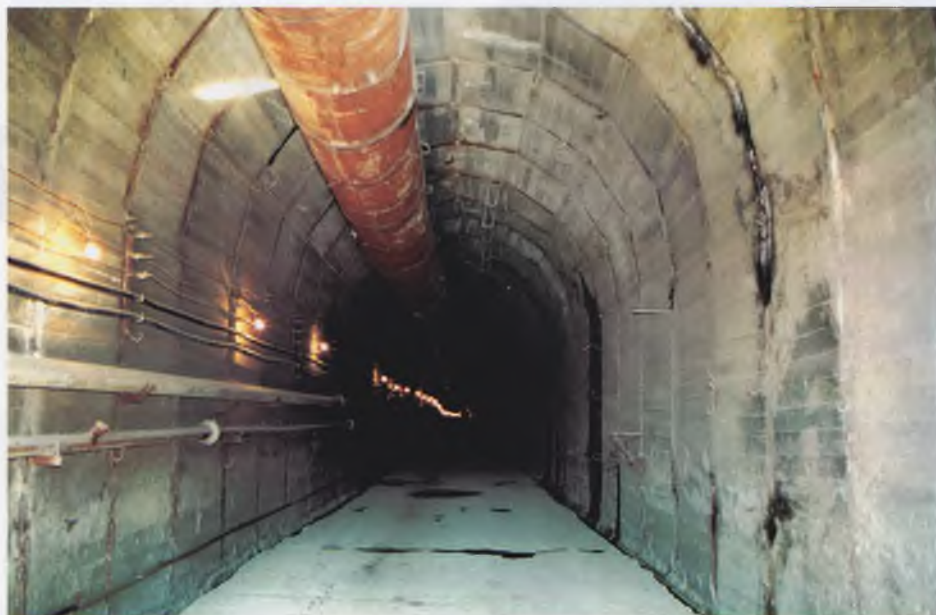
Дренажно-вентиляционная штольня Шаумянского автодорожного тоннеля
