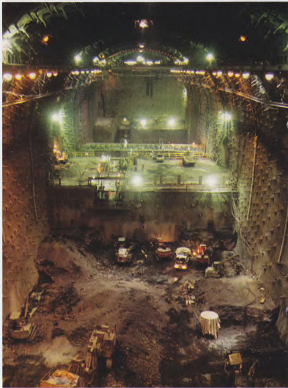
Рис. 1. Машинный зал ГАЭС Казуногава в период строительства
