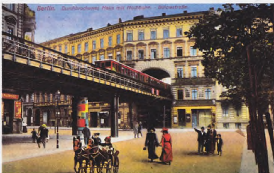
Участок линии метро, проходящей через жилое здание
