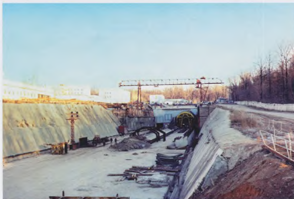
Рис. 3. Разработка тоннеля открытым способом
