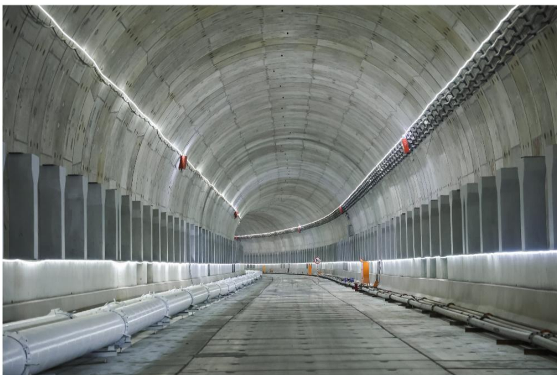
Строящийся тоннель метрополитена в Шанхае.
