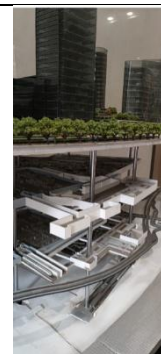
Макет многослойного подземного пространства, Шанхайский институт муниципального инженерного проектирования.
