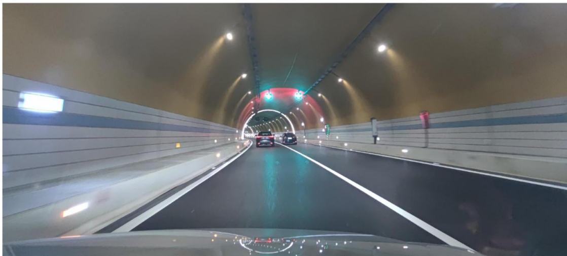
Тоннель в Шенянге.
