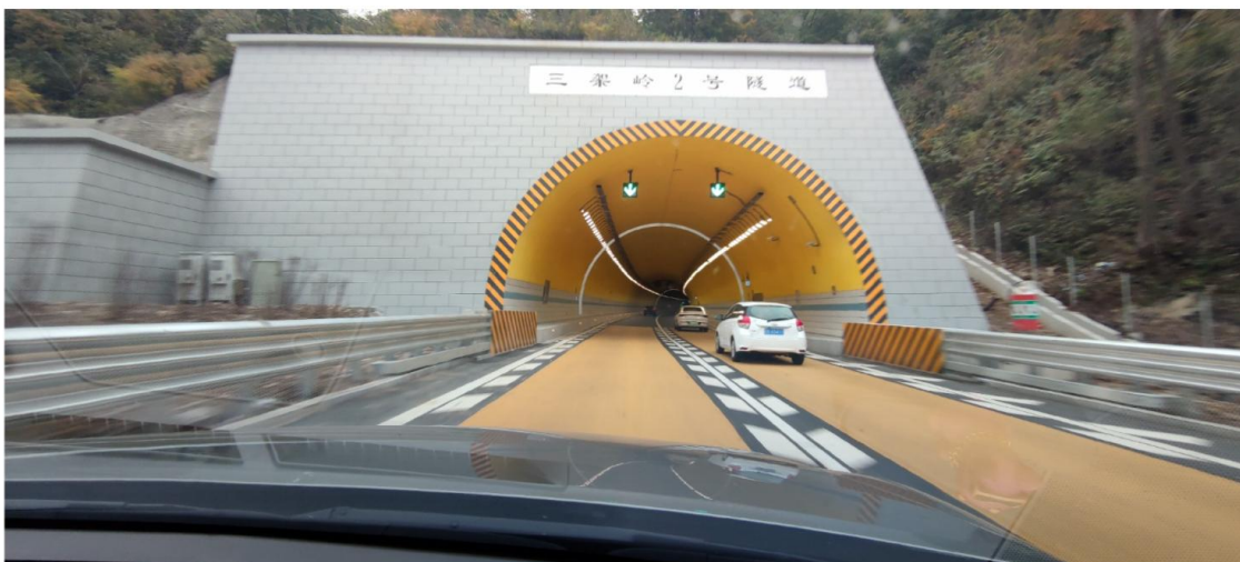
Тоннель в Шенянге.
