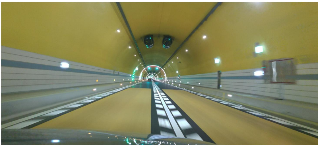
Тоннель в Шенянге.
