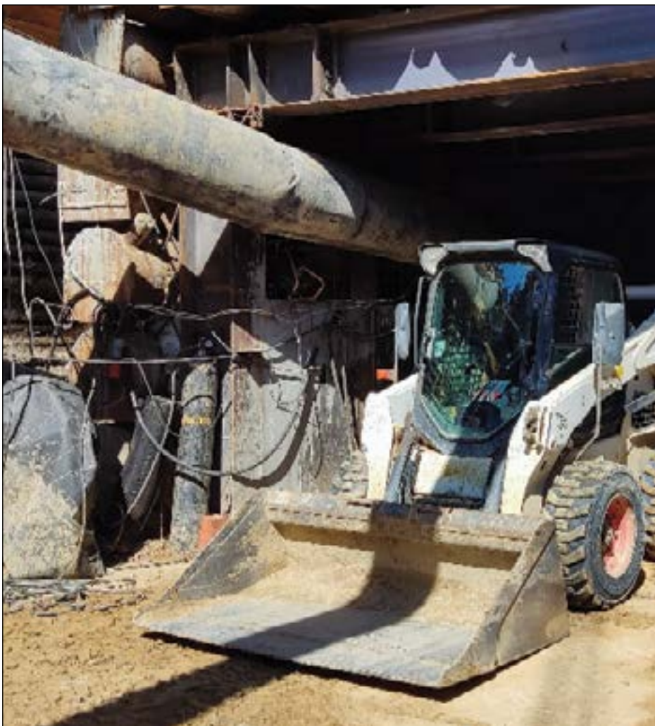
Рис. 13. Разработка грунта малогабаритной техникой
