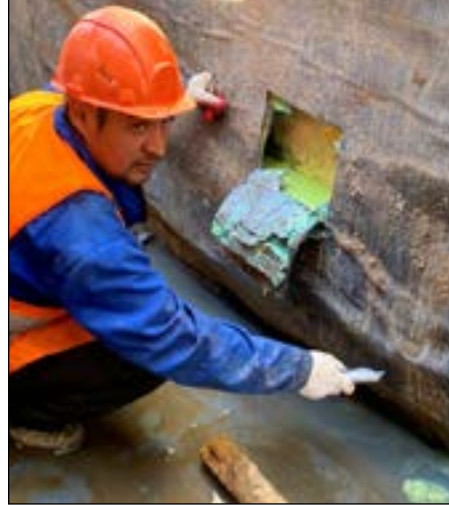
Рис. 4, 5, 6. Работы по вскрытию проинъектированных участков
