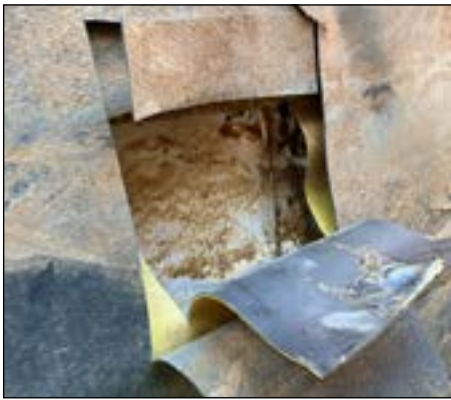
Рис. 7, 8. Сплошной гидроизоляционный слой заполимеризованного метакрилатного геля HansaCryl Gel 3 Plus
