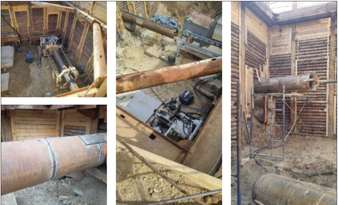
Рис. 12. Работы по устройству экрана из труб
