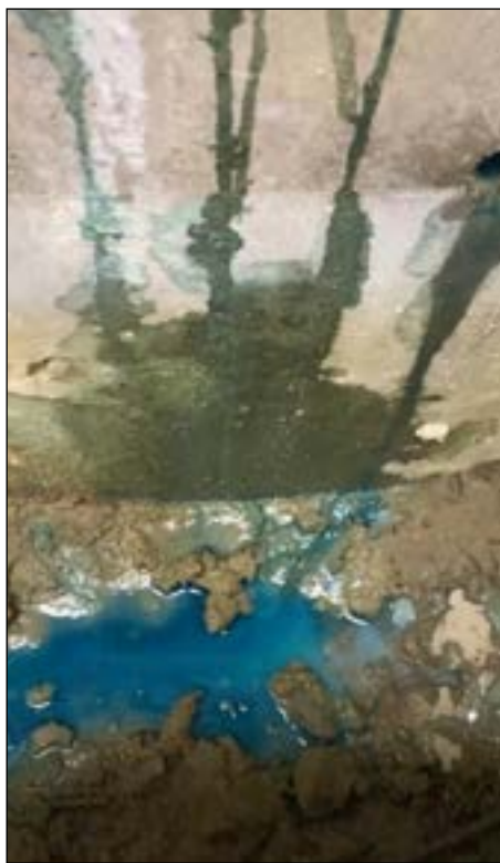
Рис. 3. Инъектирование метилметакрилатного геля Hansacryl Gel 3 Plus
