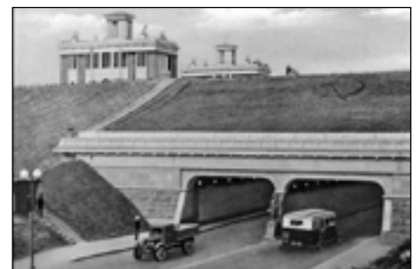
Рис. 1. Подводный тоннель под каналом им. Москвы, 1937 г.
