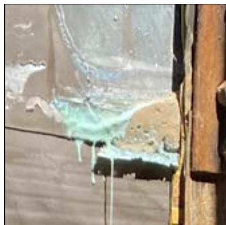
Рис. 12. Присутствие незаполимеризованного геля
