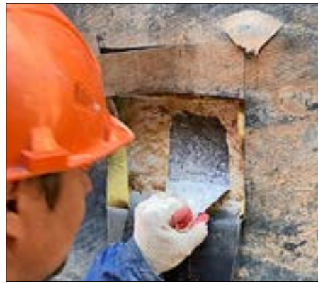
Рис. 7, 8. Сплошной гидроизоляционный слой заполимеризованного метакрилатного геля HansaCryl Gel 3 Plus
