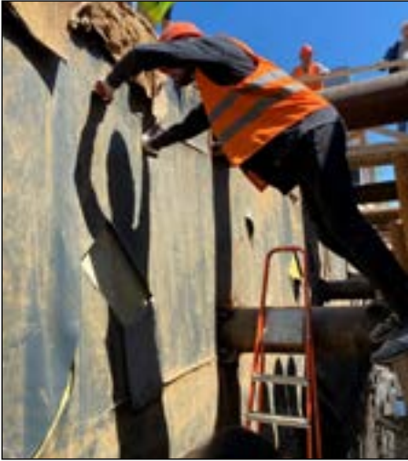
Рис. 4, 5, 6. Работы по вскрытию проинъектированных участков
