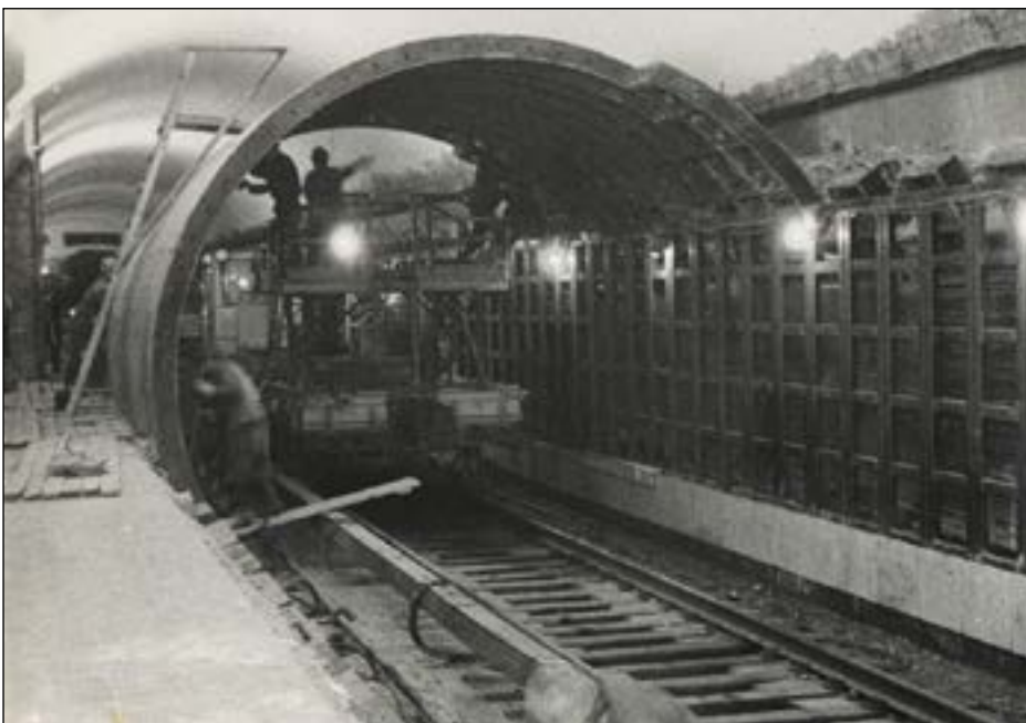
Рис. 11. Разборка части чугунной обделки перегонного тоннеля в ночные окна. Чугунная обделка сооруженного свода бокового станционного тоннеля оформлена монолитным железобетонным зонтом
