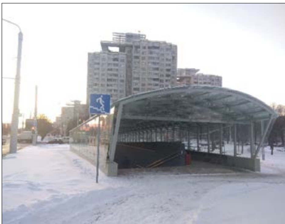
Рис. 15. Вход в подземный пешеходный тоннель
