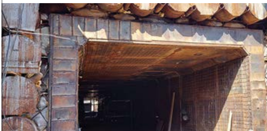
Рис. 14. Металлоизоляция пешеходного тоннеля
