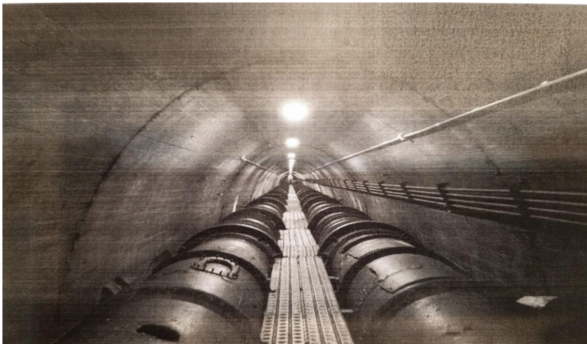
Рис. 5. Донный водоспуск Тушинского гидроузла, 1937 год.
