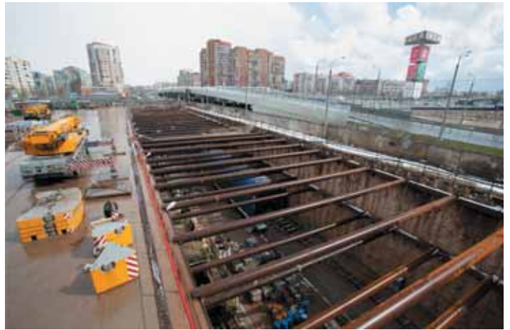
Станция на пересечении ул. Фучика и ул. Ломжинской
