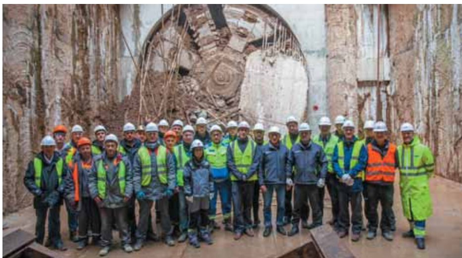
Выход щита «Натали» на станции «Звенигородская»
