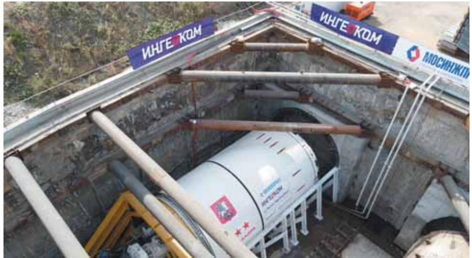
Запуск щита «Александра» на станции «ЗИЛ»
