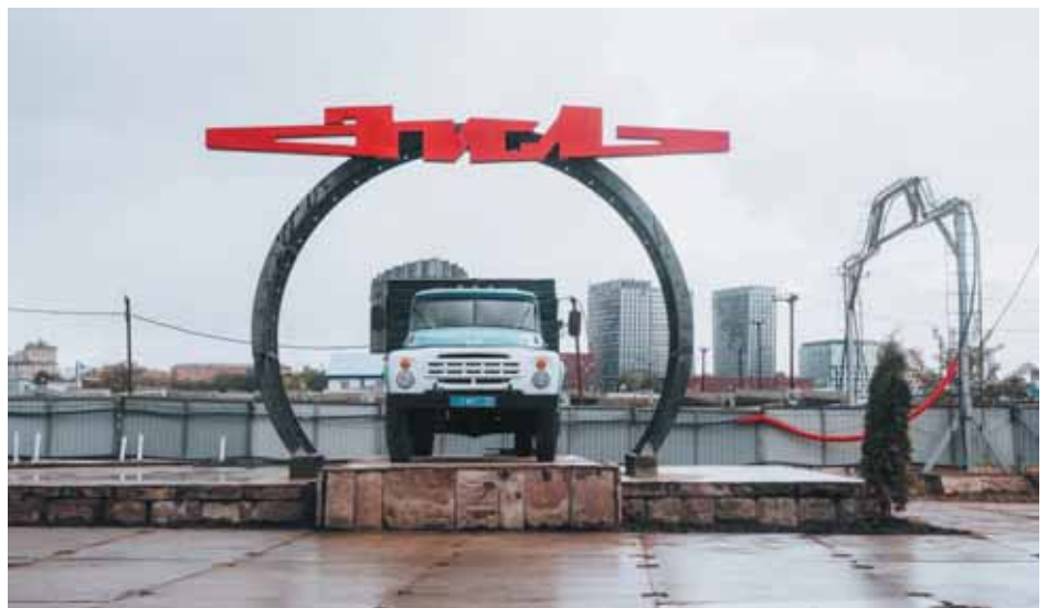
Стройплощадка станции метро «ЗИЛ» Троицкой линии
