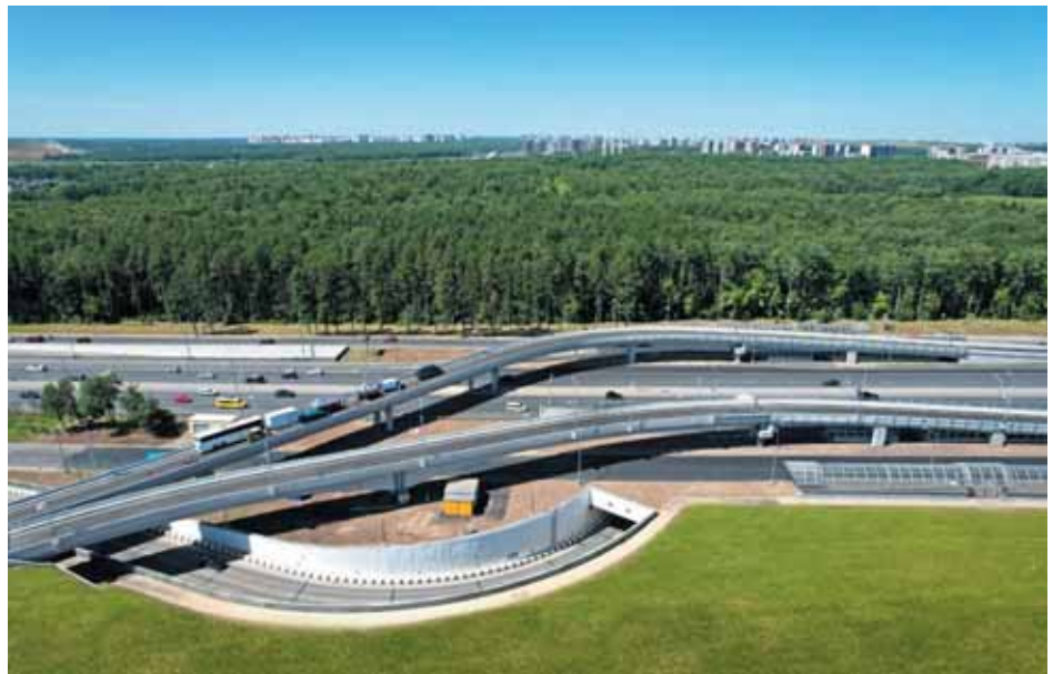
Эстакады и тоннель в посёлке «Коммунарка»
