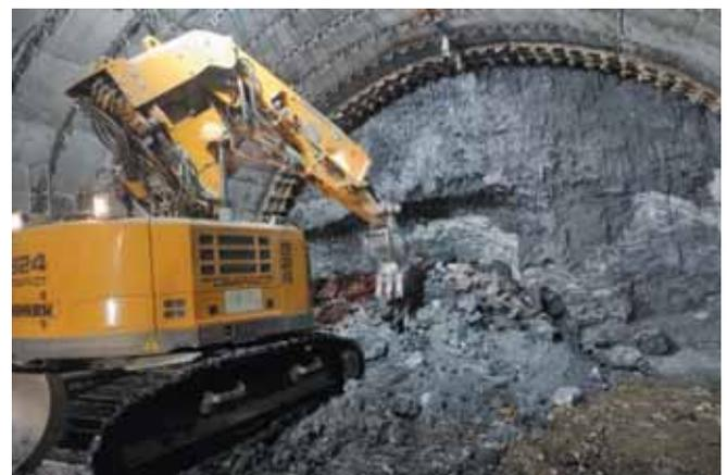
Рис. 4. Разработка грунта механизированным способом
