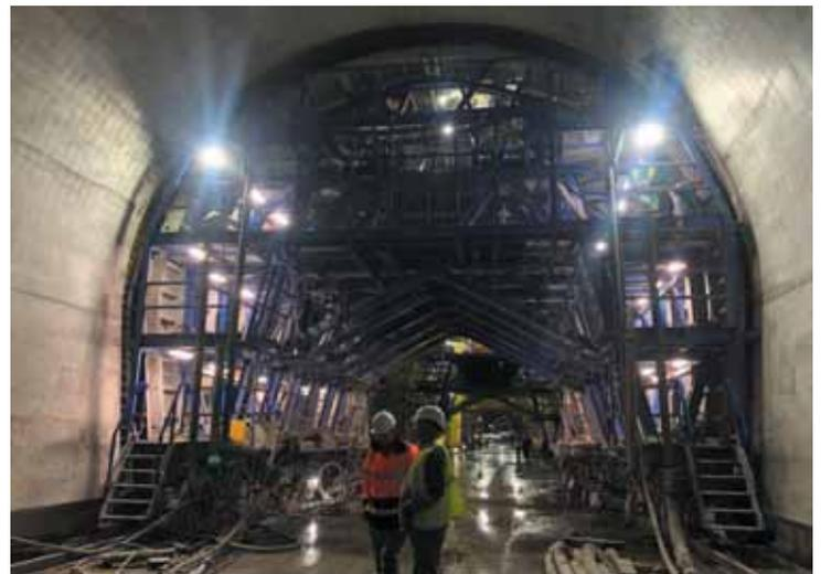
Рис. 12. Передвижная механизированная опалубка «ГАММА»
