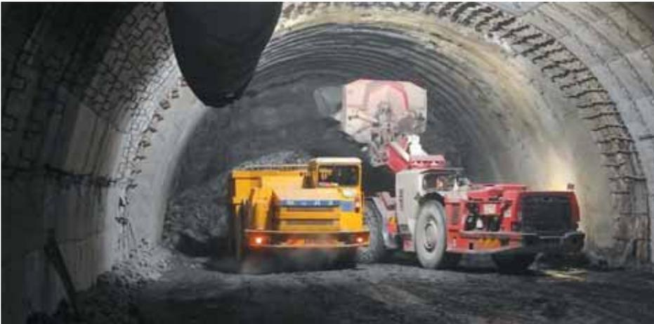
Рис. 6. Погрузка породы после взрыва
