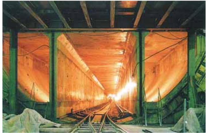
Рис. 12. Серебряноборский транспортный тоннель (слева – автодорожный, верхний ярус; справа – метротоннель, нижний ярус)
