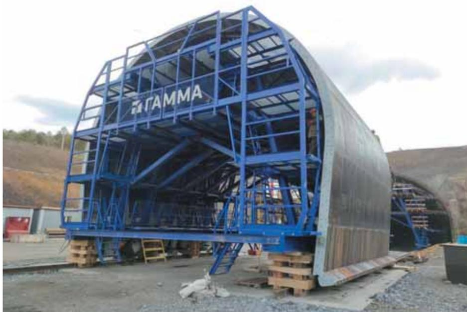
Особенностью опалубки является механизированное изменение ширины сечения для бетонирования прямолинейных и криволинейных участков тоннеля непосредственно внутри сооружения.
