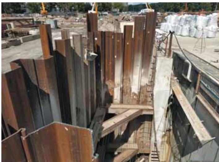
Рис. 7. Отсутствие возможности погружения шпунта на требуемую глубину для всех шпунтин
