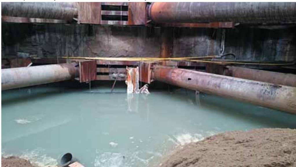
Рис. 4. Процесс откачки воды из плохо затампонирующей геологоразведочной скважины в пятне котлована
