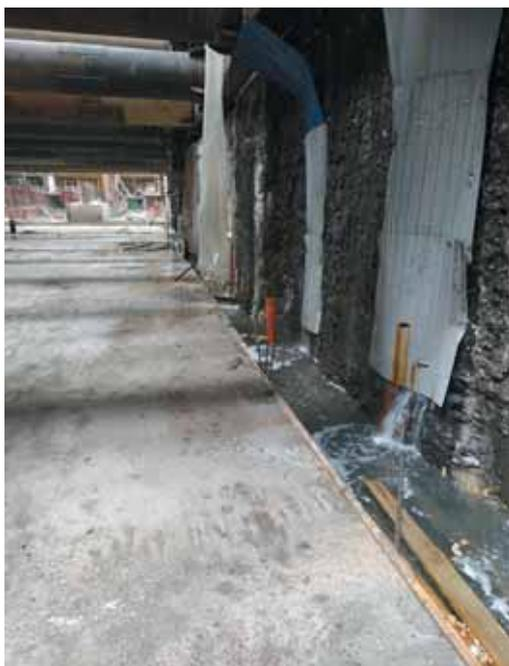
Рис. 1. Поступление в котлован грунтовых вод через дефекты «стены в грунте», находящиеся выше дна котлована
