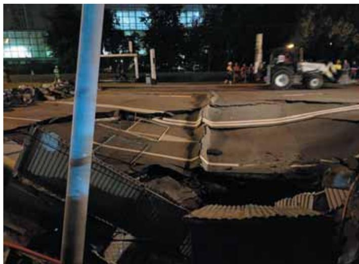
Рис. 8. Сверхнормативные деформации окружающего массива грунта и временных сооружений около котлована
