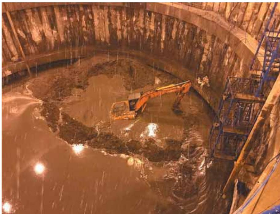
Рис. 2. Процесс затопления котлована пльвуном, поступающим через дефекты (в ограждении котлована), находящиеся ниже его дна
