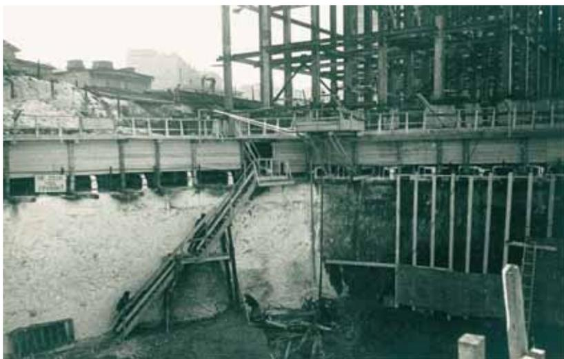
Рис. 3. Вид на котлован под промежуточный вестибюль с монтируемым на его краю 100-метровым каркасом центральной части высотного здания
