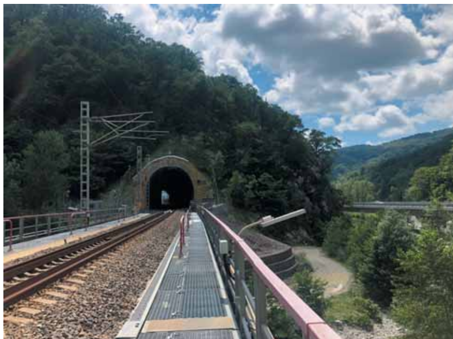
Рис. 3. Железнодорожный тоннель № 2 Олимпийской трассы Адлер – «Альпика-Сервис»
