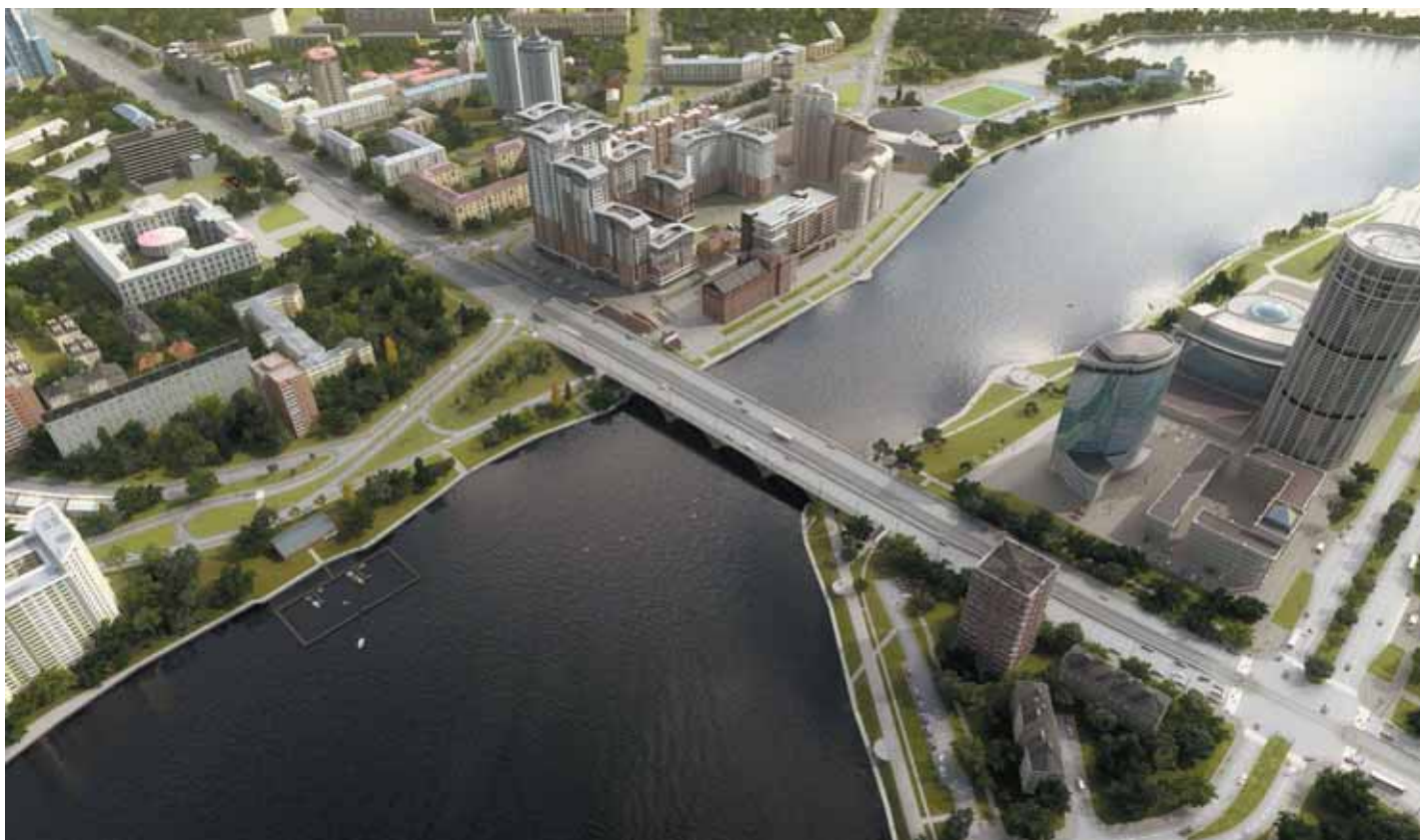
Реконструкция моста через р. Исеть по ул. Челюскинцев и прилегающей к нему улично-дорожной сети в Екатеринбурге
