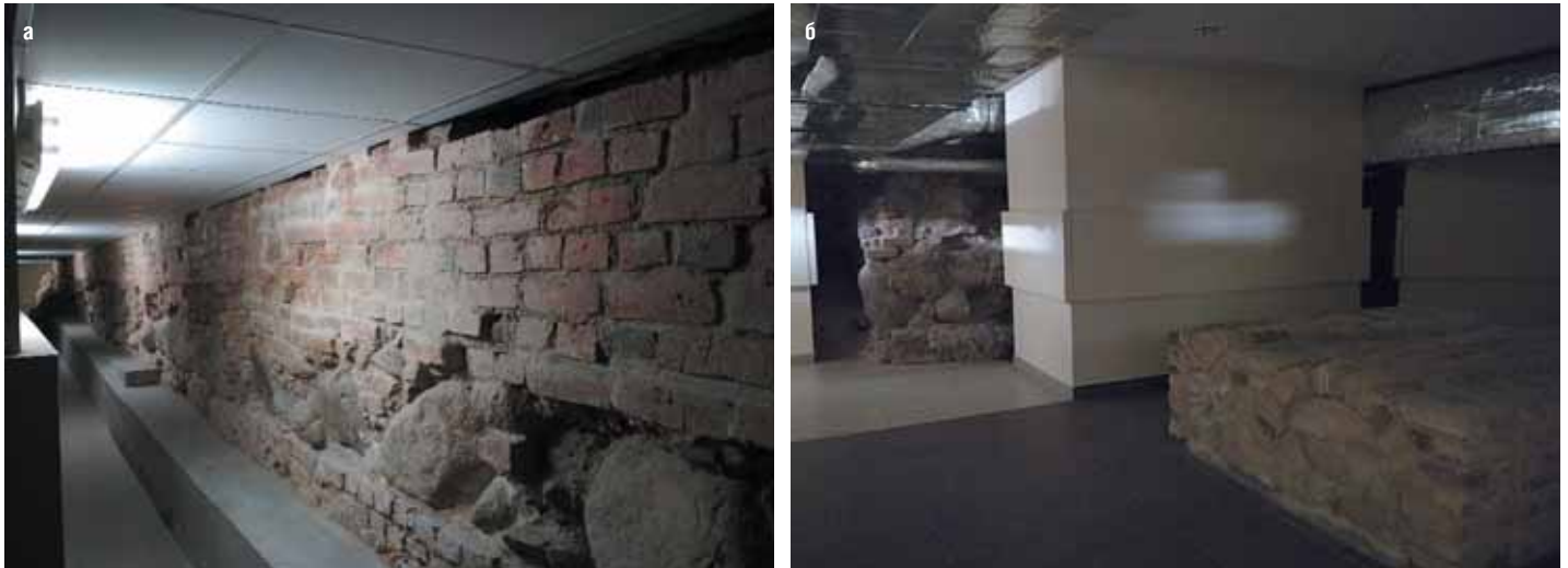
Рис. 8. Подвал концертного зала, 2020 г.: а – сохранившиеся фундаменты; б – опорные пилоны в апсидной части. За съемными экранами расположены виброизоляторы
