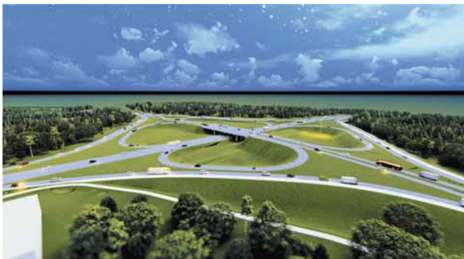
Транспортная развязка в разных уровнях по типу «клеверный лист» на пересечении проектируемого мостового перехода через Нижнетагильский пруд с автомобильной дорогой в г. Нижнем Тагиле
