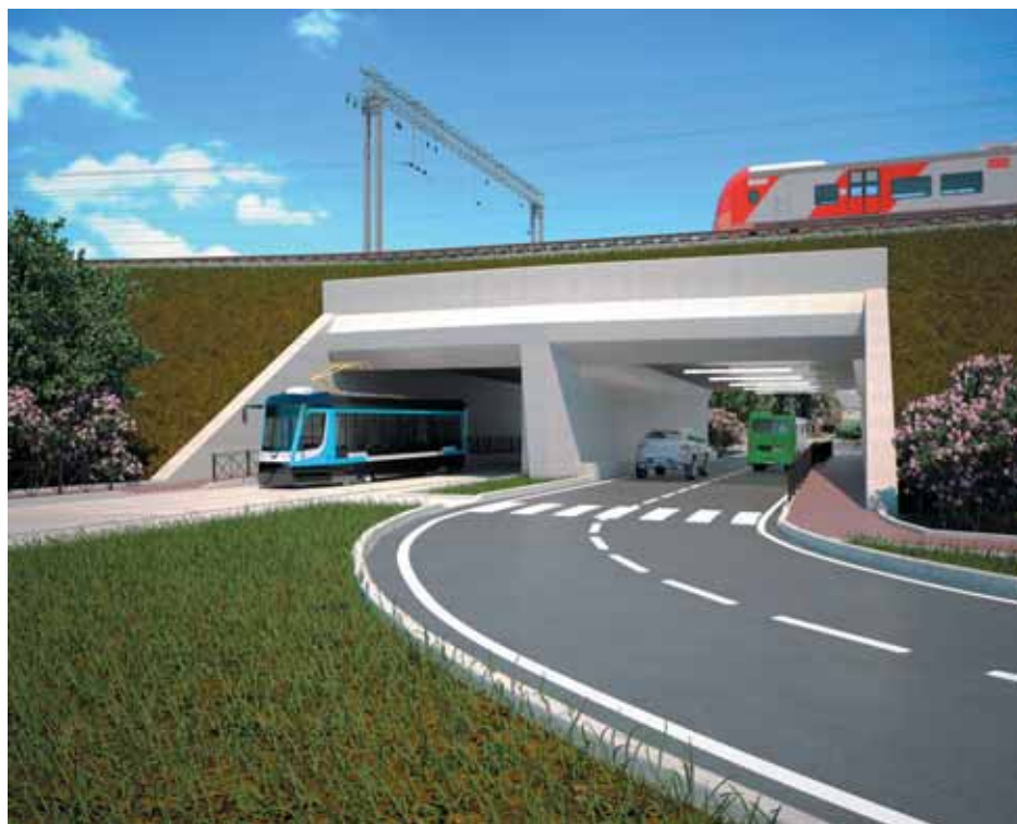
Транспортный тоннель на пересечении улицы Углеуральской с Транссибирской магистралью в г. Перми, предназначенный для пропуска двухполосной проезжей части для автомобильного движения и двухпутной трамвайной линии
