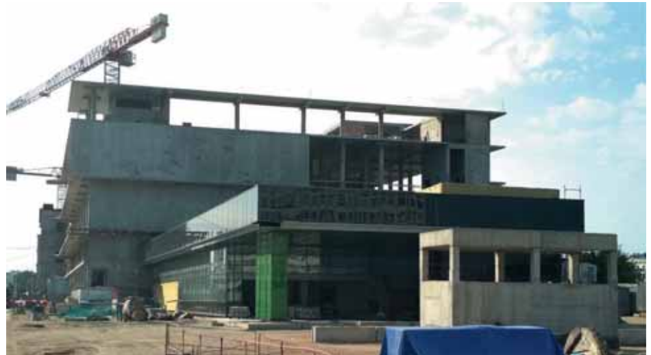
Рис. 12. Здание торгово-развлекательного комплекса и вход на ст. «Вокзальная», 2019 г. В наземном здании закончено сооружение монолитного каркаса. На станции заканчиваются отделочные работы
