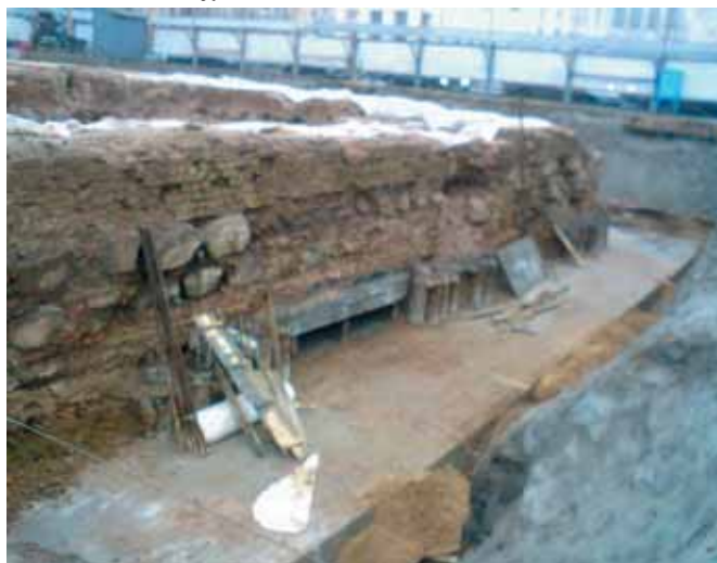
Рис. 4. В местах прохода фундаментной плиты под старыми фундаментами устроены специальные «окна». Сами старые фундаменты укреплены стенками из буронабивных свай
