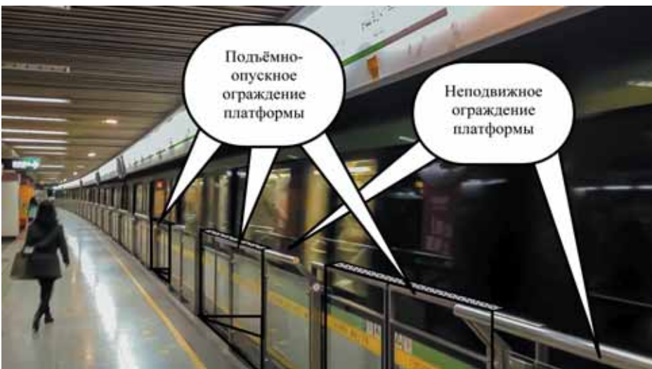
Рис. 3. Ограждение платформы, сочетающее его подъемно-опускные и неподвижные элементы
