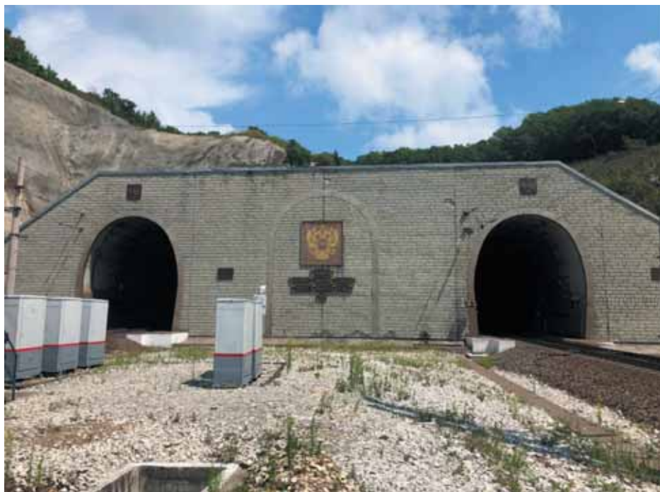
Рис. 1. Большой Новоросийский тоннель
