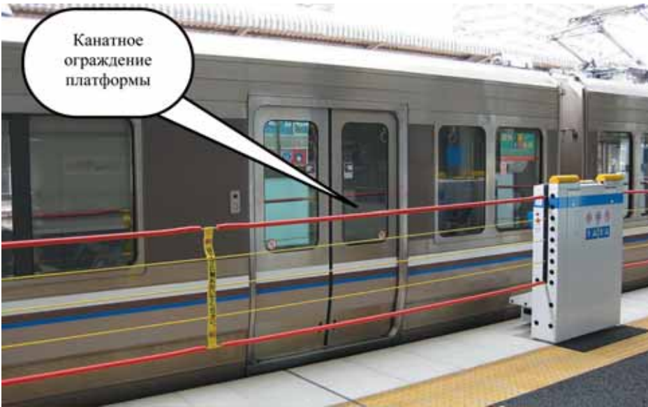
Рис. 2. Ограждение платформы на железнодорожной станции Такацуки (Япония)
