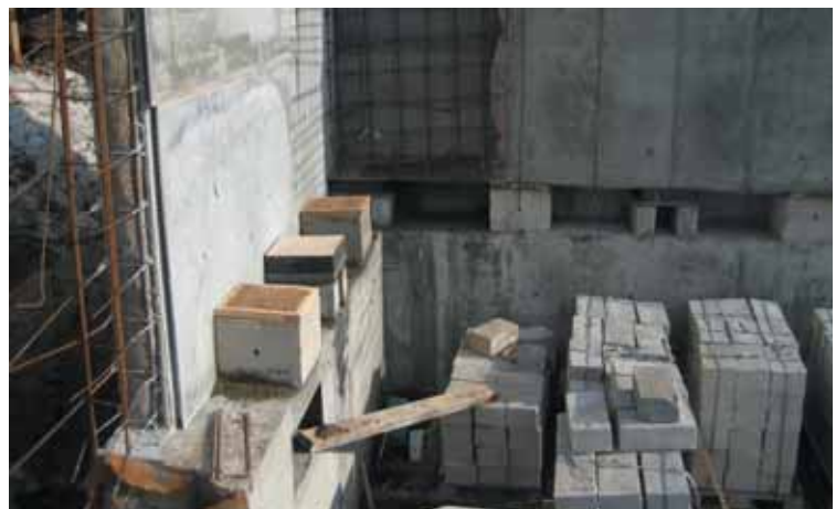
Рис. 5. Установка виброизоляторов. Деревянные рамки, заполненные песком, на страховочных опорах использовались для равномерного включения в работу виброизоляторов. Каждый виброизолятор установлен на стальной пластине и лежит на двух небольших бетонных блоках. При необходимости замены виброизолятора между блоками может быть размещен домкрат
