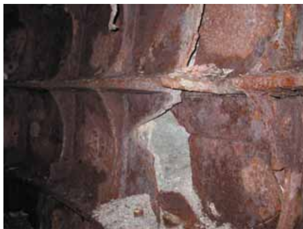
Рис. 1. Повреждение отделки вентиляционного ствола из-за замерзания воды за отделкой в зимний период
