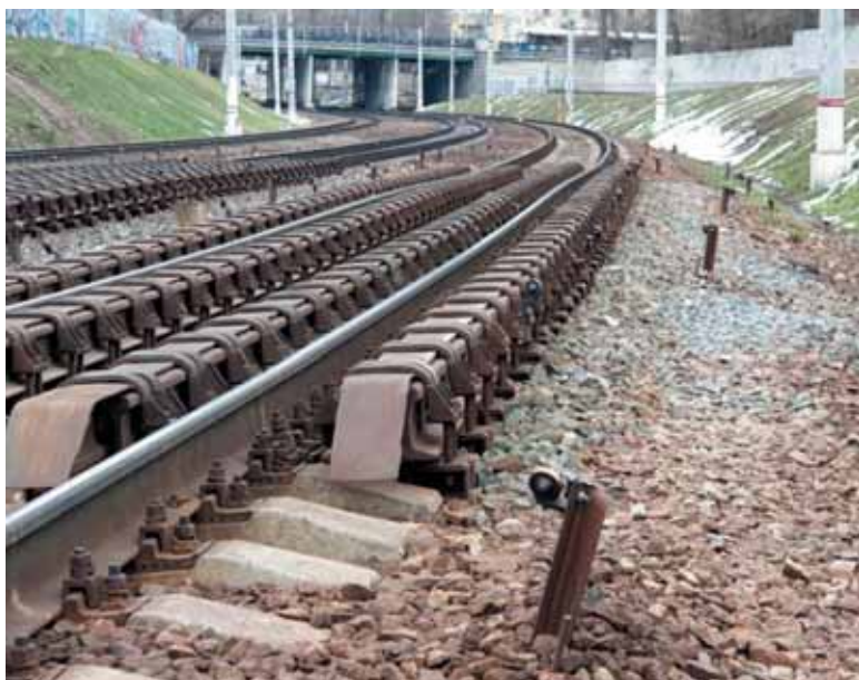
Рис. 5. Установка деформационных знаков
