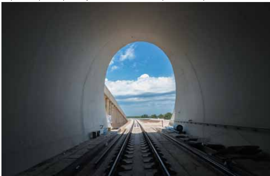
Устройство верхнего строения пути в одном из тоннелей «Чортановцы» в Сербии
