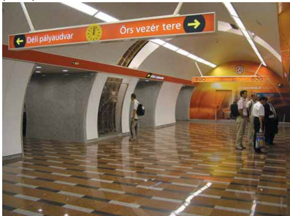
Рис. 6. Пилонная станция «Келети пайаудвар» («Восточный вокзал») в Будапеште [ metros.hu ]
