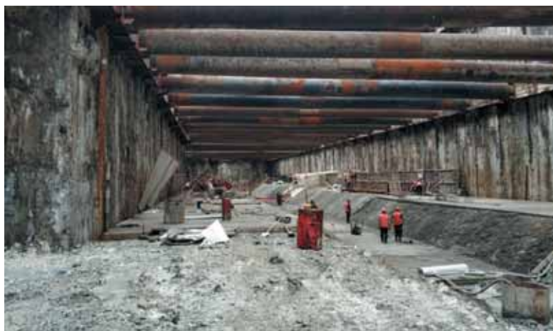
Рис. 7. Общий вид сухого котлована после экскавации
