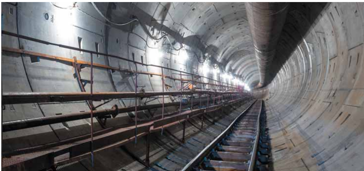
Строительство правого перегонного тоннеля между станциями «Лианозово» и «Физтех» Люблинско-Дмитровской линии
