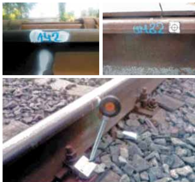
Рис. 6. Установка деформационных марок для наблюдения за рельсовыми нитями на одной точке пересечения
