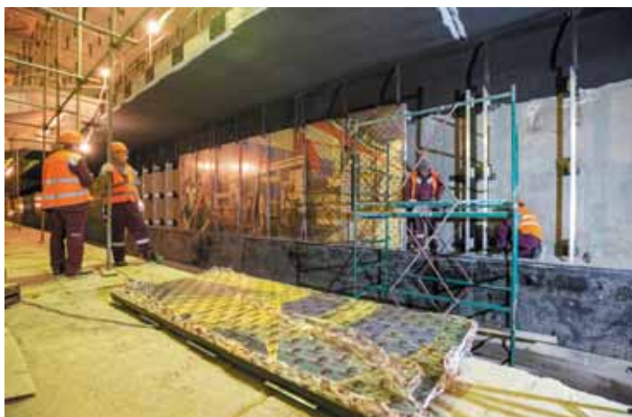
Монтаж панелей на путевой стене станции «Сокольники» БКЛ
